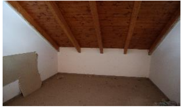
Viste interne del deposito - sub. 12
