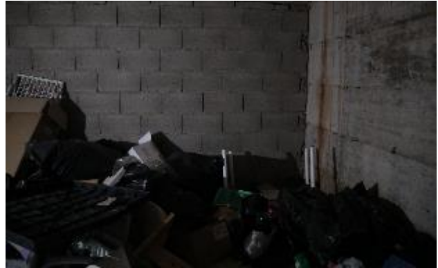
Viste interne del box auto - sub. 20
