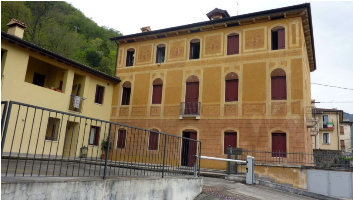
Vista intero edificio fronte sud-est
