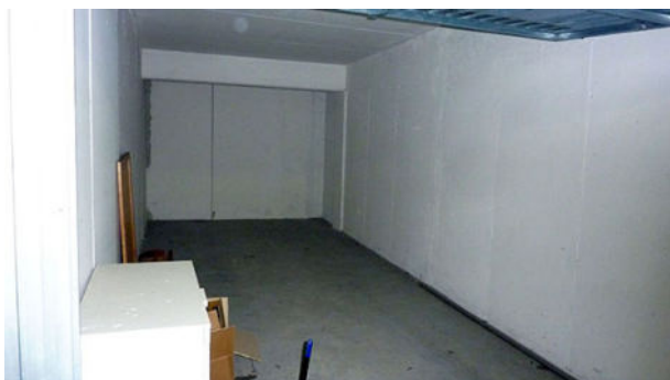
VISTA 8 autorimessa (sub 9)
