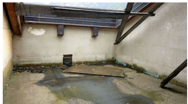
VISTA 4 terrazza (sub 25)
