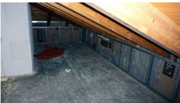
VISTA 3 sottotetto (sub 25)
