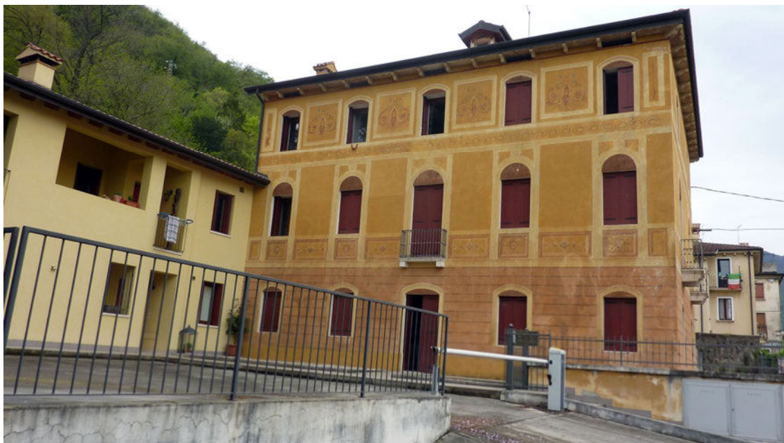
Vista intero edificio fronte sud-est
