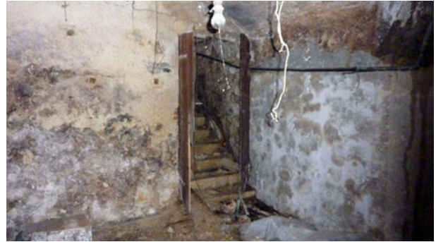
VISTA 8 cantina (sub 22)
