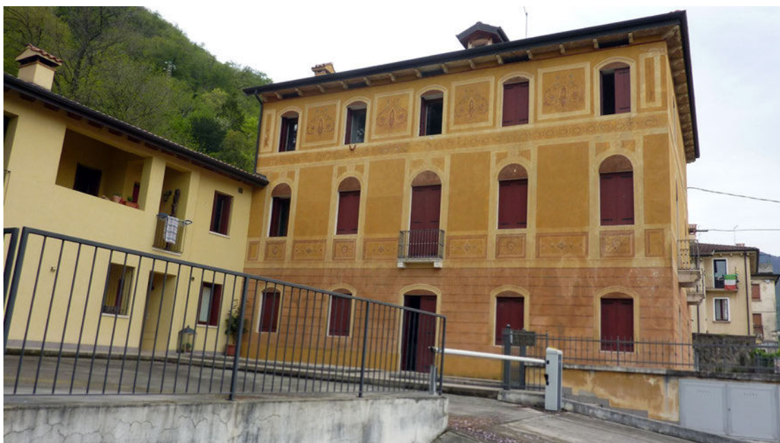
Vista intero edificio fronte sud-est
