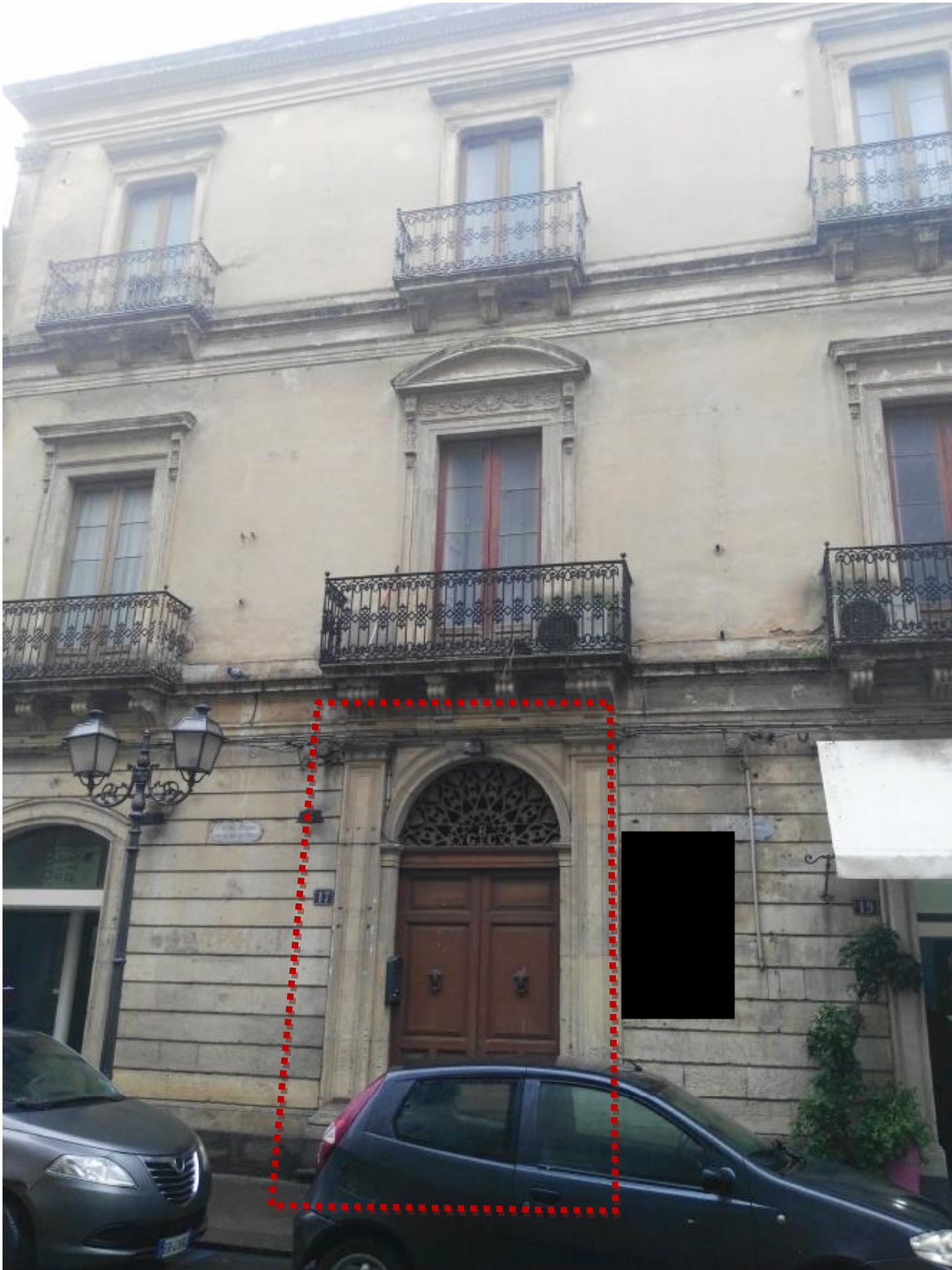
Foto 1 Portone d'ingresso su Corso Vittorio Emanuele 17
