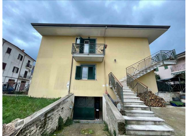
Ingresso al garage e scala ingresso appartamento
