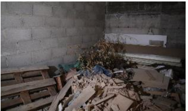
Viste interne del box auto - sub. 42
