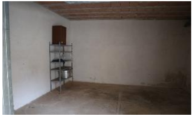
Viste interne del box auto - sub. 48
