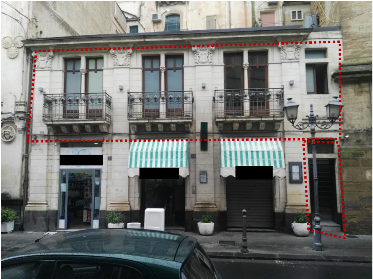
Foto 1 Prospetto su Corso Vittorio Emanuele n. 12
