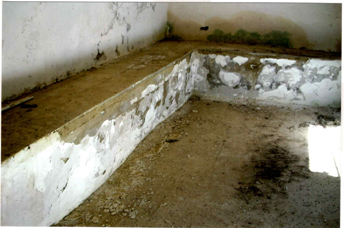
Interno del fabbricato
