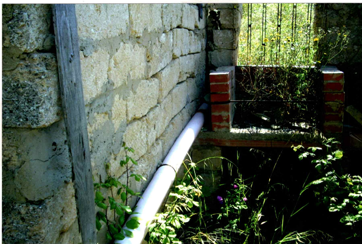
acqua del fabbricato
