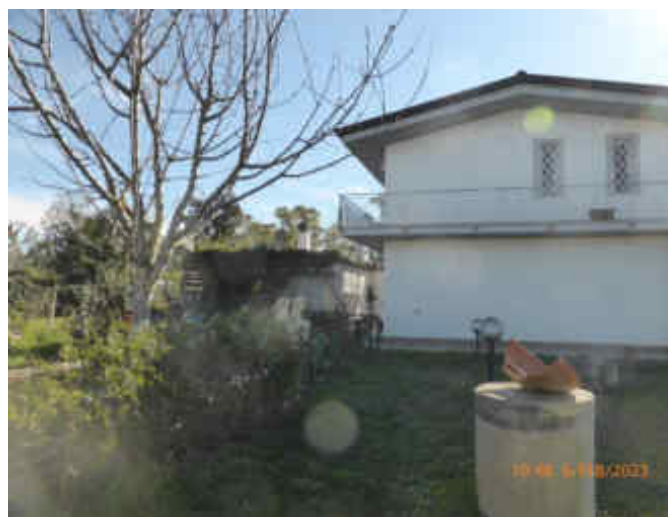
Vista lato parte lato Ovest
