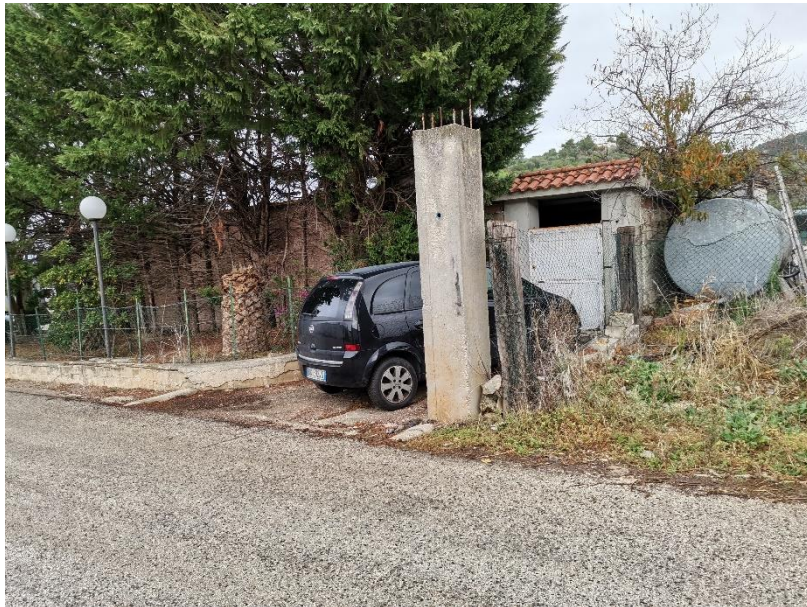
Il fabbricato in cui è ubicato il pozzo in p.lla 415
