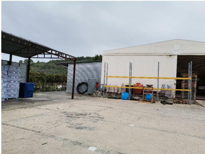
Le tettoie realizzate sulla p.lla 415
