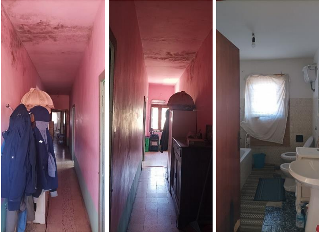
CORRIDOIO E BAGNO
