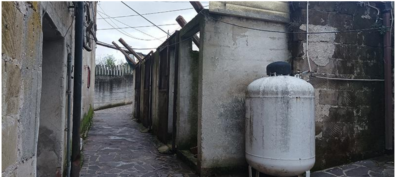
VISTA DA SUD – LOCALI STALLA SCOPERTI
