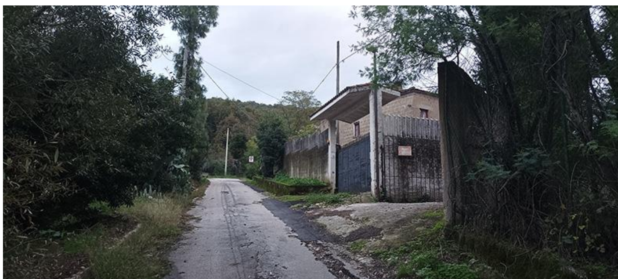
VISTA DEGLI ACCESSI DALLA STRADA
