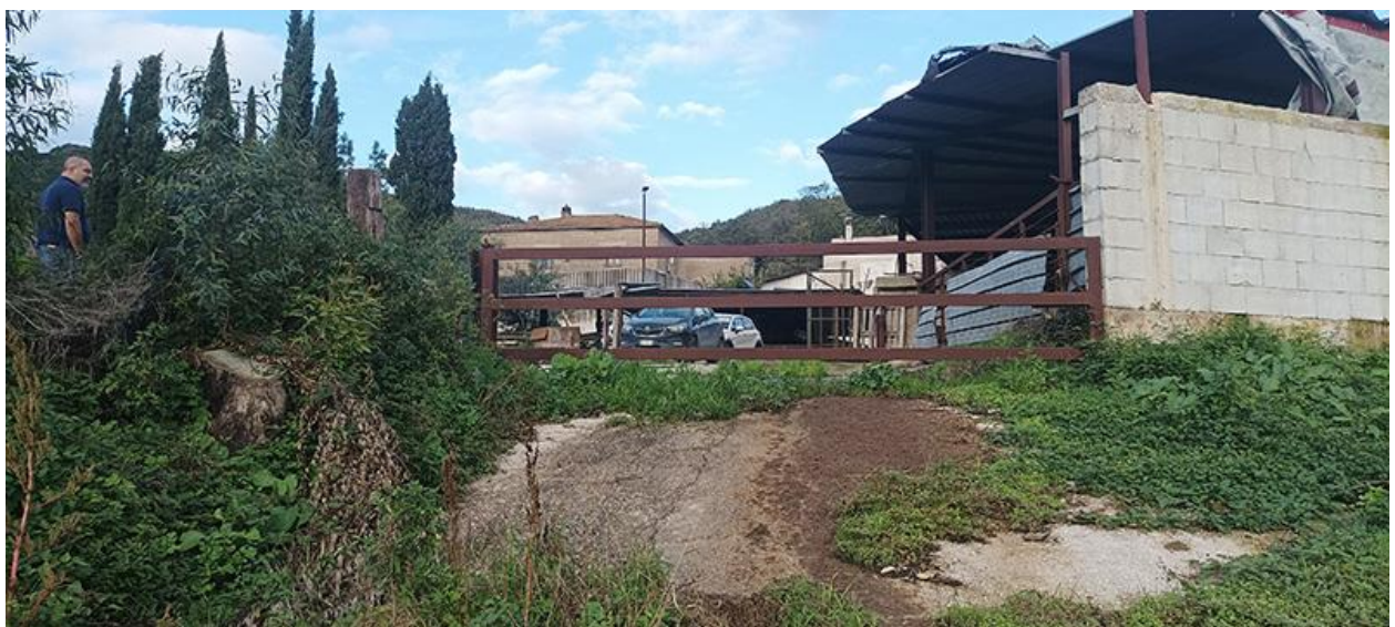
TERRENO A SUD-EST DELL'AREA
