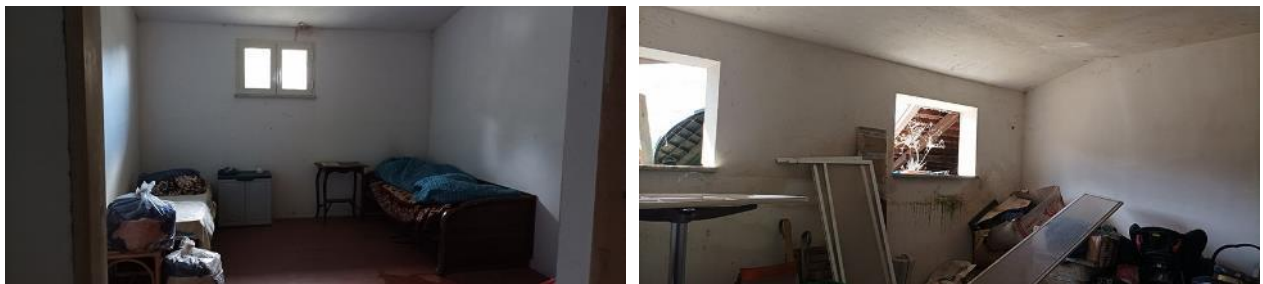
LOCALI DELL'UNITA' IN CORSO DI REALIZZAZIONE
