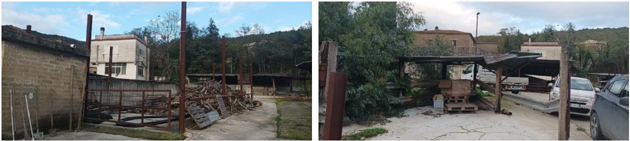
MANUFATTI IN FASE DI REALIZZAZIONE E DI ABBANDONO
