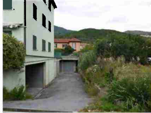
rampa di accesso ai box interrati mappali 673 e 694 e strette strisce di terreno adiacente mappali 674 - 695
