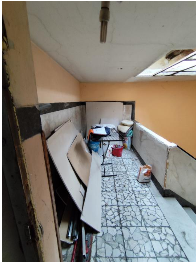
20) ACCESSO CONDOMINIALE SOFFITTA
