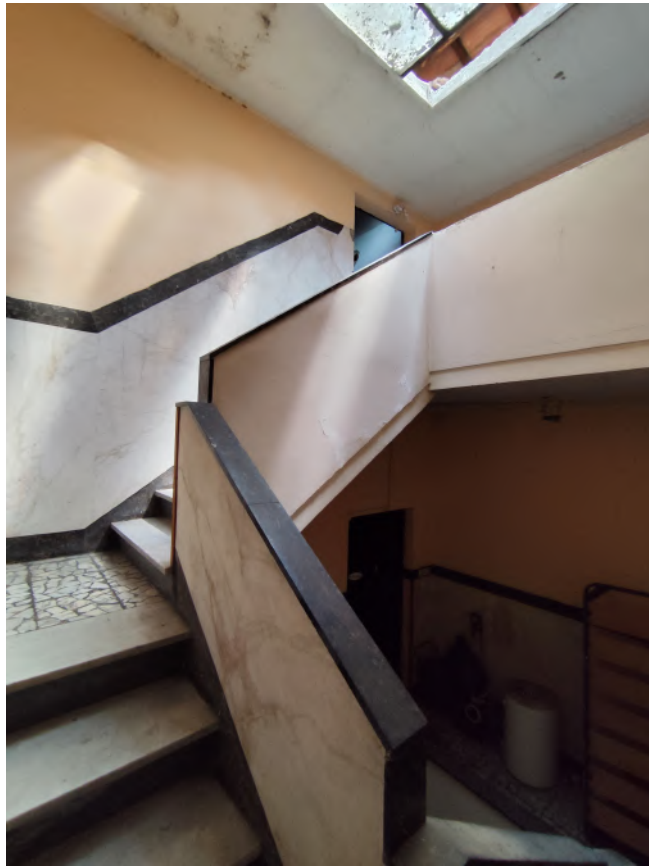
19) ACCESSO CONDOMINIALE SOFFITTA
