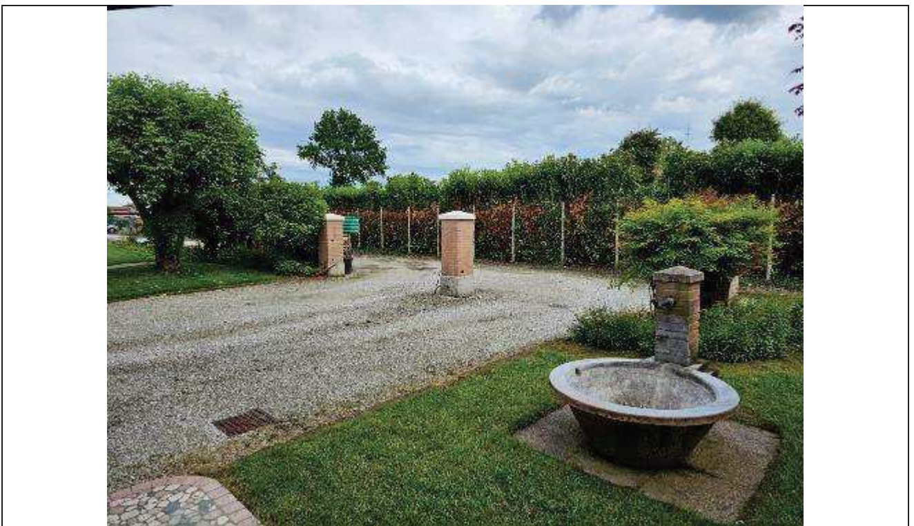
20 Vista dell'ingresso carrabile (privo dei cancelli) alla proprietà esecutata – si nota inoltre la mancanza della delimitazione tra le due proprietà;
