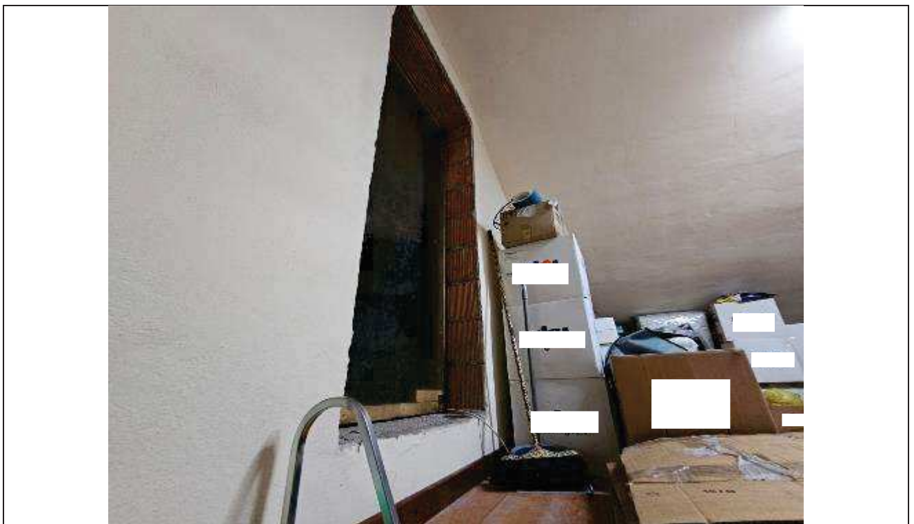
54 Vista dell'ingresso dal soppalco al sottotetto non abitabile, ricavato nella porzione sovrastante la porzione abitativa dell'immobile;
