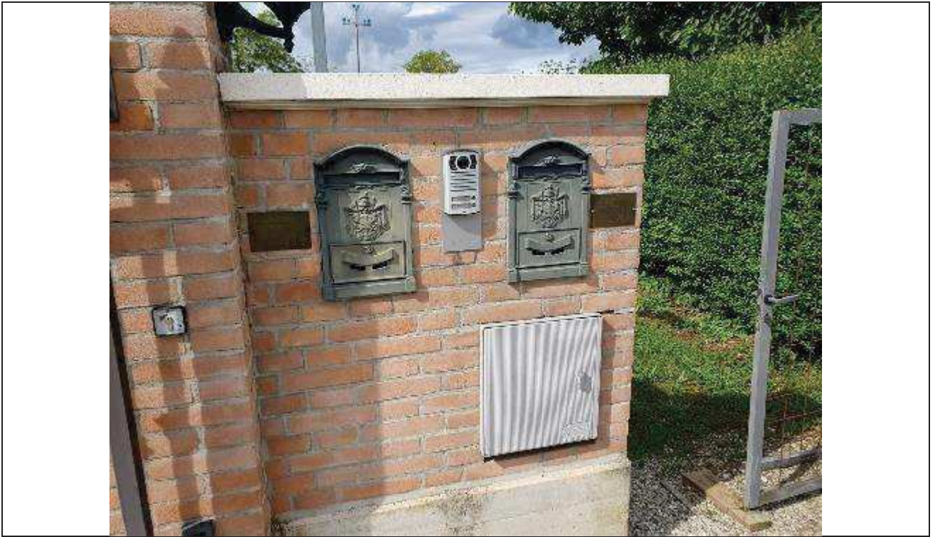
03 Vista della recinzione lungo il fronte stradale;
