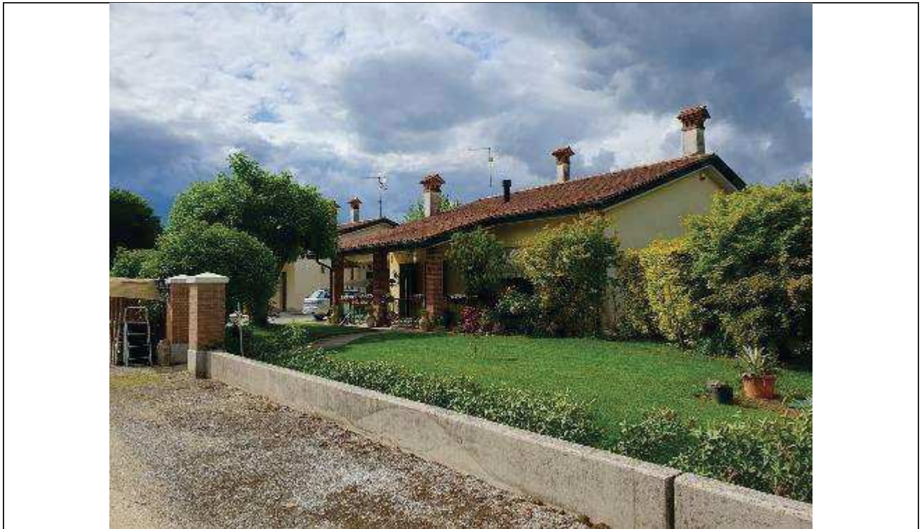
05 Vista dell'immobile bifamiliare dalla stradina comune;
