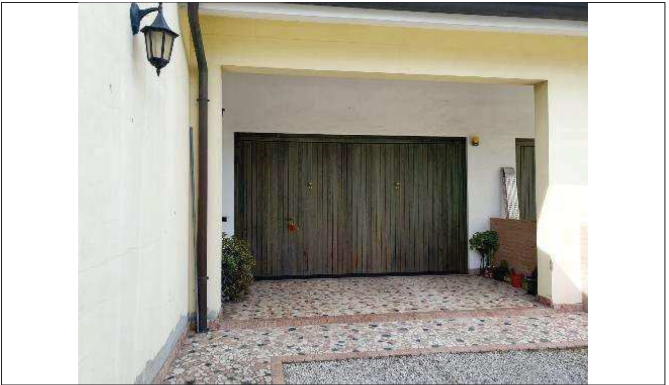
49 Vista esterna sul basculante di accesso all'autorimessa;
