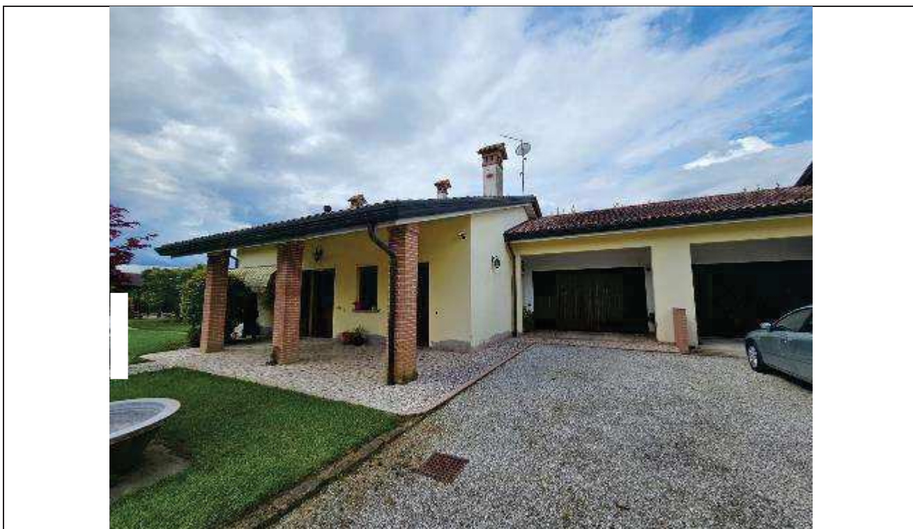
21 Vista del prospetto Sud dell'unità oggetto di valutazione;
