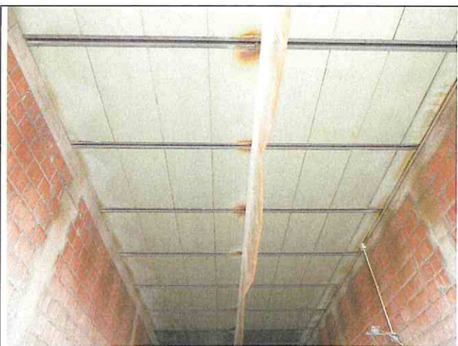
Foto n°148: Controsoffitto camera di incubazione
