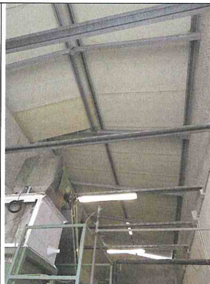
Foto n°106: Vista della copertura
