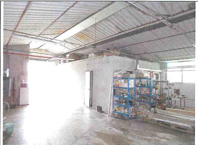
Foto n°77: Vista edificio uffici e servizio igienico interno
