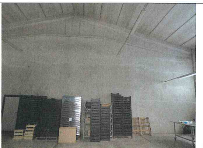
Foto n°139: Interno ricovero prodotti agricoli
