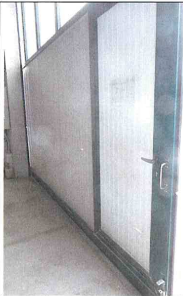
Foto n°142: Accesso da est
