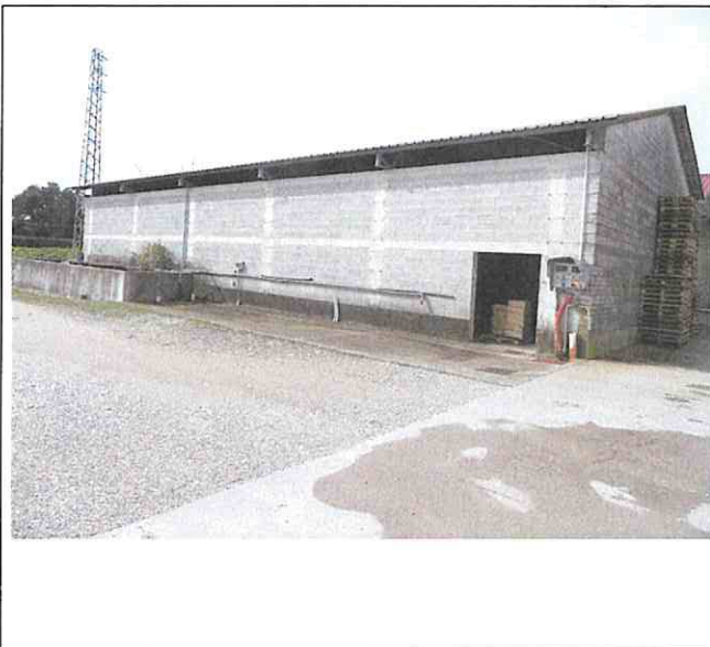
Foto n°122: Vista est edificio E
