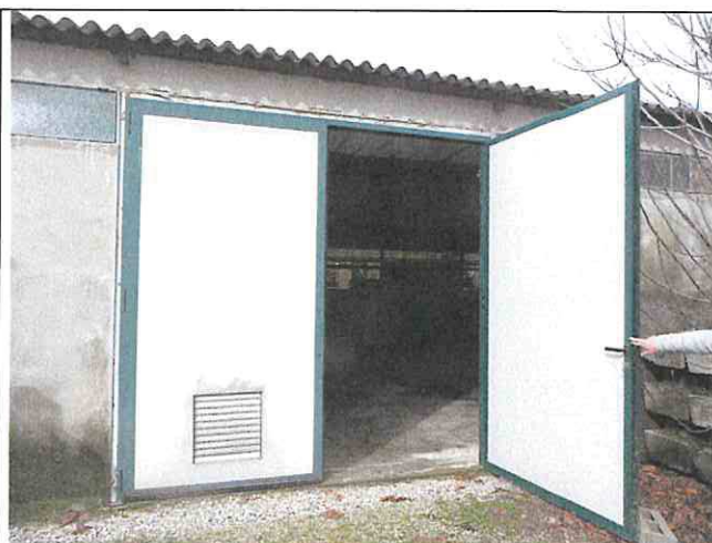
Foto n°47: Ultimo dei tre ingressi ad est alle fungaie
