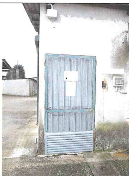
Foto n°71: Accesso alla C.T.
