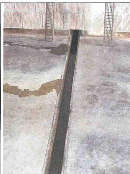
Foto n°152: Particolare smaltimento acque
