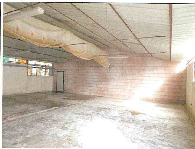
Foto n°53: Vista interna seconda fungaia
