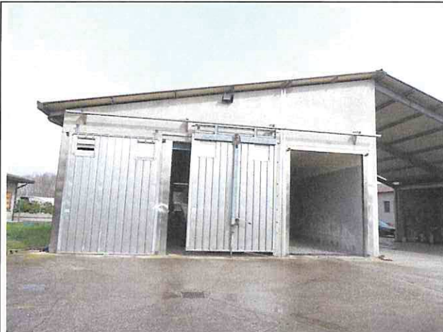
Foto n°112: Vista sud edificio B con porzione ad est sub. 3
