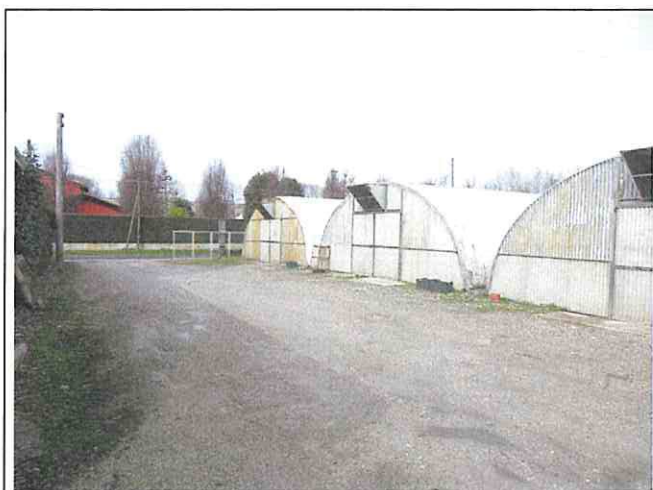
Foto n°170: Serre su mappale 140
