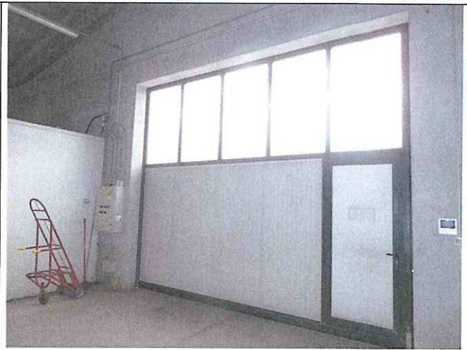
Foto n°129: Interno ricovero prodotti agricoli
