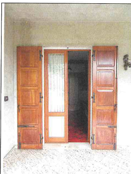
Foto n°28: Ingresso principale all'unità
