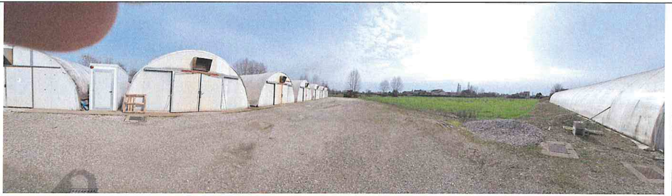
Foto n°165: Vista panoramica serre su mappale 1003 e 228
