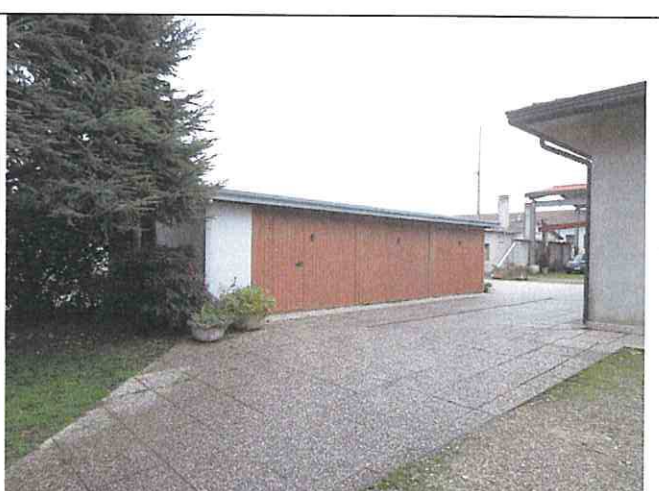
Foto n°11: Edificazione abusiva non considerata nella stima
