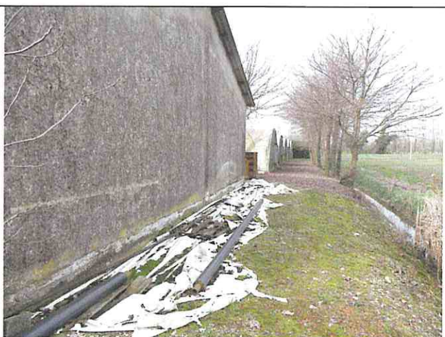
Foto n°44: Prospetto nord, vista estremità mapp. 140
