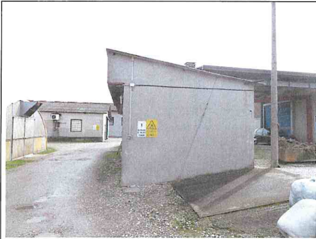
Foto n°93: Vista ovest Corpo C
