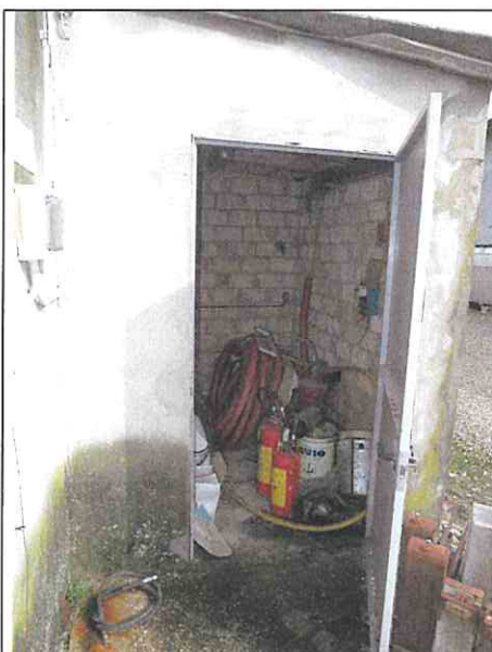
Foto n°72: Accesso allo ripostiglio a sud-est
