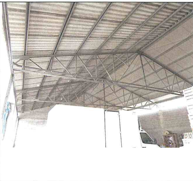
Foto n°120: Copertura edificio E
