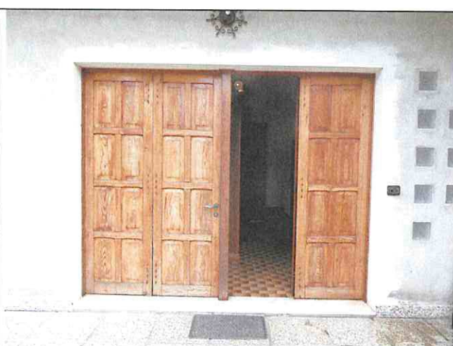
Foto n°17: Ingresso al locale sgombero
