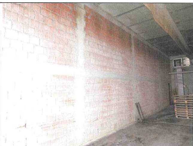
Foto n°149: Murature divisorie camera di incubazione
