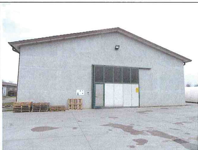
Foto n°126: Facciata sud edificio G
