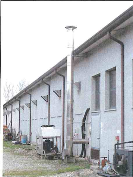
Foto n°128: Particolare prospetto ovest – C.T.
