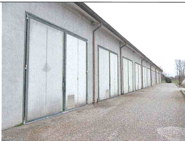
Foto n°144: Vista accessi camere di incubazione
