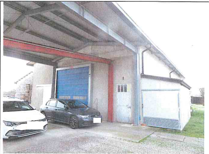
Foto n°94: Edificio B con tettoia a connettivo
