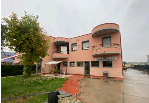
Fronte principale dell'edificio
