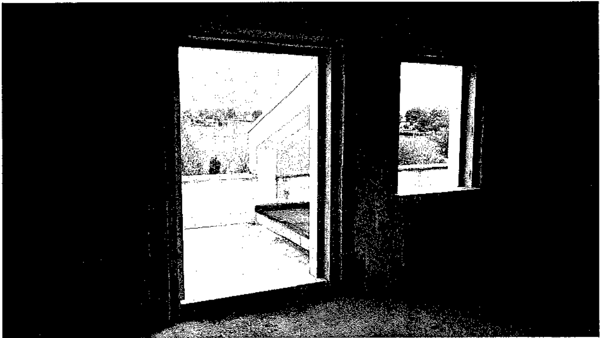
FOTO n°42 - UNITA' "K" - PIANO SECONDO VIA RITA ATRIA, n°147
