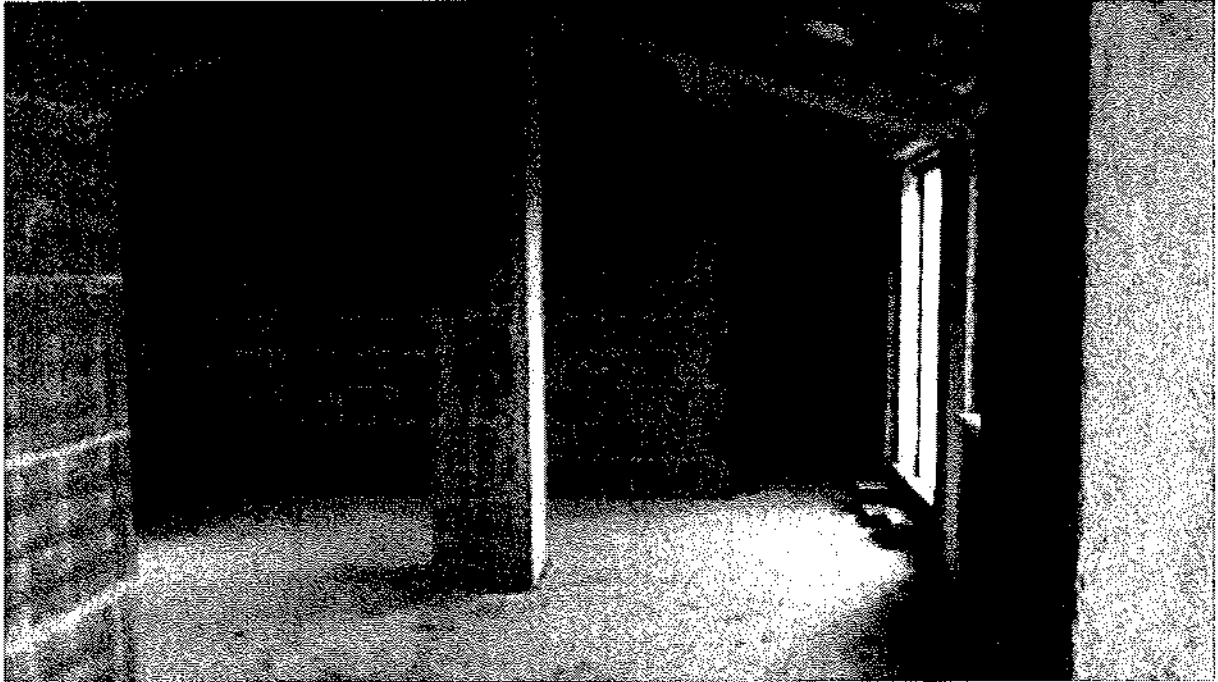
FOTO n°41 - UNITA' "K" - PIANO SECONDO VIA RITA ATRIA, n°147
