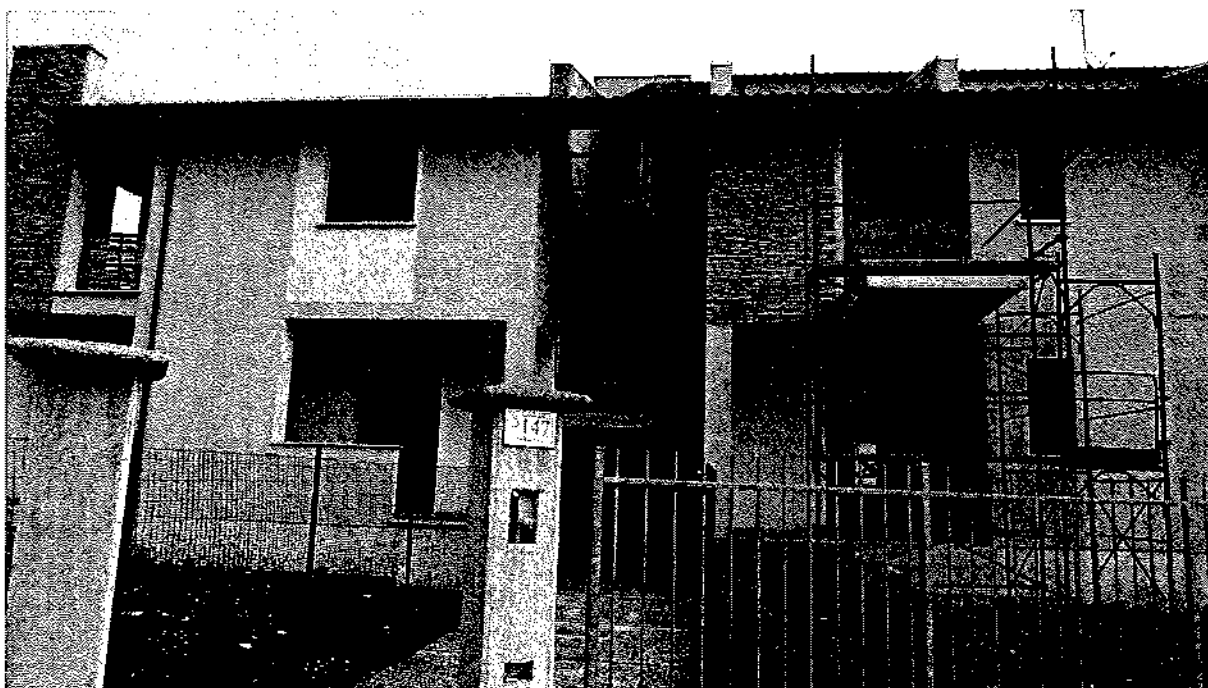
FOTO n°6 - COMPLESSO EDILE di VIA RITA ATRIA, nn°147
