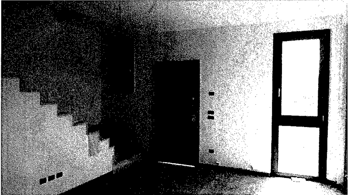
FOTO n°45 - UNITA' "L" - PIANO T VIA RITA ATRIA, n°157
