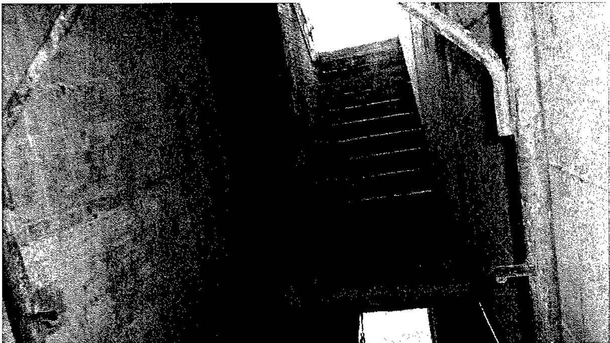
FOTO n°66 – SCALE COMUNI AL PIANO 1°S BOX AUTO - VIA RITA ATRIA, n°147
