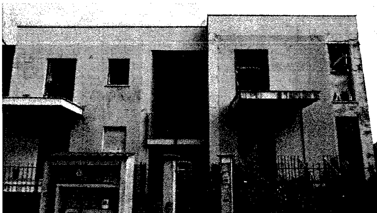
FOTO n°8 - COMPLESSO EDILE di VIA RITA ATRIA, nn°151
