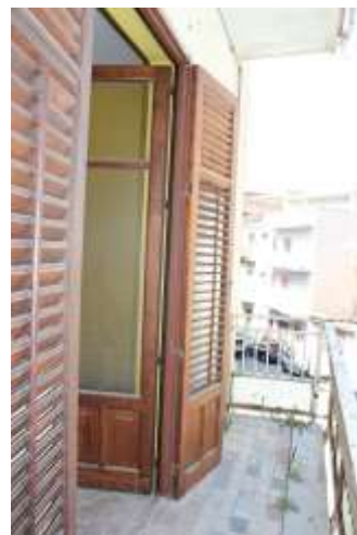
Particolare balconcino su via C. Di Bella
