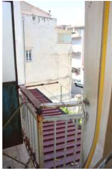
Particolare della porzione di Balconcino
