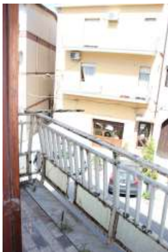
Particolare balconcino su via C. Di Bella
