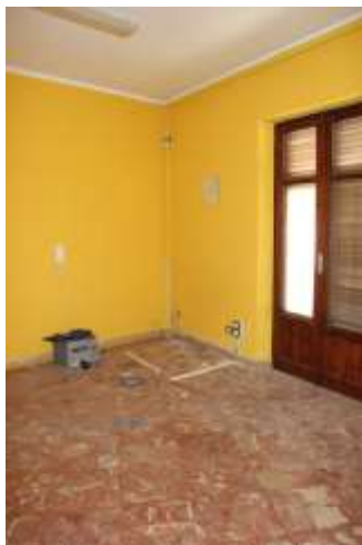
Vano (2) posto a nord-ovest
