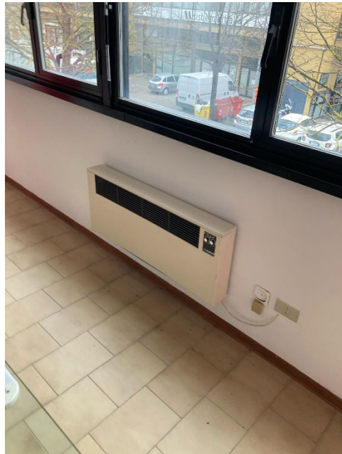
Il termoconvettore
