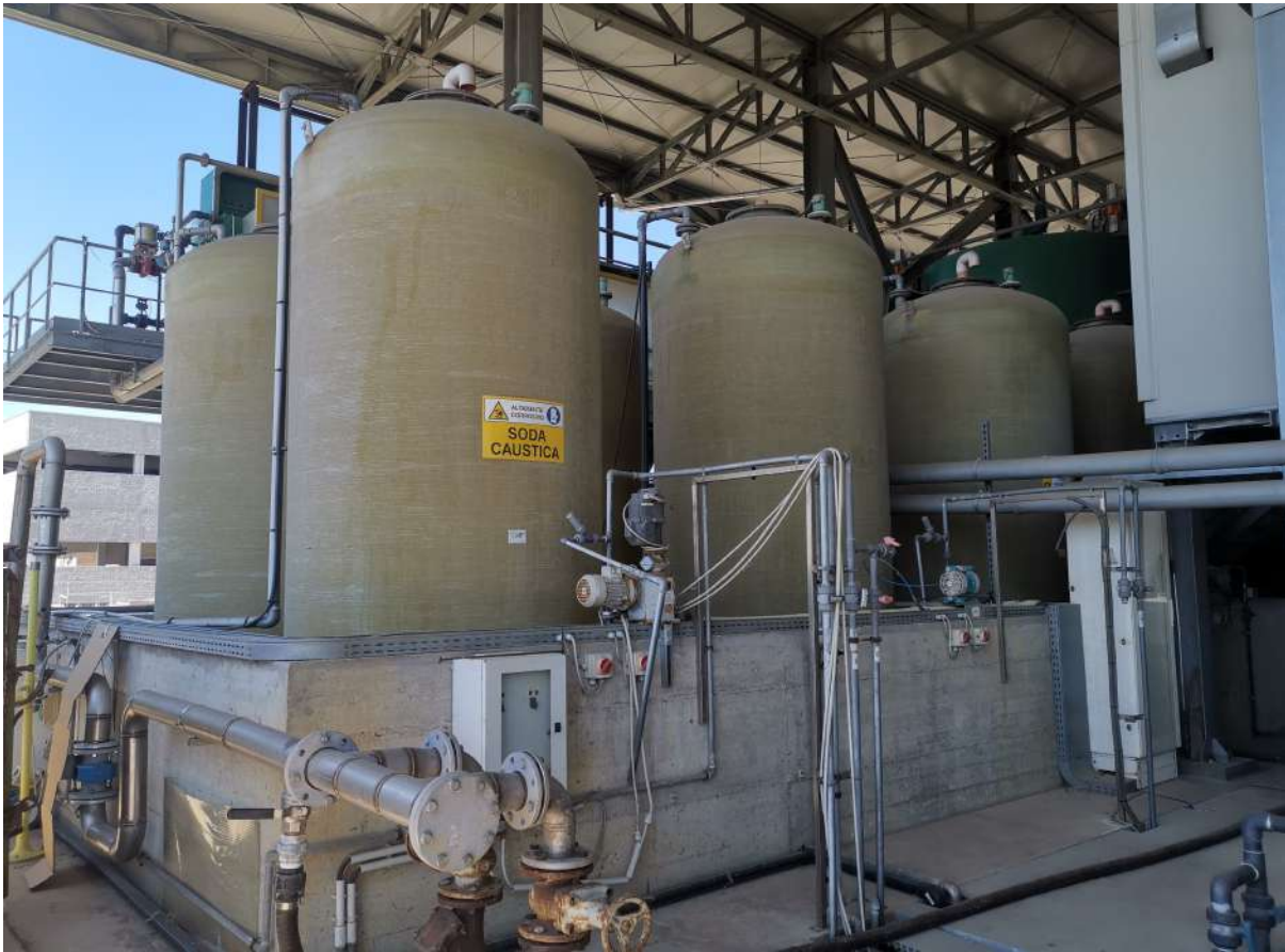
Foto n. 41 _ Sopralluogo 17/06/2020 Capannone CP1: silos stoccaggio materie prime (soda caustica, ecc.)
