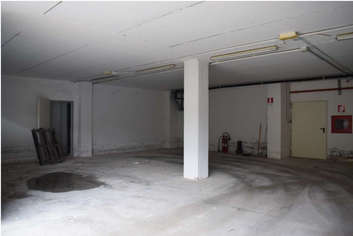
Foto n. 11 _ Sopralluogo 17/06/2020 Palazzina uffici: autorimessa piano seminterrato
