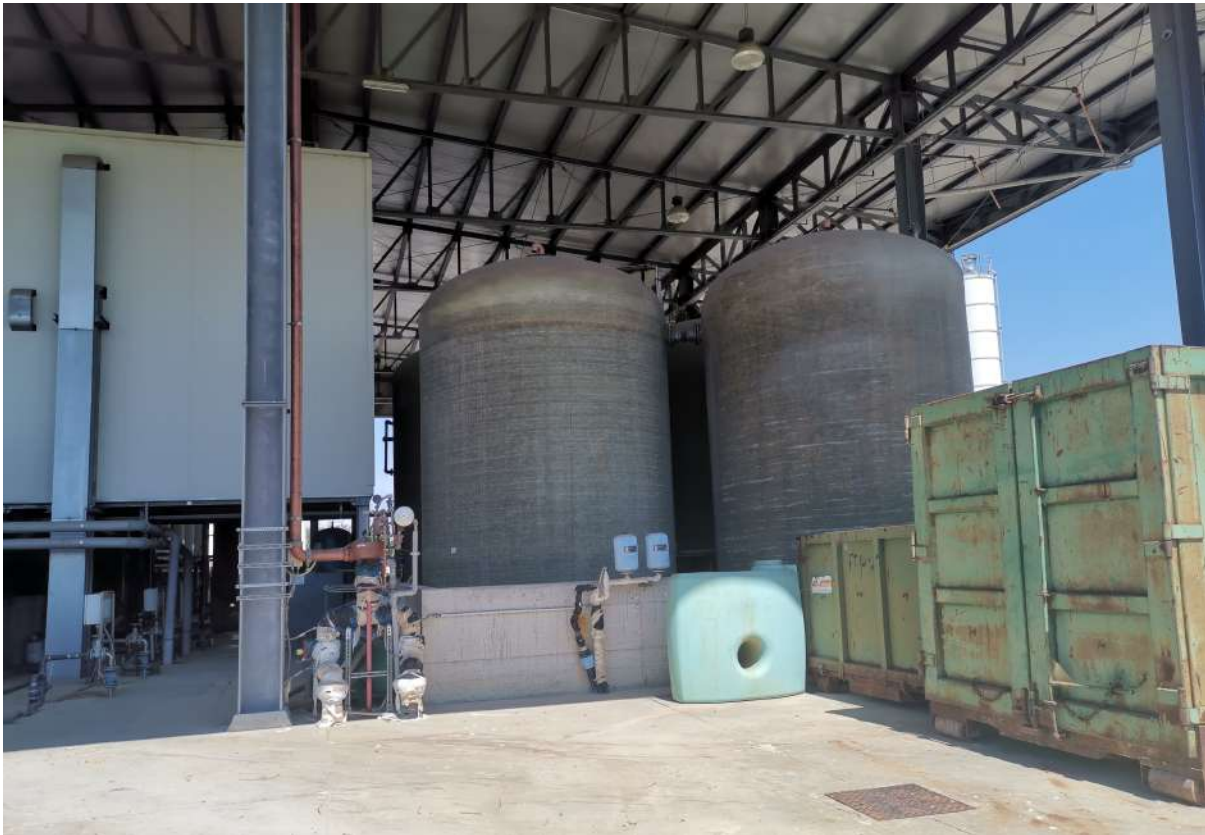
Foto n. 43 _ Sopralluogo 17/06/2020 Capannone CP1: 4 silos (ex biologico diventeranno stoccaggio)
