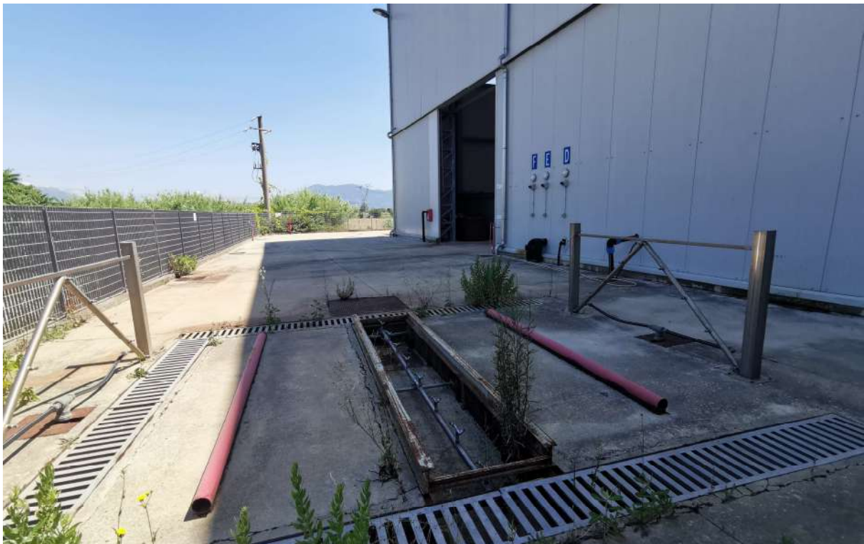
Foto n. 70 _ Sopralluogo 17/06/2020 Capannone CP2: zona lavaggio ruote camion (lato strada)
