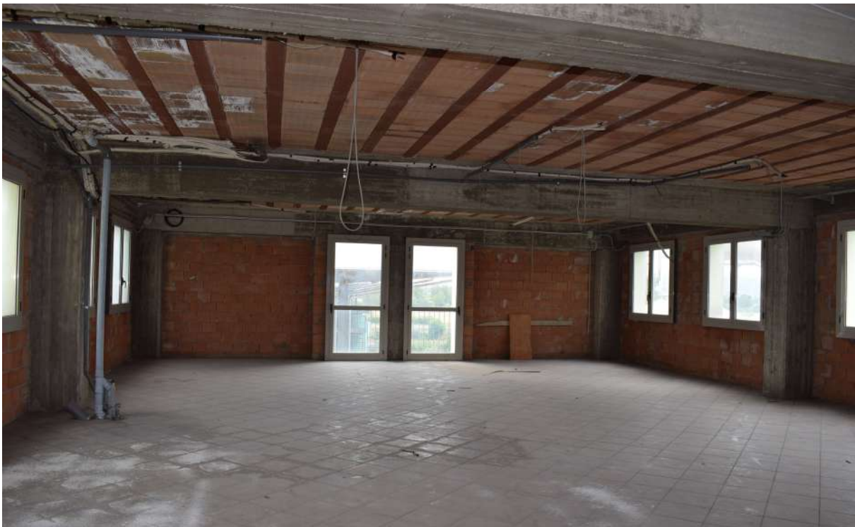
Foto n. 22 _ Sopralluogo 17/06/2020 Palazzina uffici: piano secondo da utimare
