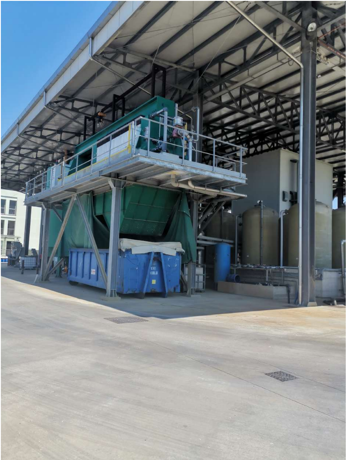
Foto n. 47 _ Sopralluogo 17/06/2020 Fitopressa con tramoggia (300 atm. Pressione) sotto Capannone CP1
