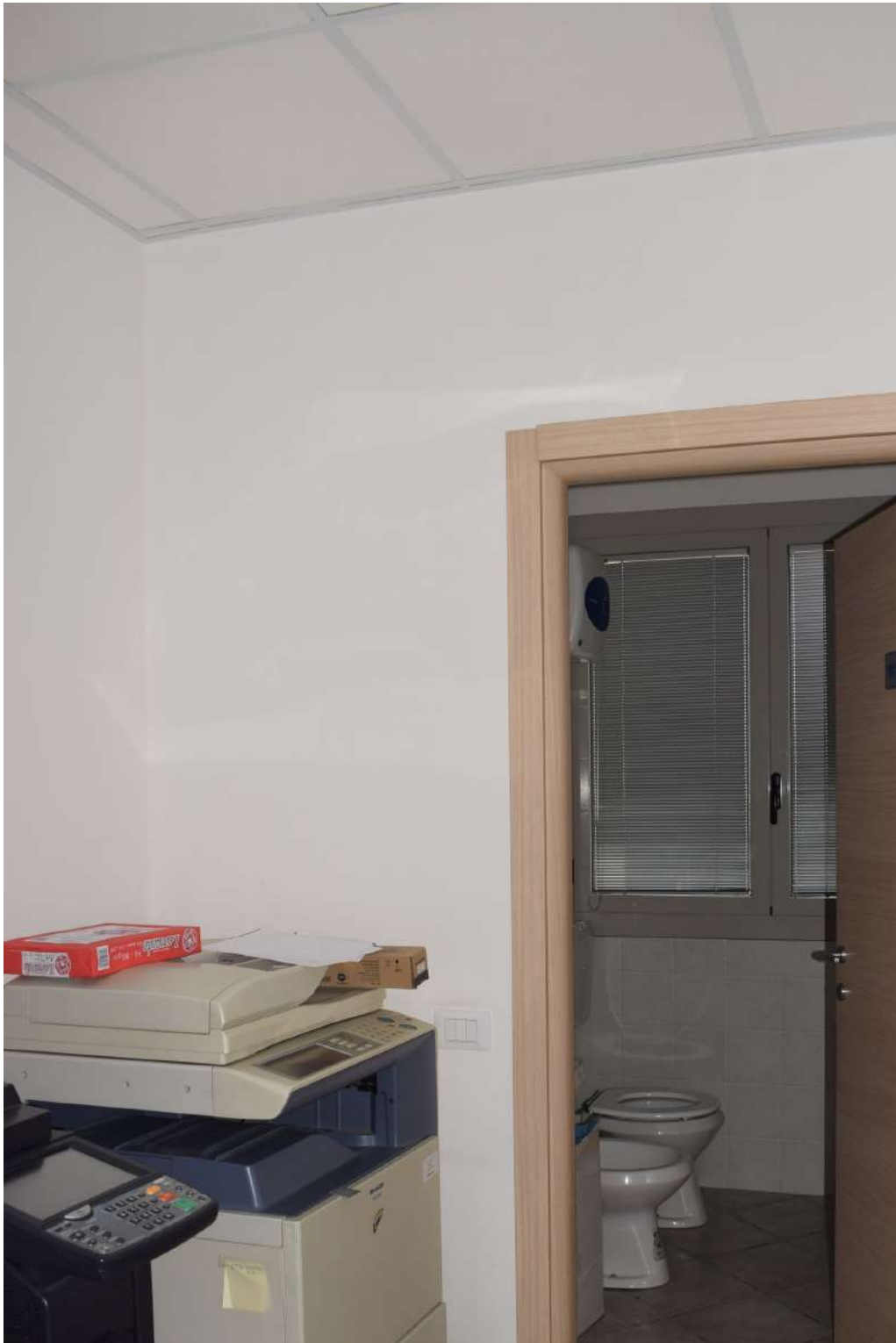
Foto n. 20 _ Sopralluogo 17/06/2020 Palazzina uffici: piano primo, servizio igienico
