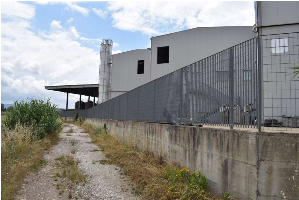
Foto n. 81 _ Sopralluogo 17/06/2020 Lato tergale del capannone 3, visibile percorrendo la stradella vicinale
