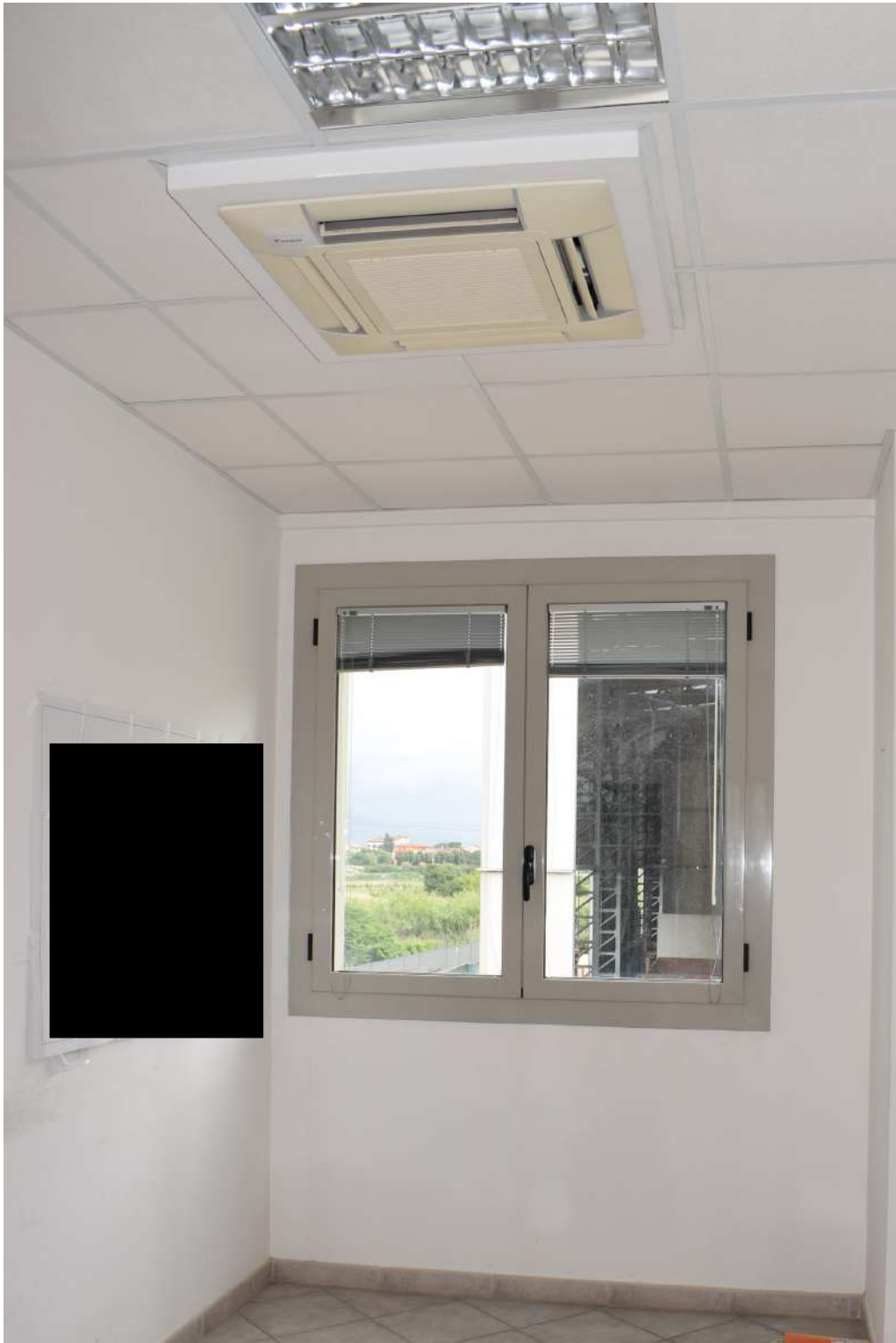
Foto n. 19 _ Sopralluogo 17/06/2020 Palazzina uffici: piano primo, ufficio
