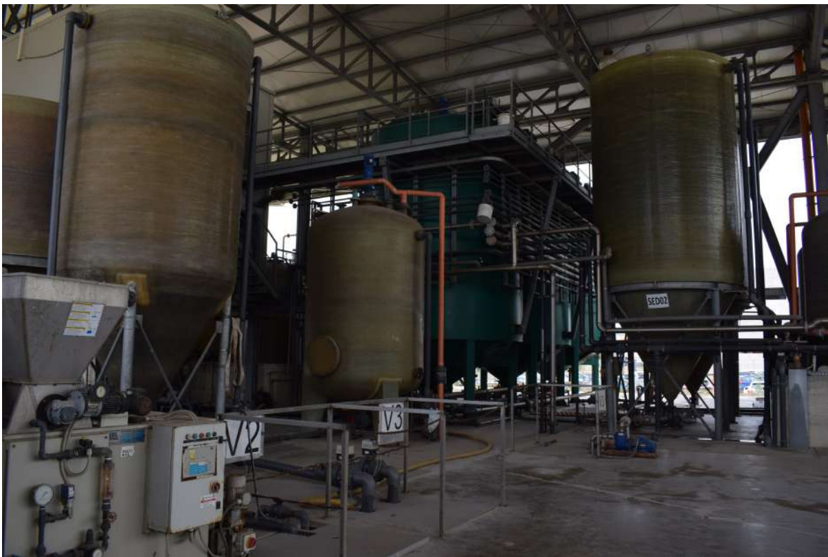
Foto n. 36 _ Sopralluogo 17/06/2020 Vista generale del Capannone CP1 (capannone 4): area destinata a silos per il trattamento rifiuti liquidi pericolosi e non
