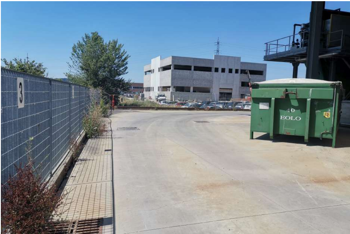
Foto n. 44 _ Sopralluogo 17/06/2020 Il lato tergale del piazzale con la recinzione in orso-grill e la pavimentazione industriale
