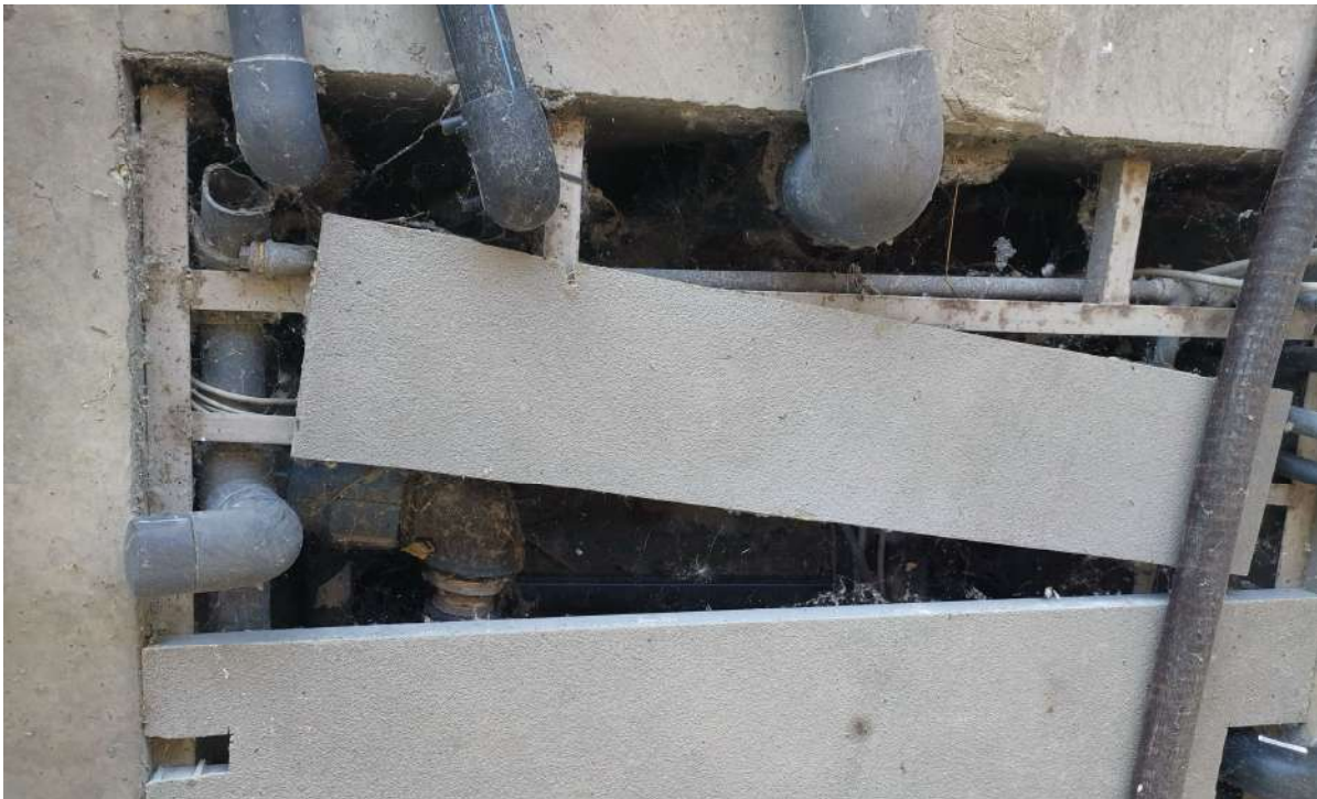
Foto n. 42 _ Sopralluogo 17/06/2020 Capannone CP1: particolare delle tubazioni interrato
