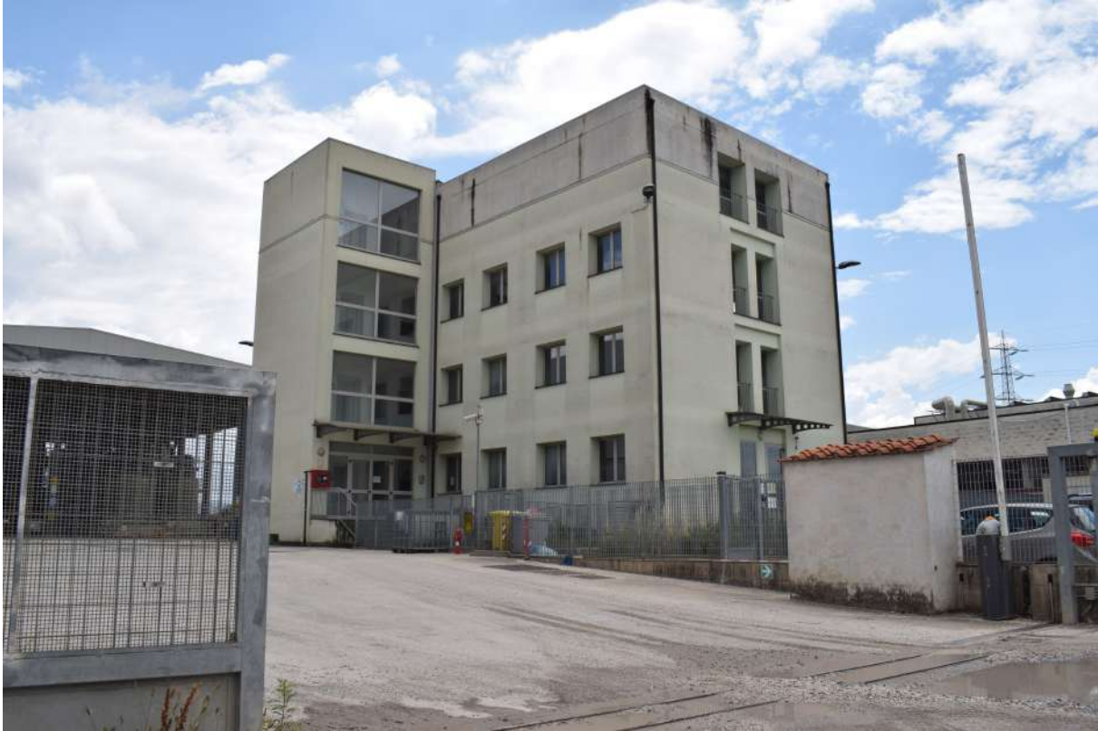
Foto n. 3 _ Sopralluogo 17/06/2020 Palazzina uffici
