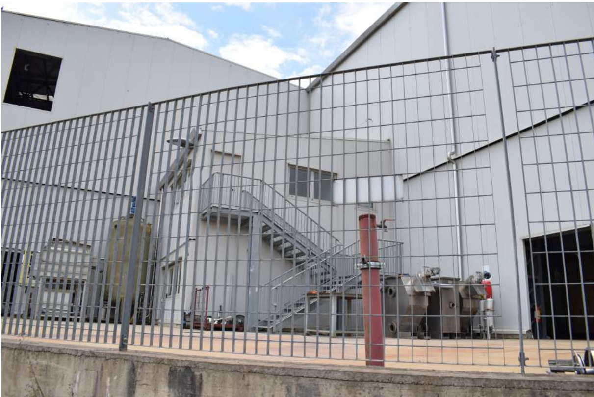
Foto n. 82 _ Sopralluogo 17/06/2020 Lato tergale del capannone 3 con il fabbricato mensa e servizi
