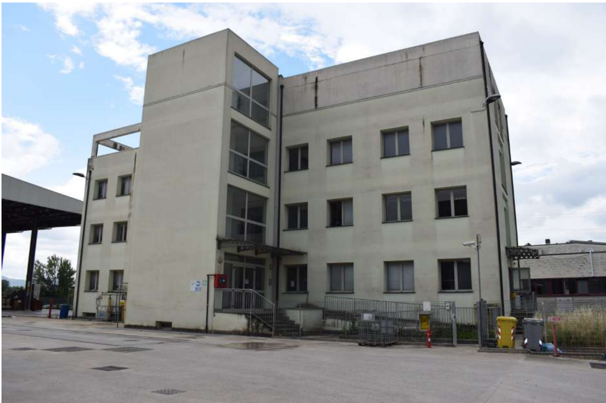
Foto n. 4 _ Sopralluogo 17/06/2020 Palazzina uffici
