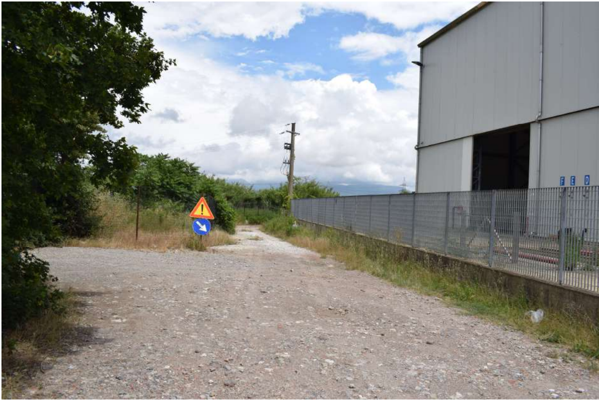
Foto n. 77 _ Sopralluogo 17/06/2020 Lato tergale del capannone 3, visibile percorrendo la stradella vicinale che attraversa il terreno di cui alla part.Ila 907
