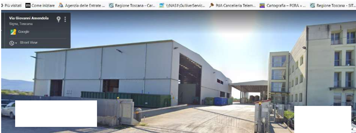
Foto n. 2 _ Foto tratta da Google Maps Vista dell'impianto e della Palazzina uffici da via Amendola
