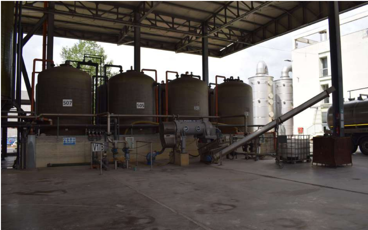
Foto n. 31 _ Sopralluogo 17/06/2020 Capannone CP1 (tettoia): 8 silos stoccaggio
