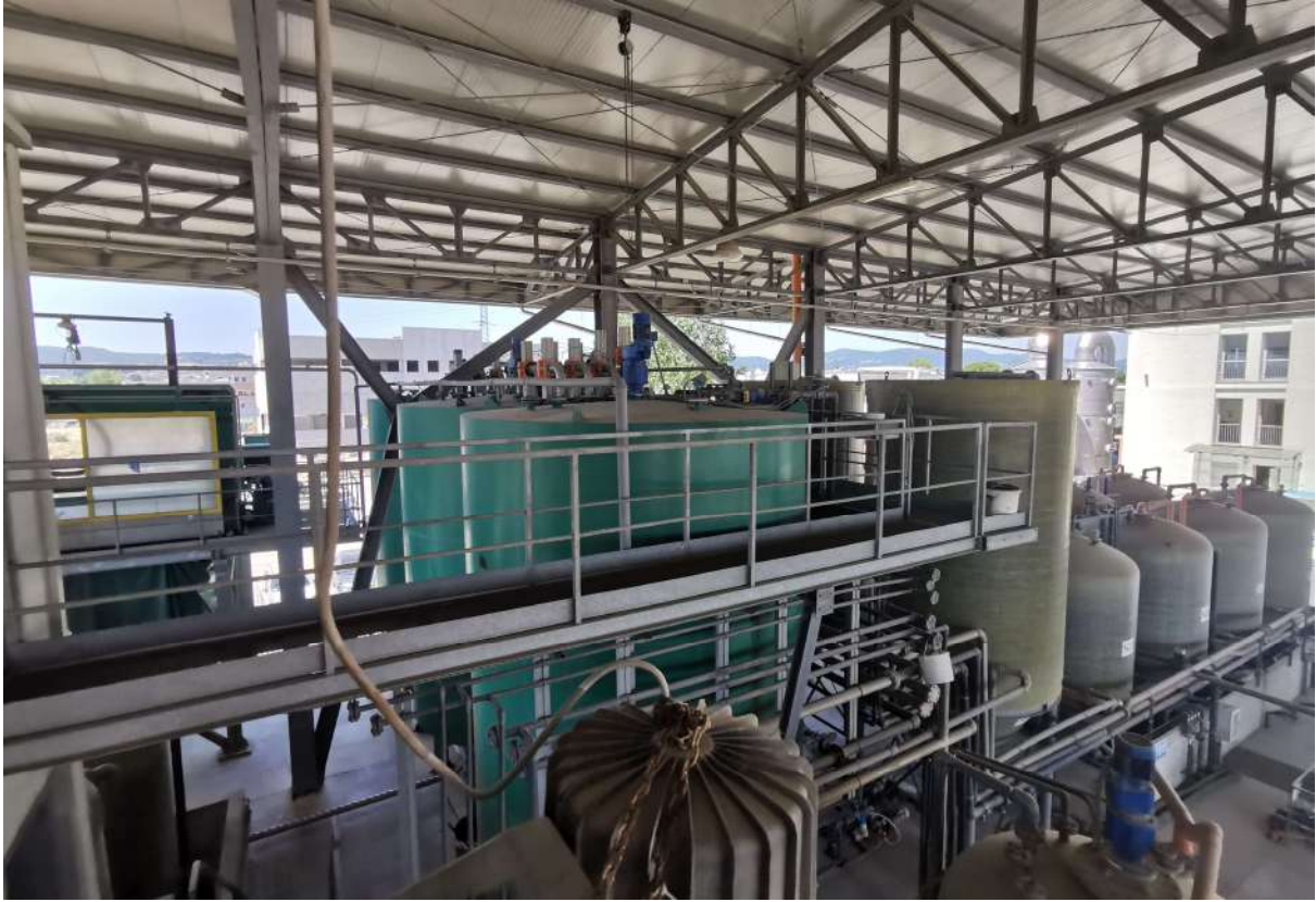
Foto n. 54 _ Sopralluogo 17/06/2020 Capannone CP1: dalla sala controllo vista sui reattori e i serbatoi di stoccaggio
