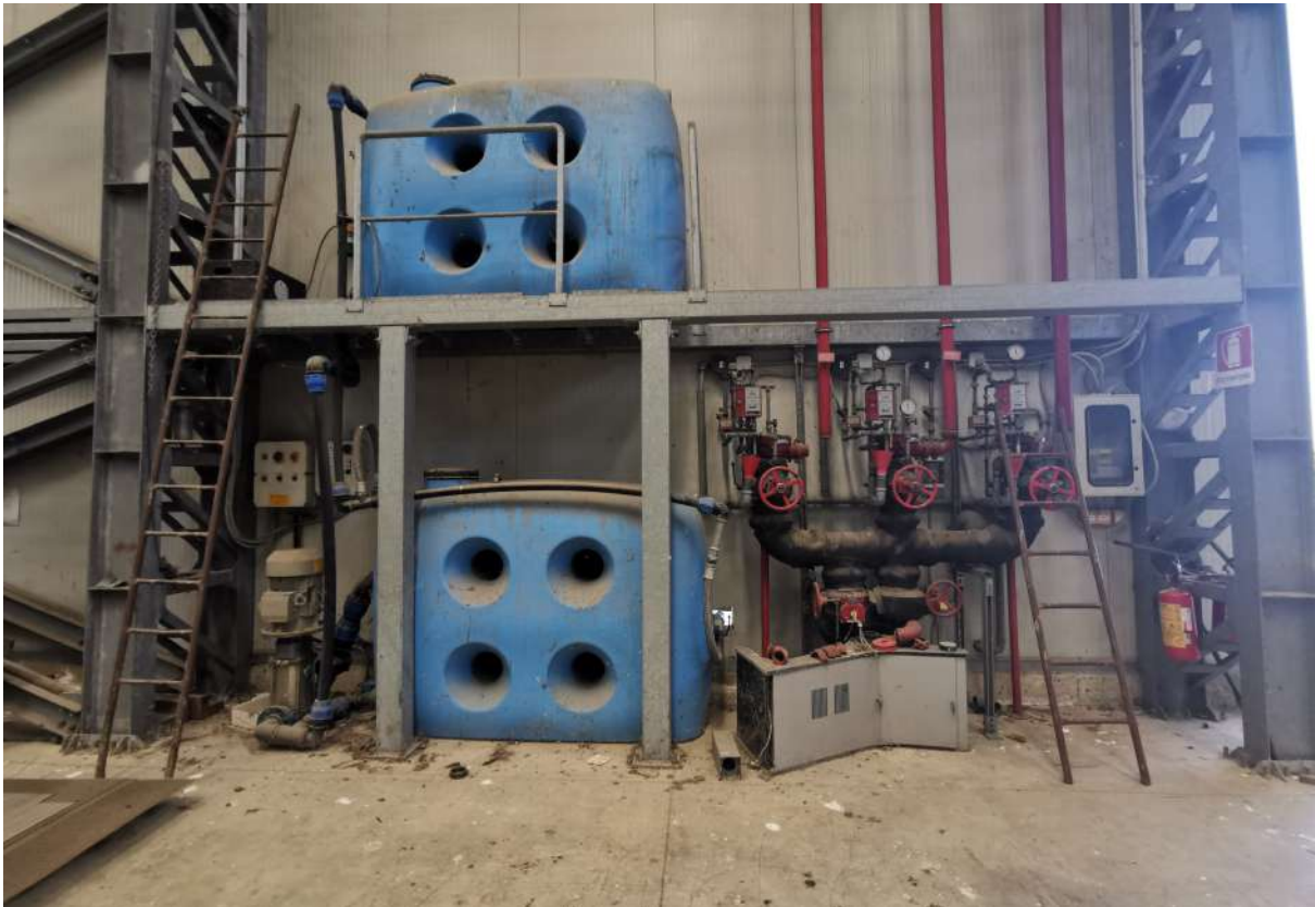
Foto n. 71 _ Sopralluogo 17/06/2020 Capannone CP2: serbatoi e impianto lavaggio ruote camion
