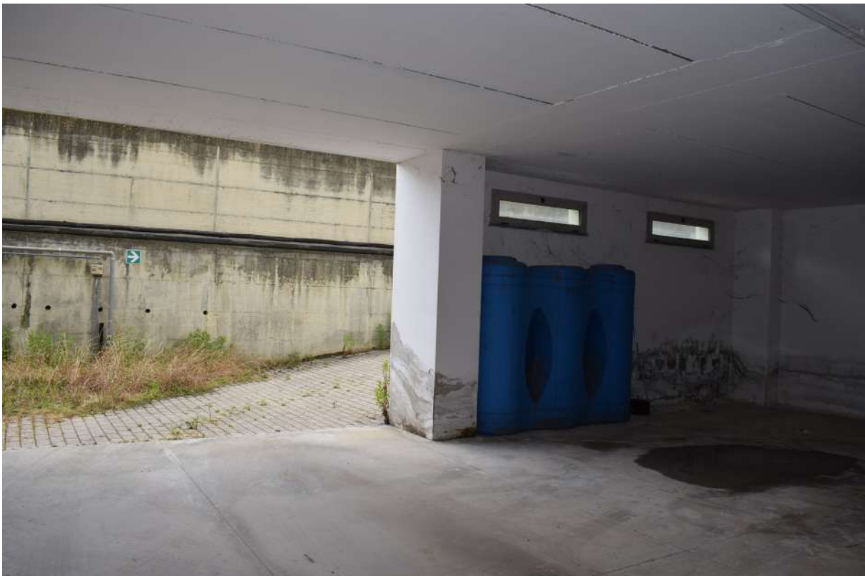
Foto n. 8 _ Sopralluogo 17/06/2020 Palazzina uffici: autorimessa piano seminterrato
