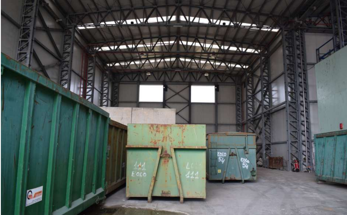
Foto n. 66 _ Sopralluogo 17/06/2020 Capannone CP2
