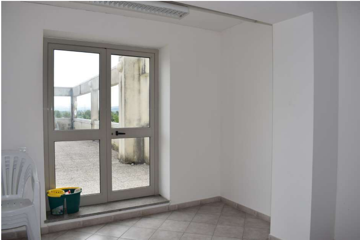
Foto n. 25 _ Sopralluogo 17/06/2020 Palazzina uffici: piano terzo, la porta finestra per accedere alla terrazza
