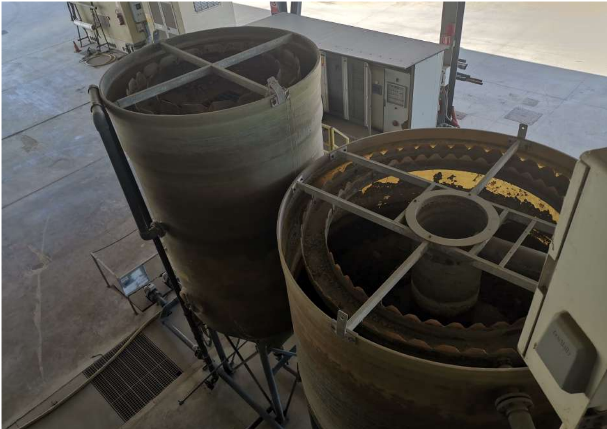
Foto n. 49 _ Sopralluogo 17/06/2020 Capannone CP1: Silos sedimentazione (ora disattivati) visti dall'alto
