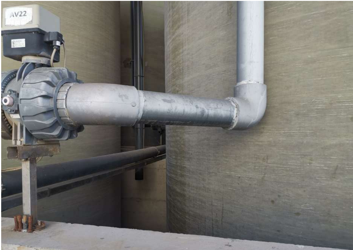
Foto n. 33 _ Sopralluogo 17/06/2020 Capannone CP1 (tettoia): particolare
