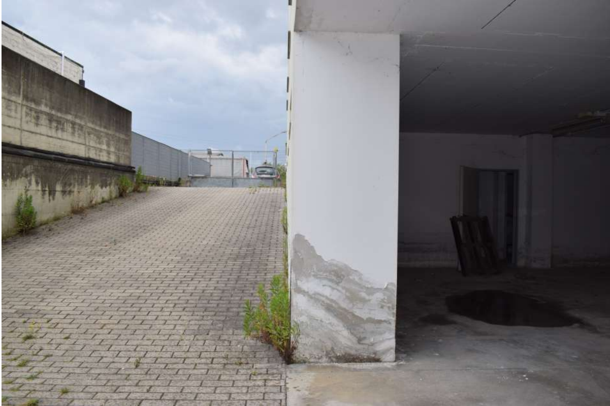
Foto n. 7 _ Sopralluogo 17/06/2020 Palazzina uffici: piano seminterrato con accesso da rampa carrabile
