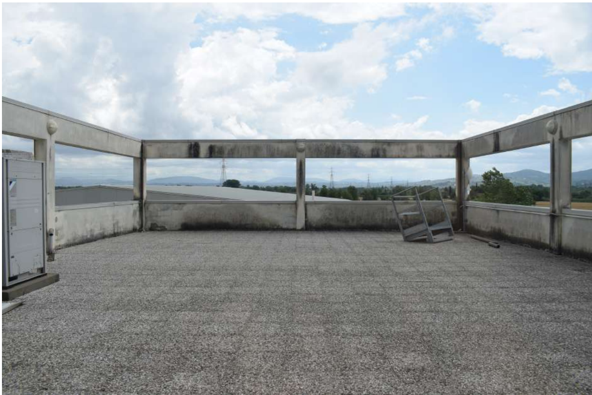
Foto n. 26 _ Sopralluogo 17/06/2020 Palazzina uffici: piano terzo, la terrazza
