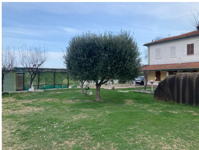
Il terreno verso la casa con i capanni abusivi
