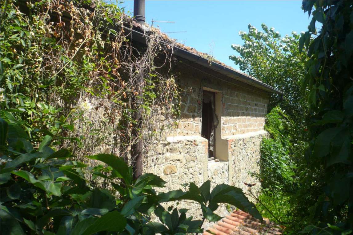
FOTO 5 – vista lato ovest
