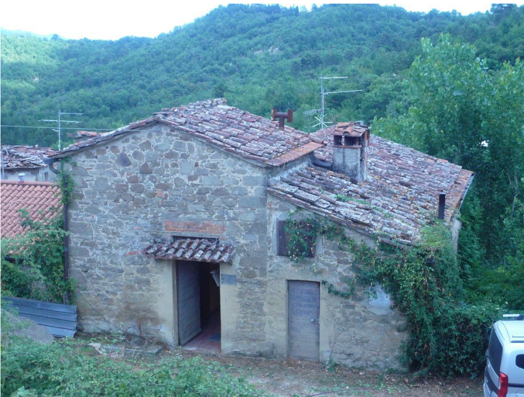
FOTO 2 – vista lato ingresso
