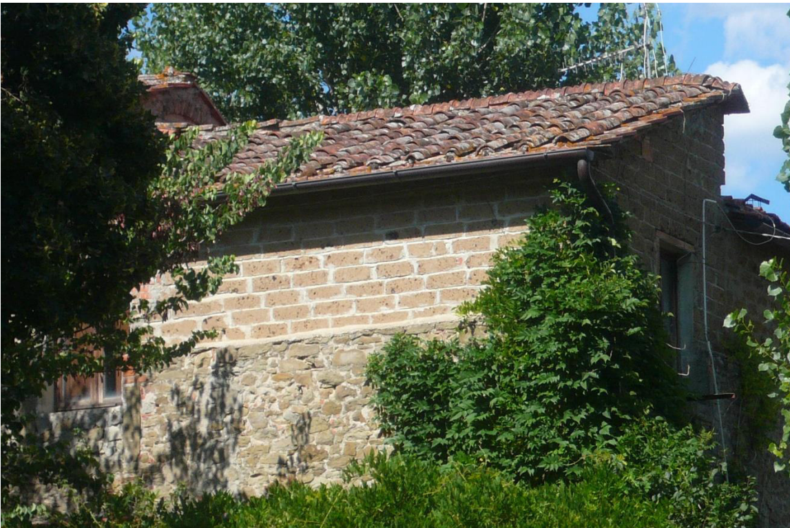
FOTO 6 – vista lato sud-ovest
