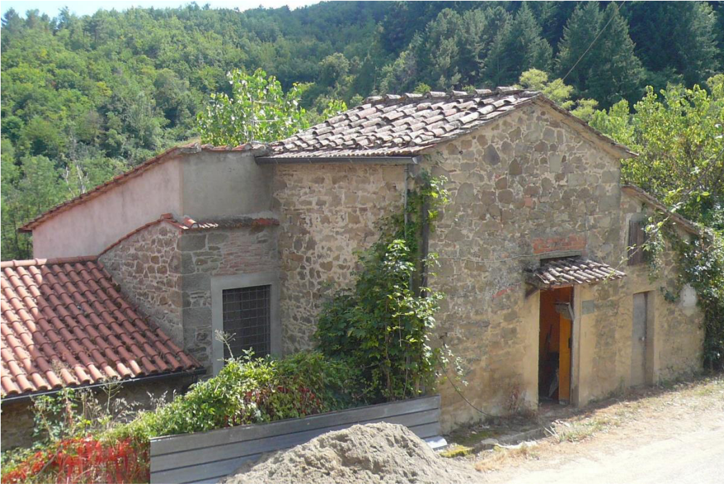
FOTO 3 – vista lato nord-est
