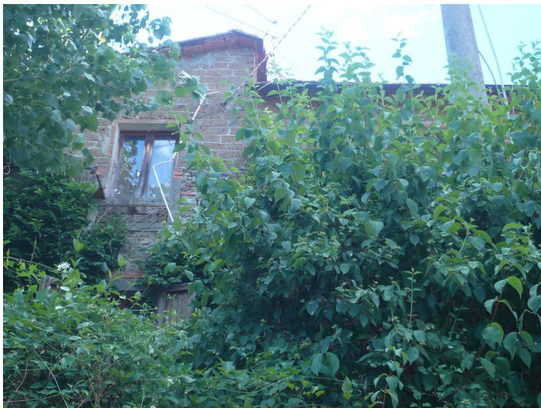
FOTO 7 – vista lato sud – finestra cucina
