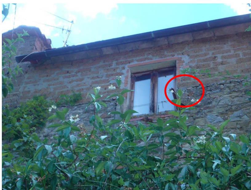
FOTO 8 – vista lato sud – finestra camera con accanto dettaglio sopraelevazione in bozze di tufo.
