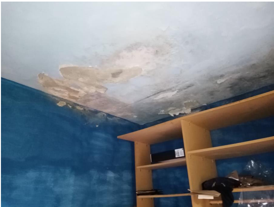
FOTO 15- camera -dettaglio infiltrazioni
