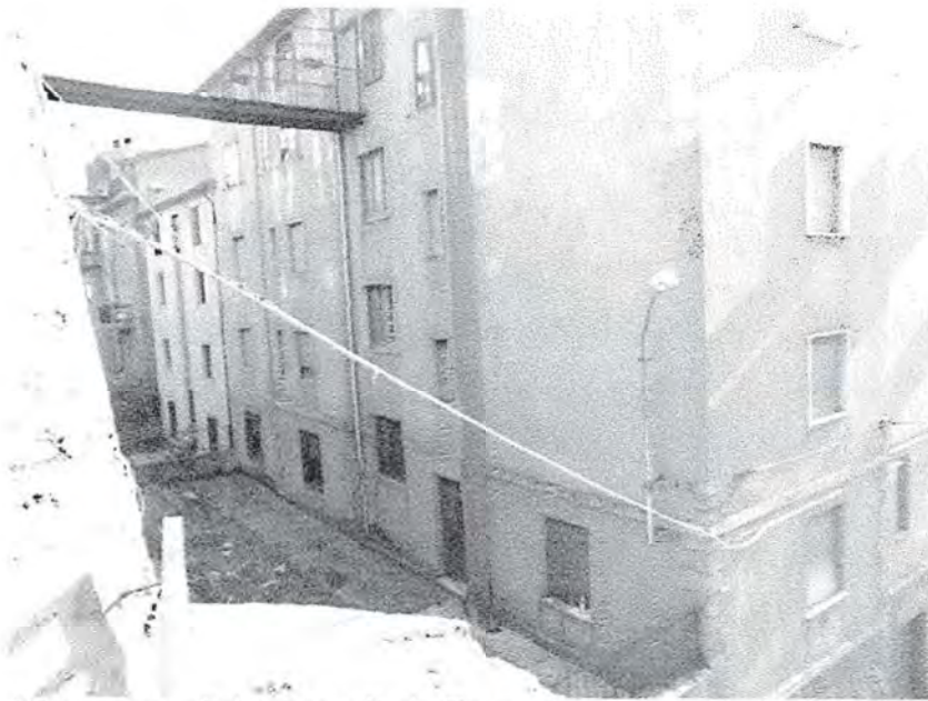
Vista esterna Fabbricato di via Gramsci
