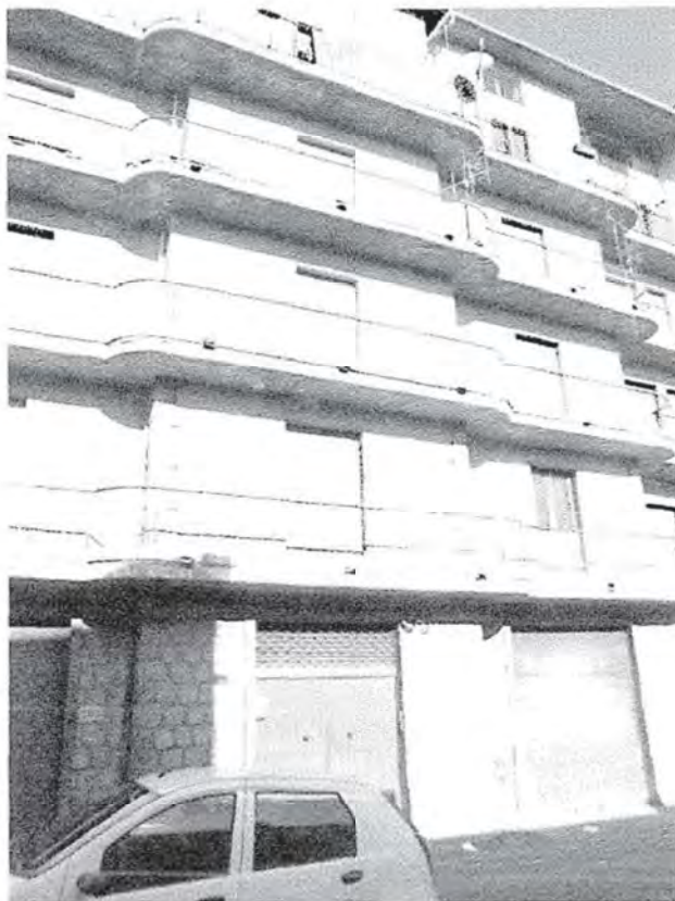
Vista esterna Fabbricato di via Gramsci
