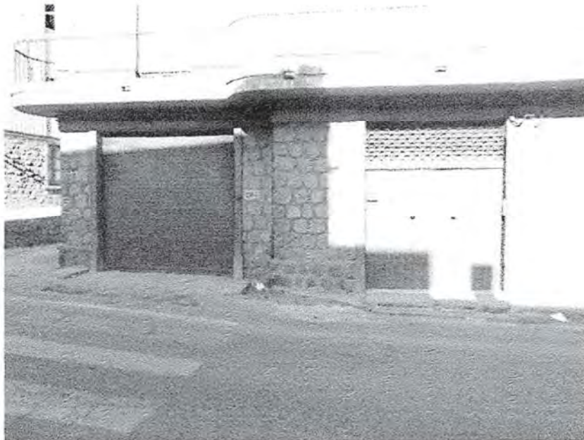
Vista esterna Fabbricato di via Gramsci
