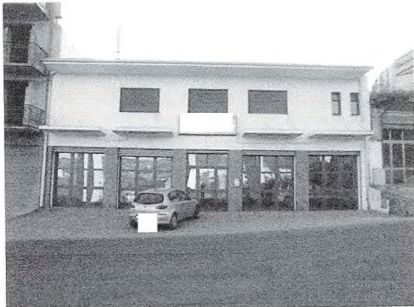
Vista esterna Lotti N. 6-7
