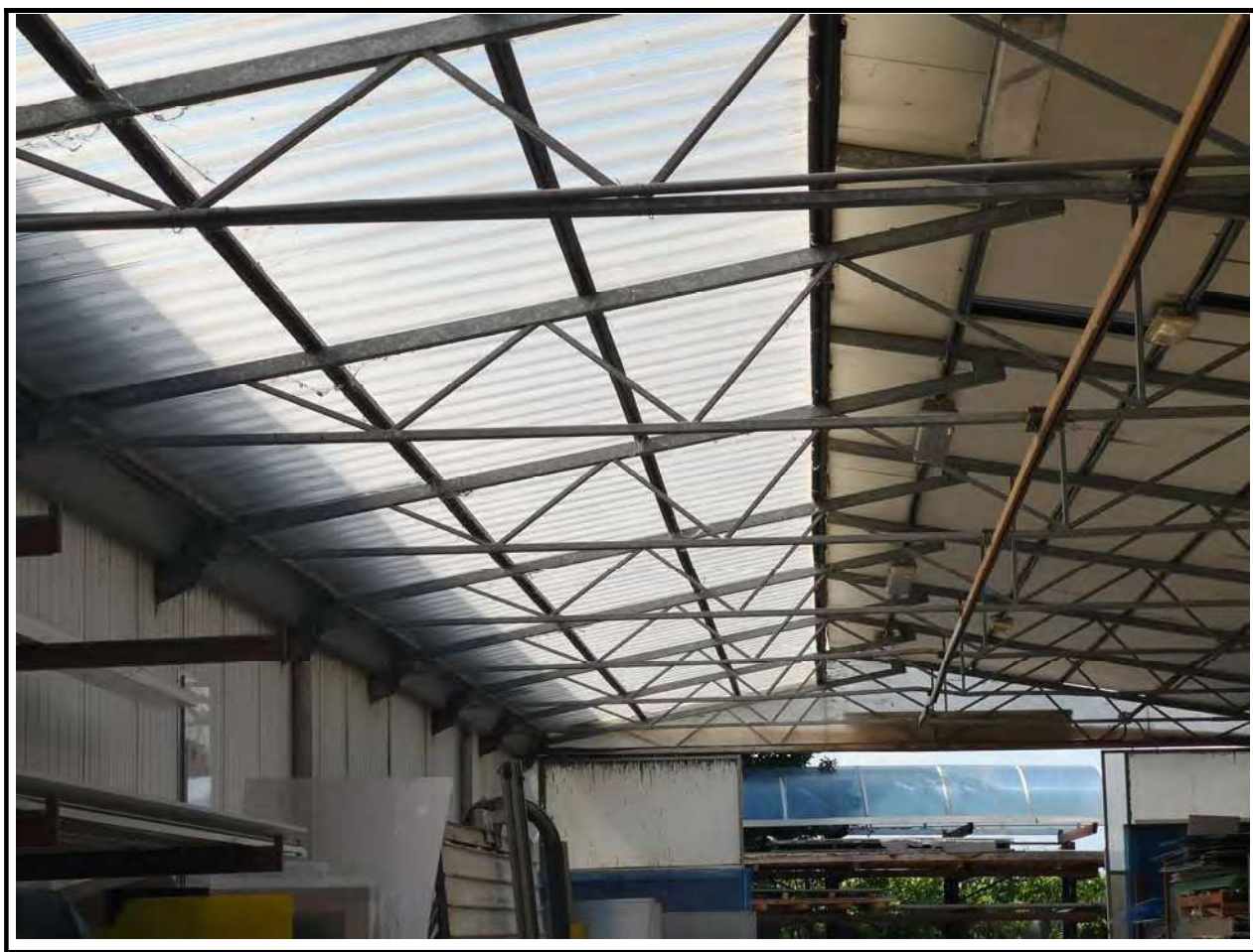
Foto n. 20 Interno capannone principale: area produttiva - particolare copertura
