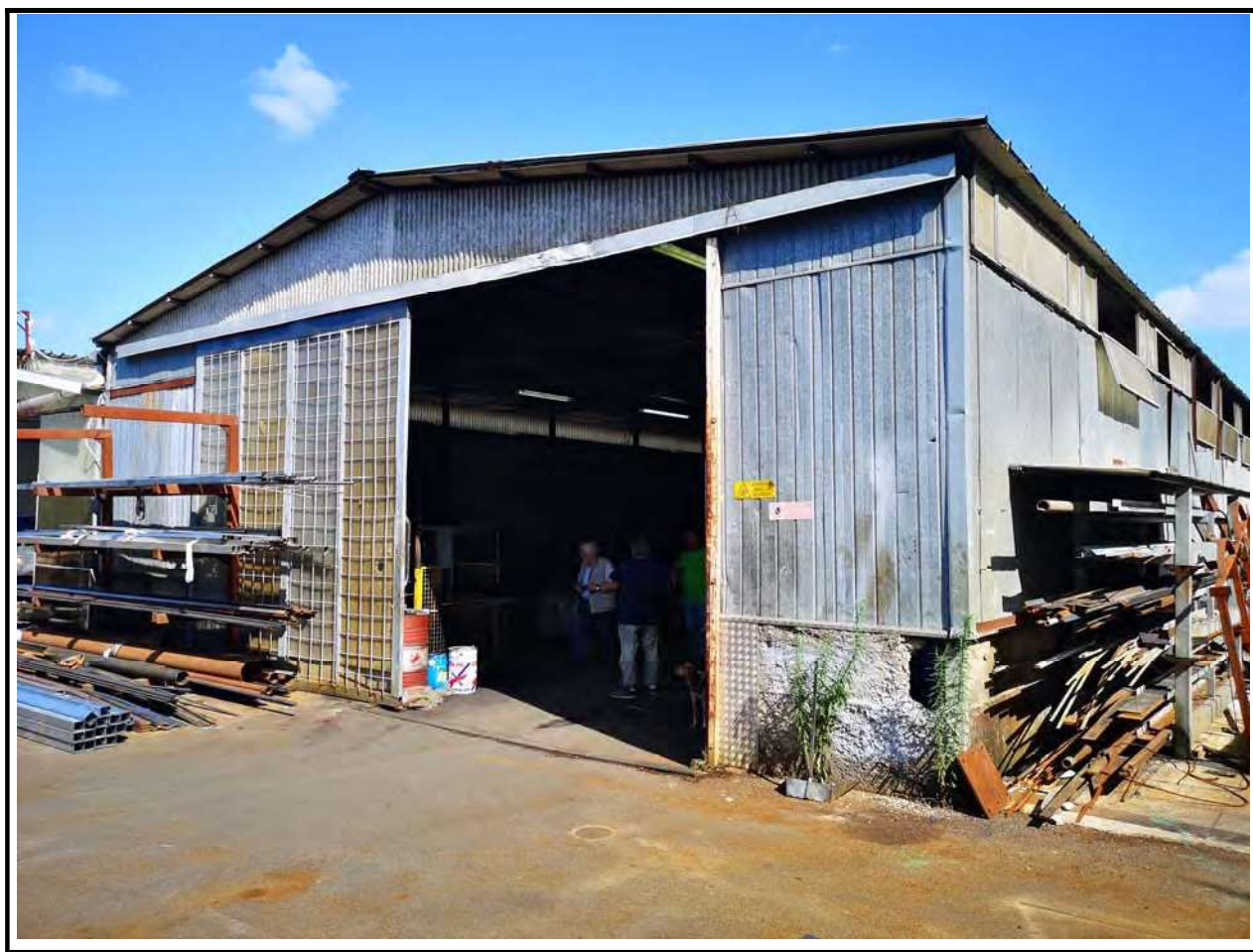
Foto n. 8 Fronte tergale del capannone produttivo
