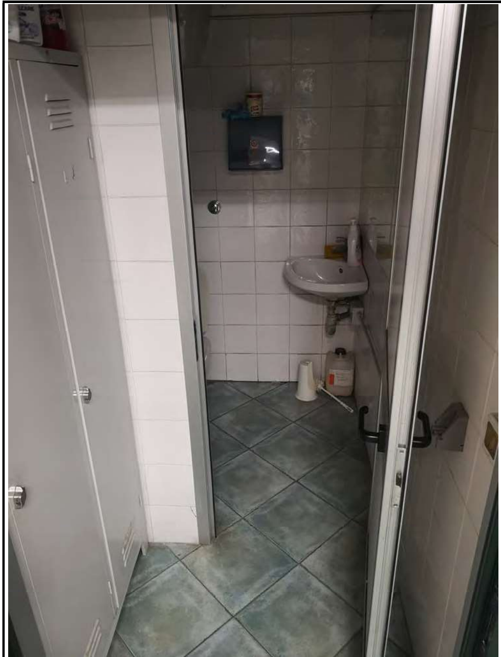
Foto n. 32 Interno capannone principale: servizi
