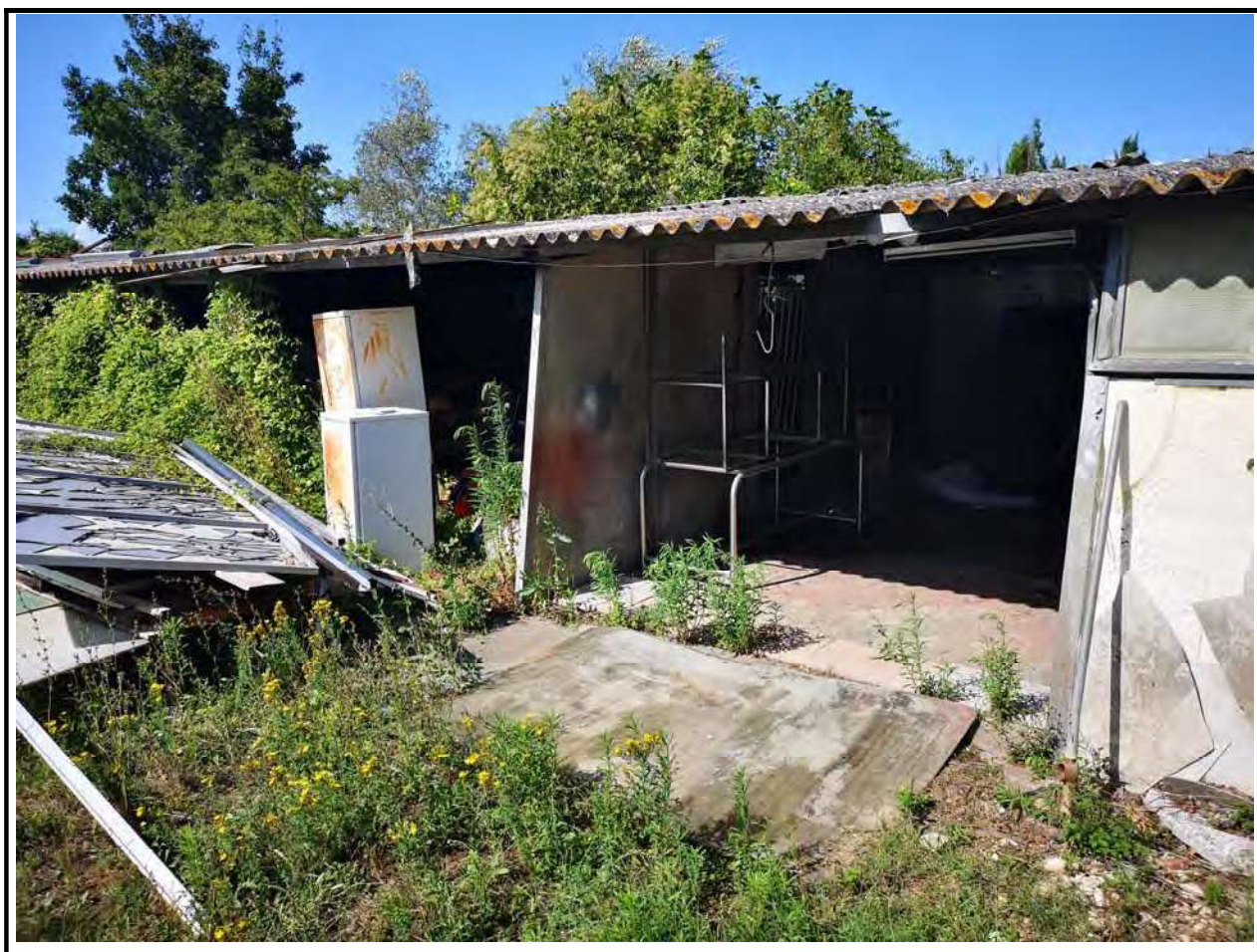
Foto n. 40 Fabbricato ex-conigliera: esterno
