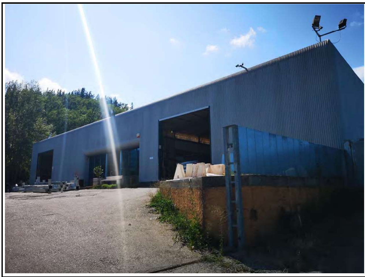
Foto n. 3 Fronte principale del capannone produttivo
