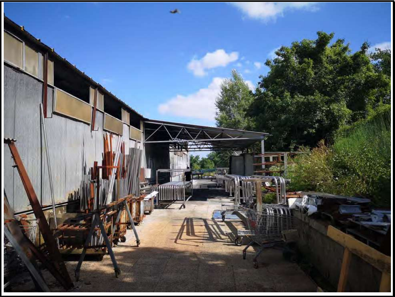
Foto n. 9 Fronte laterale del capannone produttivo
