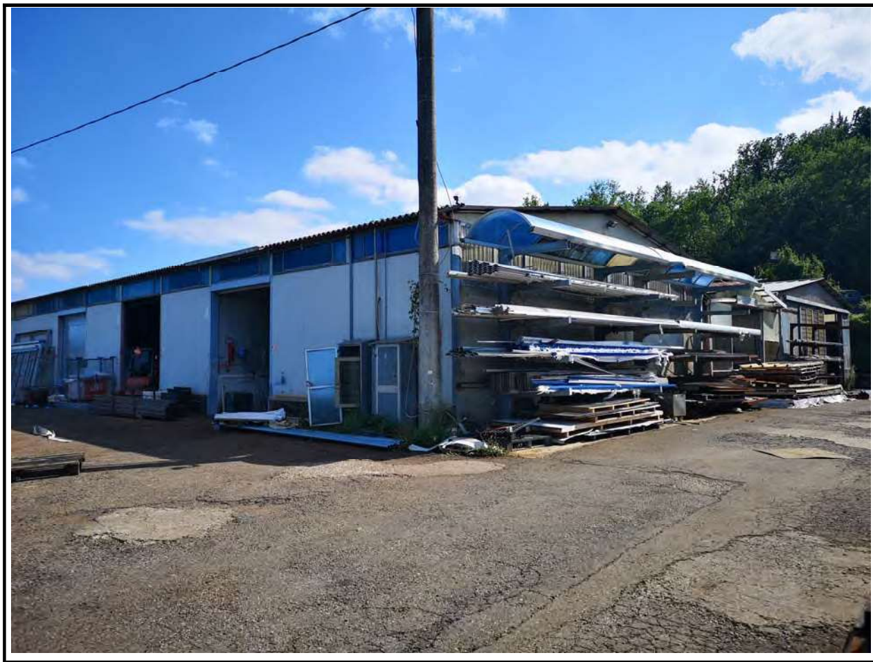
Foto n. 12 Fronte tergale del capannone produttivo
