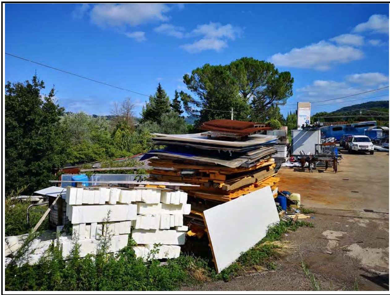
Foto n. 56 Materiali sparsi all'interno dell'area di proprietà
