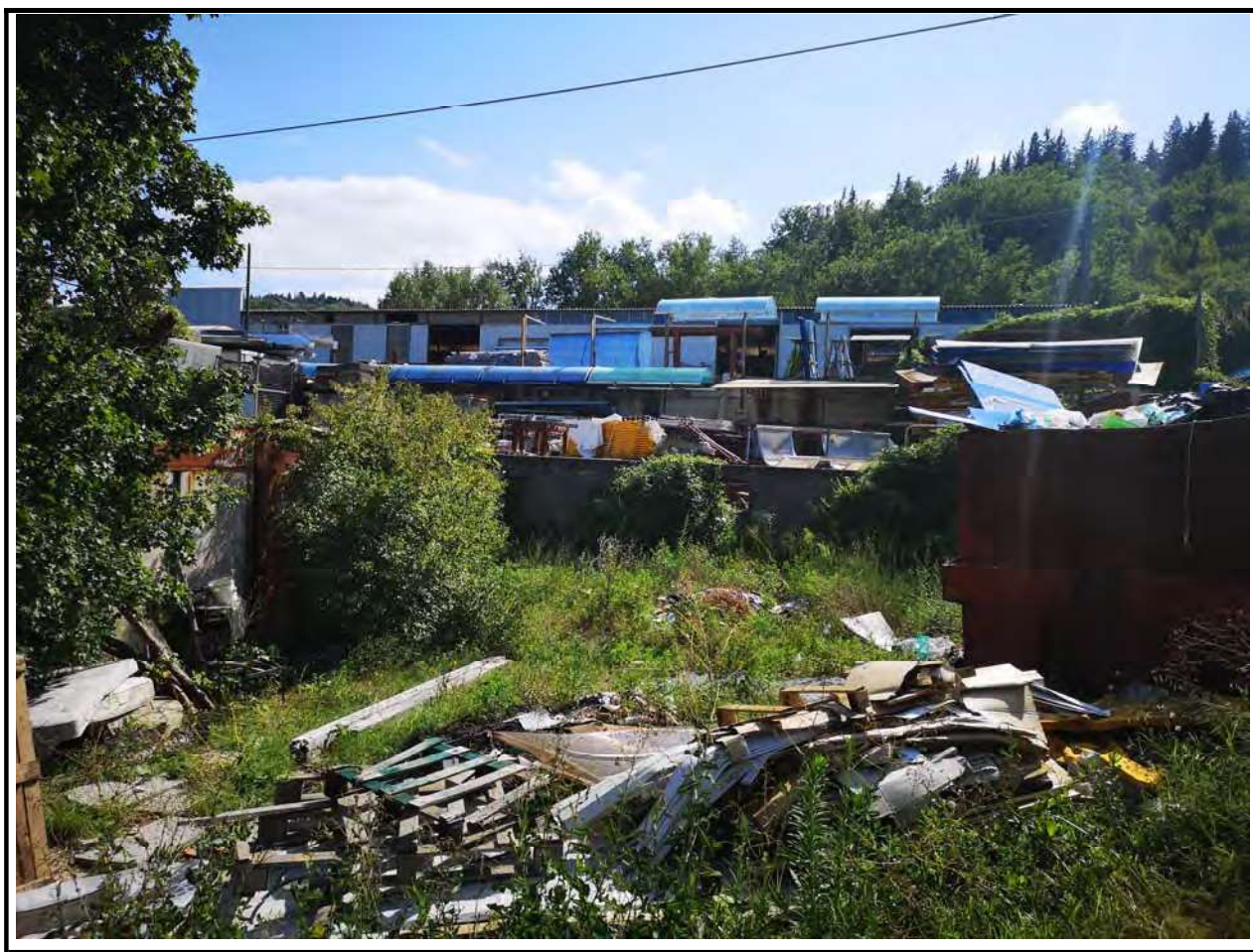
Foto n. 50 Materiali sparsi all'interno dell'area di proprietà
