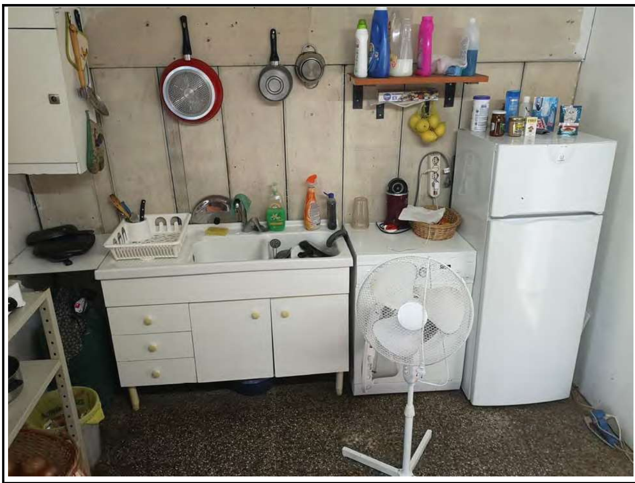
Foto n. 39 Fabbricato ex-conigliera: interno
