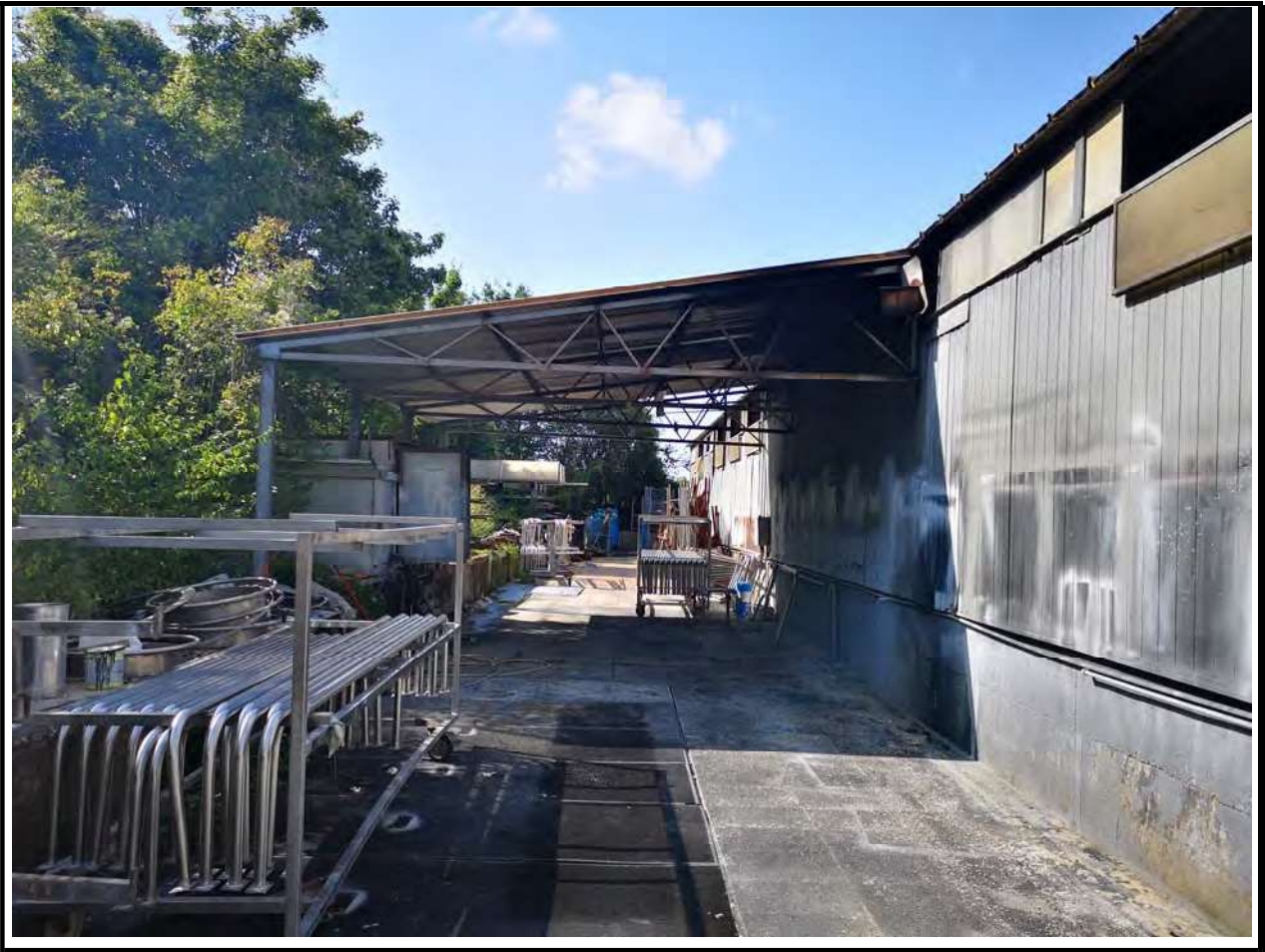
Foto n. 11 Fronte laterale del capannone produttivo
