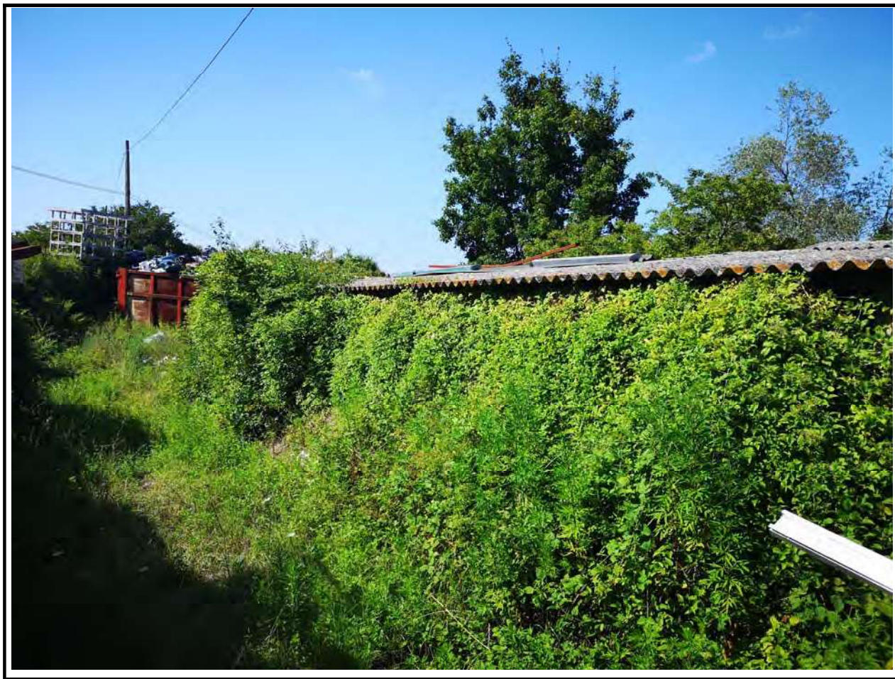
Foto n. 41 Fabbricato ex-conigliera: esterno
