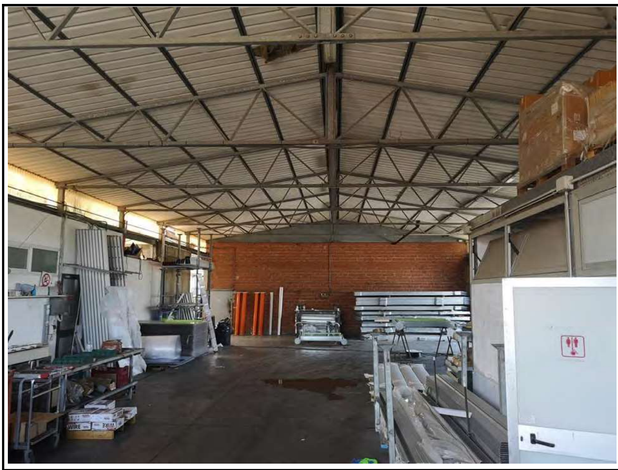
Foto n. 18 Interno capannone principale: area produttiva
