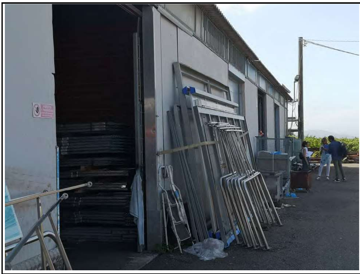
Foto n. 6 Fronte laterale del capannone produttivo
