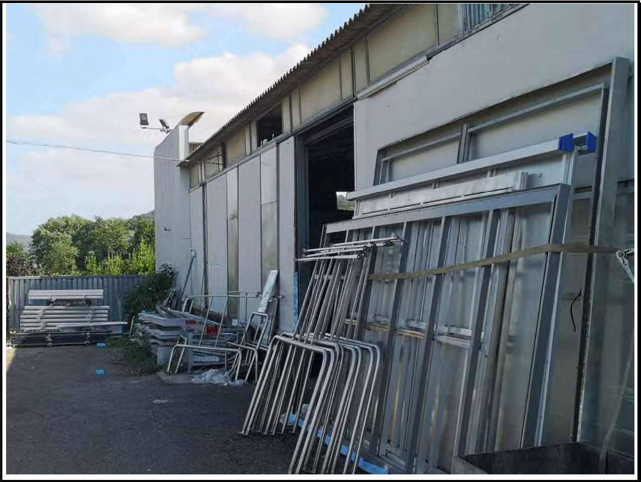
Foto n. 7 Fronte laterale del capannone produttivo
