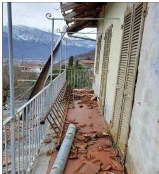
**Crollo di tegole dal tetto sul balcone del P1 e sottostante tettoia**
