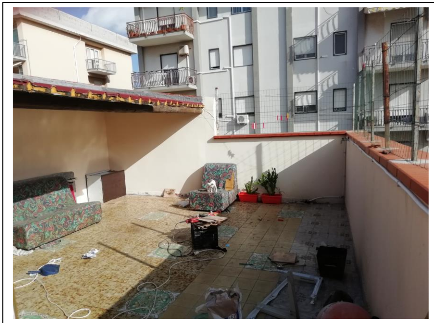
18. Esterno dell'unità immobiliare con vista su terrazzo pavimentato, lato nord-est, in foto copertura parziale sul lato sinistro.
