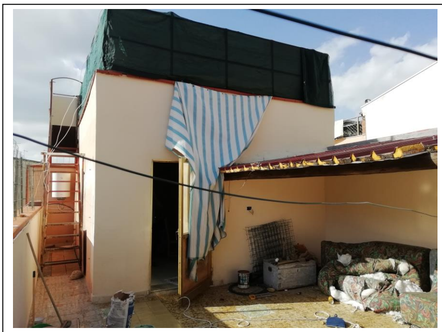
19. Esterno dell'unità immobiliare, area terrazzo, al piano secondo con vista lato ovest.
