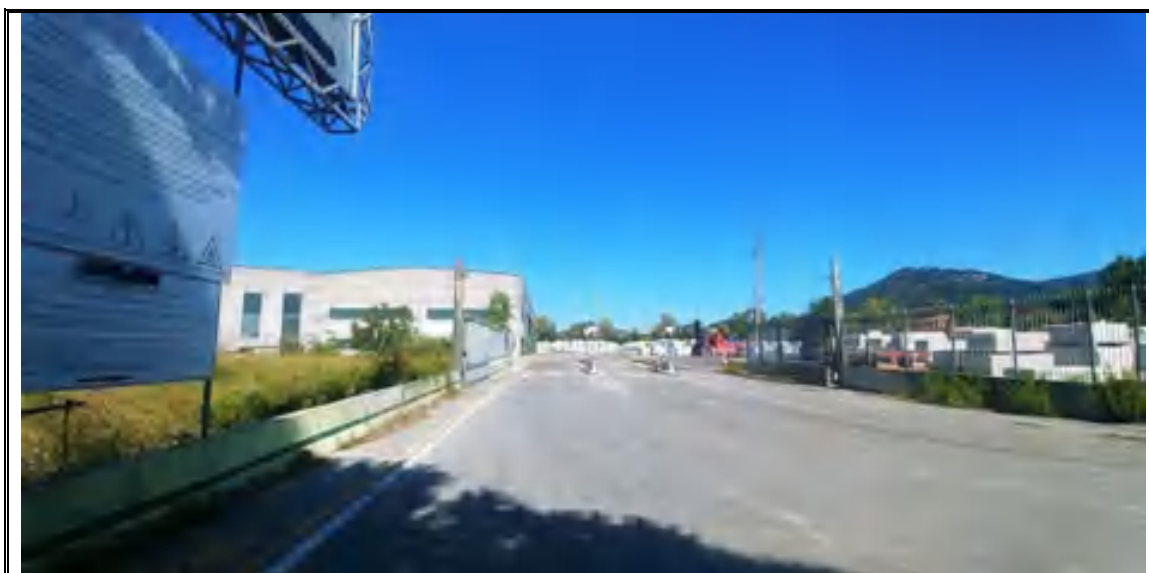
Foto n. 74 – Corpo C – Capannone mappale 547 –Ingresso al piazzale lato Massa
