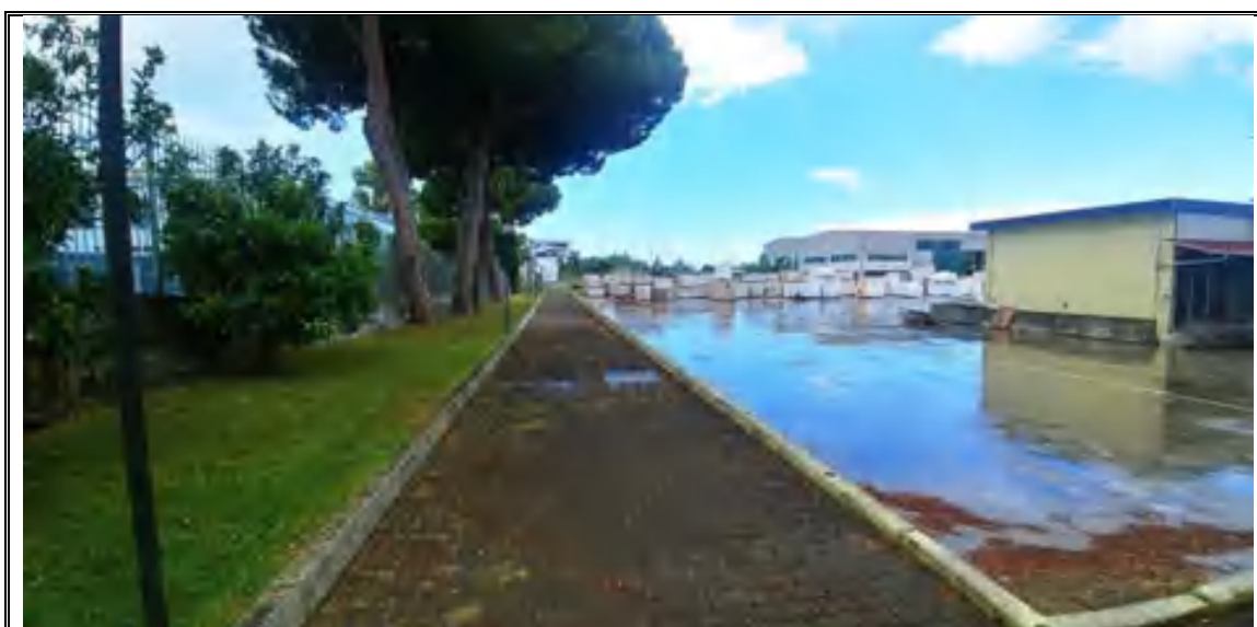
Foto n. 72 – Corpo C – Capannone mappale 547 – Vialeto e piazzale
