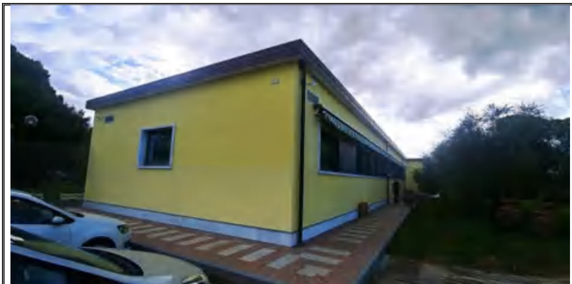
Foto n. 25– Corpo B – Palazzina uffici mappale 505 – Angolo OVEST
