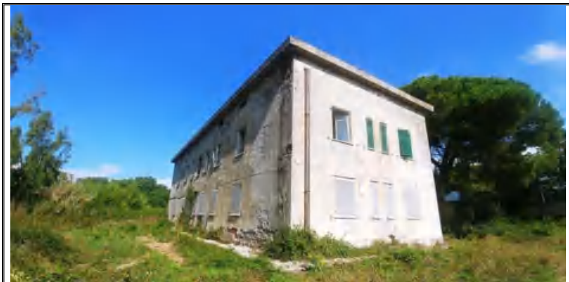
Foto n. 7– Corpo A - Fabbricato mappale 282 – Angolo SUD
