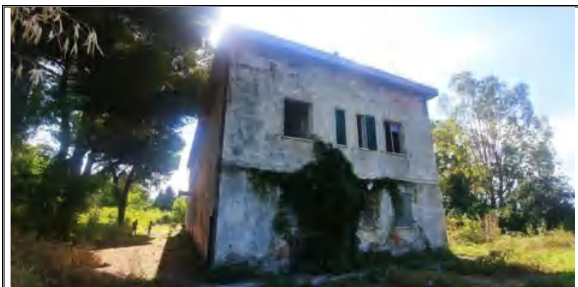
Foto n. 9 – Corpo A - Fabbricato mappale 282 – Angolo NORD
