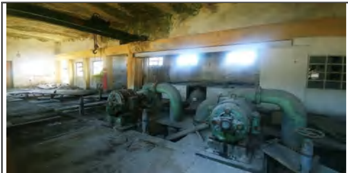
Foto n. 79– Corpo D – Ex stazione pompaggio mappale 470 – Interno
