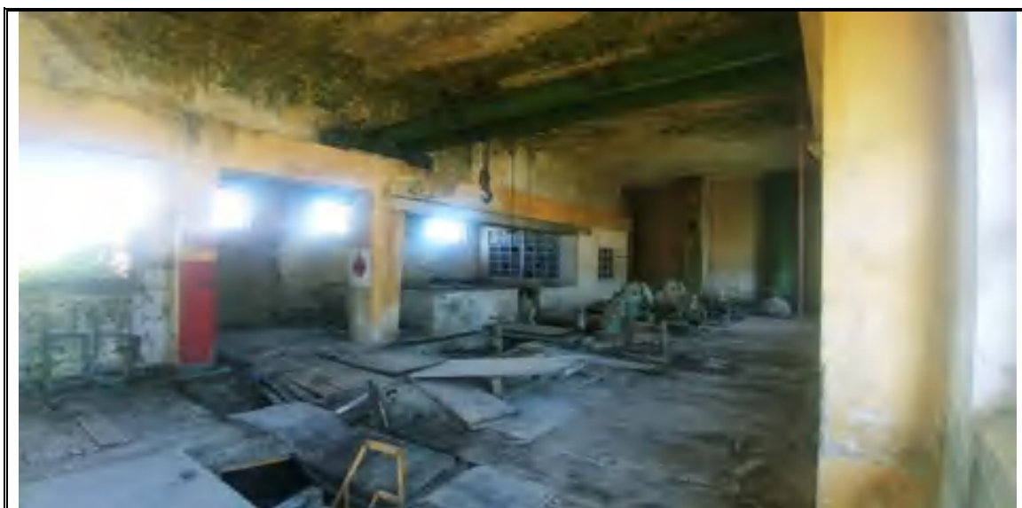
Foto n. 80 – Corpo D – Ex stazione pompaggio mappale 470 – Interno
