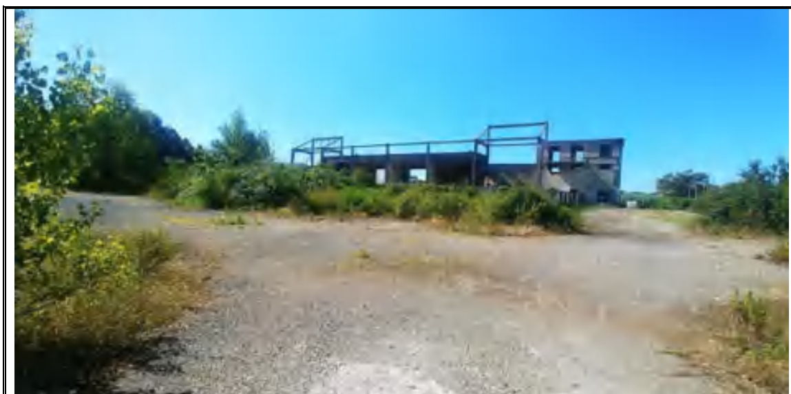
Foto n. 92– Corpo G – Terreno edificabile mappali 563/1, 563/2 e 564/2
