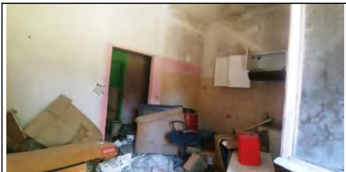
Foto n. 11 – Corpo A - Fabbricato mappale 282 – Vista di un ambiente all'interno
