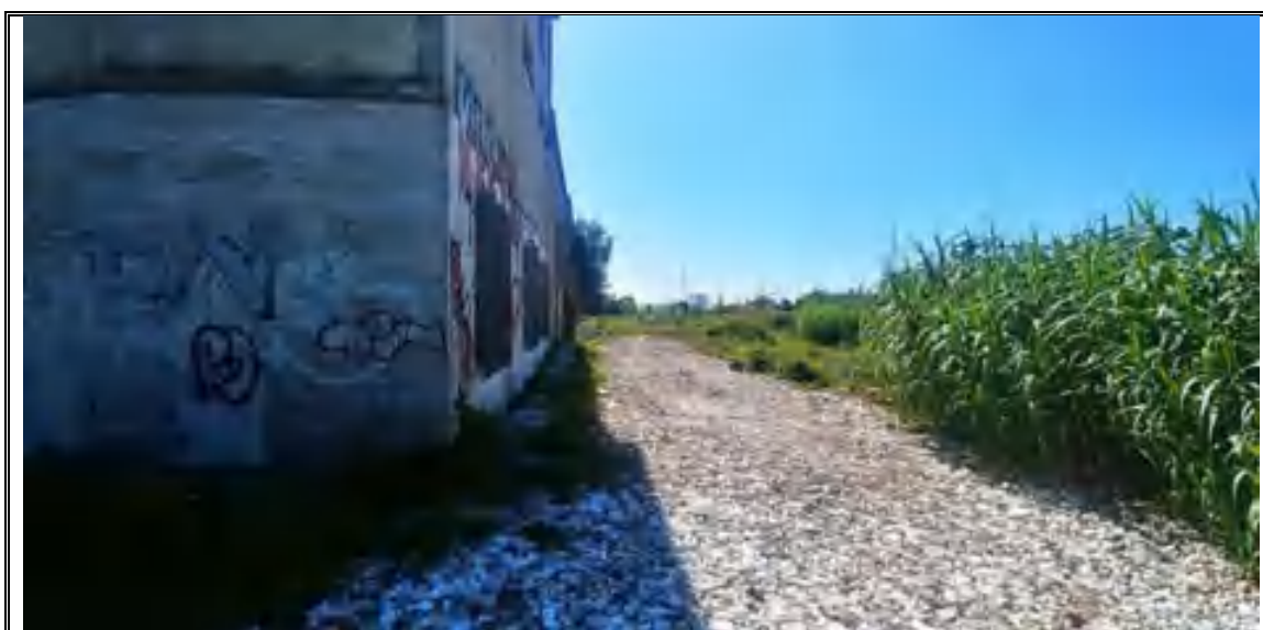
Foto n. 96 – Corpo G – Terreno edificabile mappali 563/1, 563/2 e 564/2
