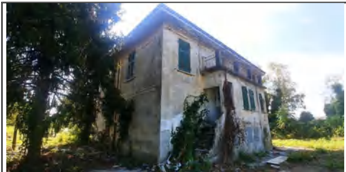
Foto n. 16– Corpo A - Fabbricato mappale 287 – Angolo NORD
