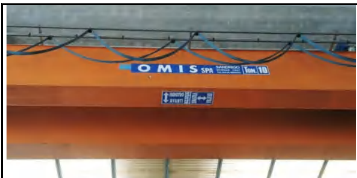
Foto n. 71 – Corpo C – Capannone mappale 547 – Carroponte
