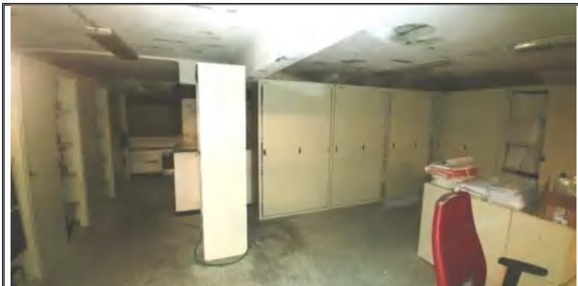
Foto n. 40– Corpo B – Palazzina uffici mappale 505 – Zona A – Archivio al piano interrato
