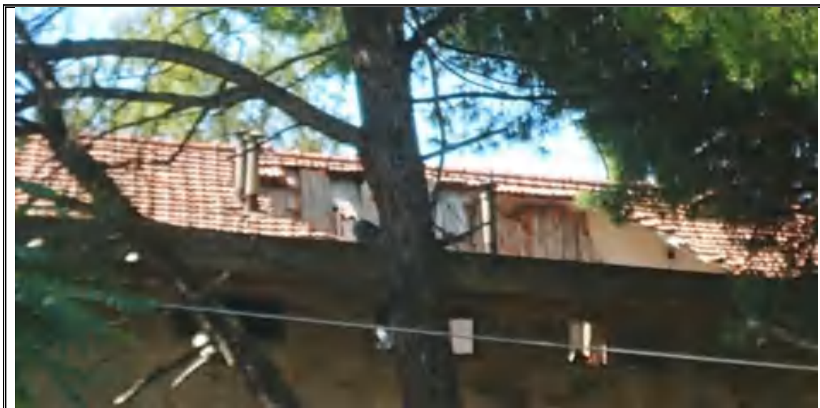
Foto n. 13– Corpo A - Fabbricato mappale 282 – Vista del tetto
