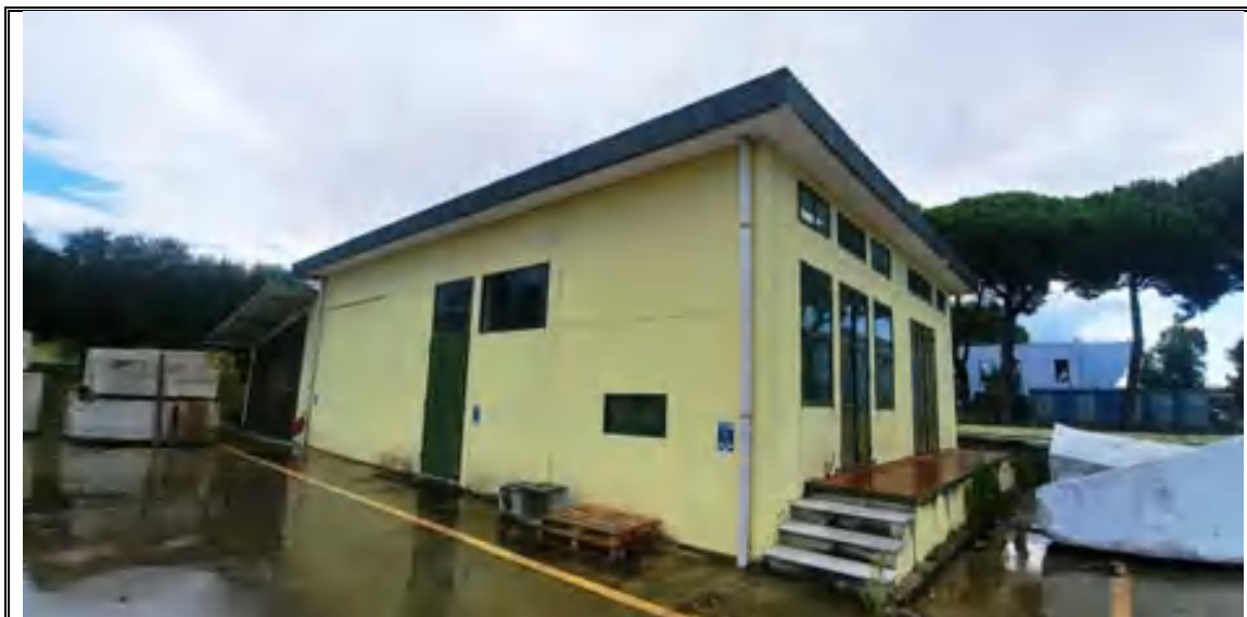
Foto n. 49– Corpo C – Magazzino mappale 548 – Angolo OVEST
