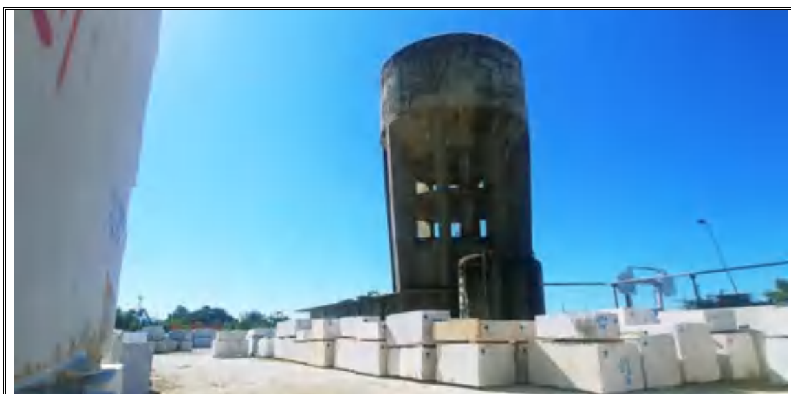
Foto n. 78 – Corpo D – Ex stazione pompaggio mappale 470 – Angolo NORD
