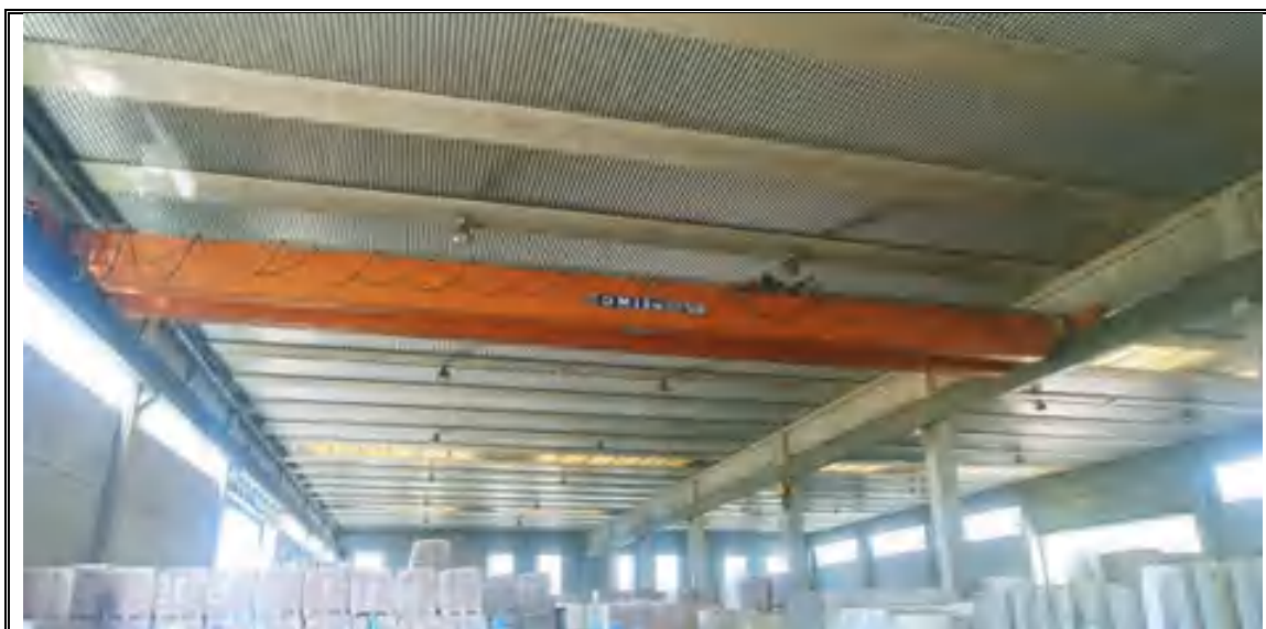
Foto n. 70– Corpo C – Capannone mappale 547 – Carroponte
