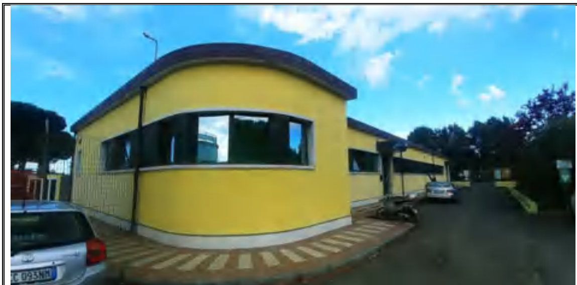
Foto n. 22– Corpo B – Palazzina uffici mappale 505 – Angolo EST
