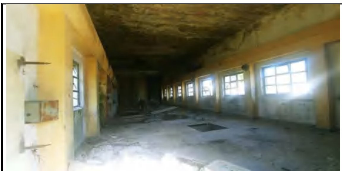
Foto n. 81 – Corpo D – Ex stazione pompaggio mappale 470 – Interno
