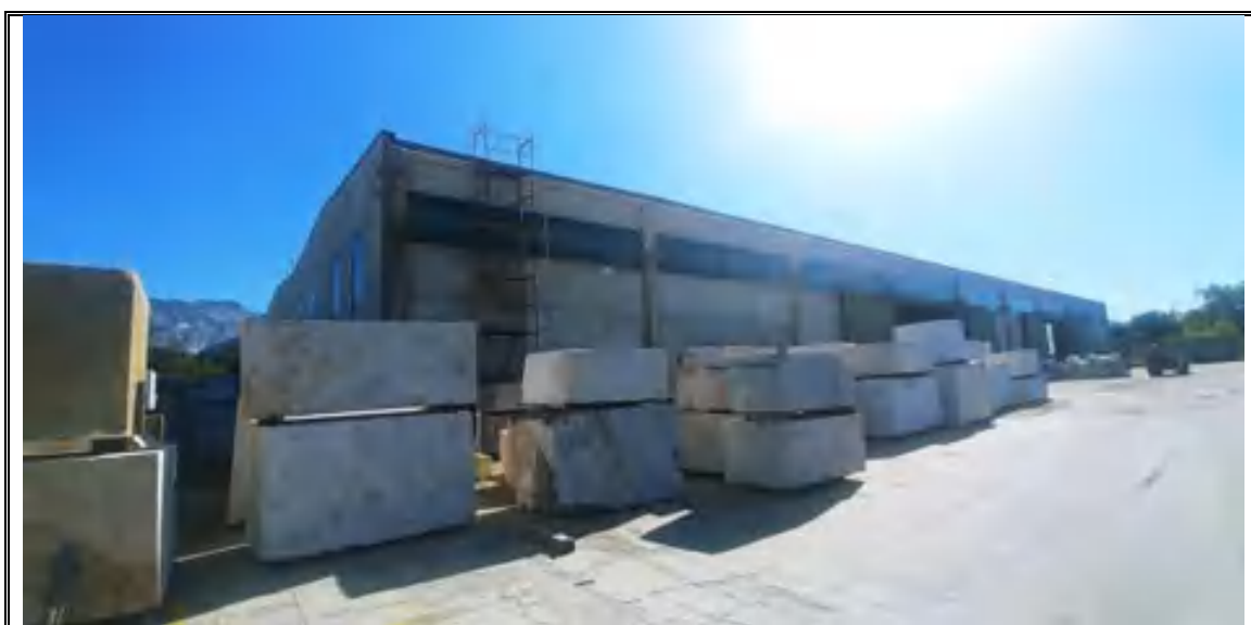
Foto n. 57 – Corpo C – Capannone mappale 547 – Angolo OVEST
