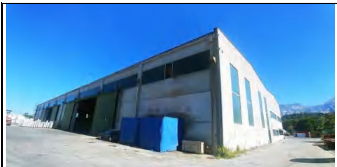
Foto n. 56– Corpo C – Capannone mappale 547 – Angolo NORD
