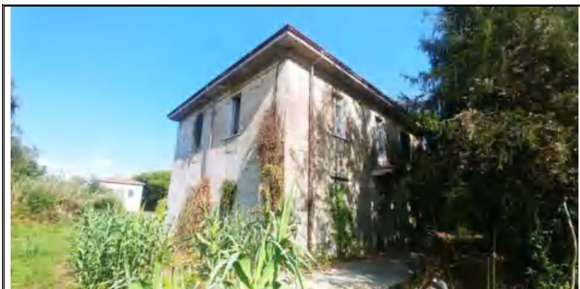
Foto n. 14 – Corpo A - Fabbricato mappale 287 – Angolo SUD
