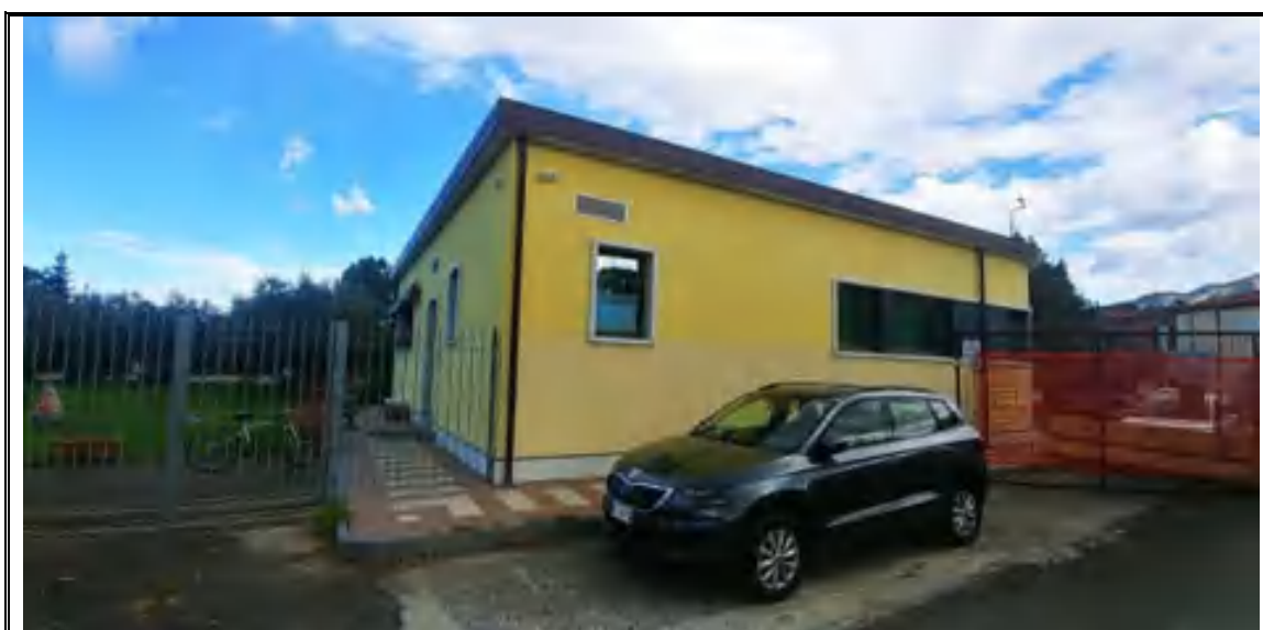
Foto n. 23– Corpo B – Palazzina uffici mappale 505 – Angolo SUD
