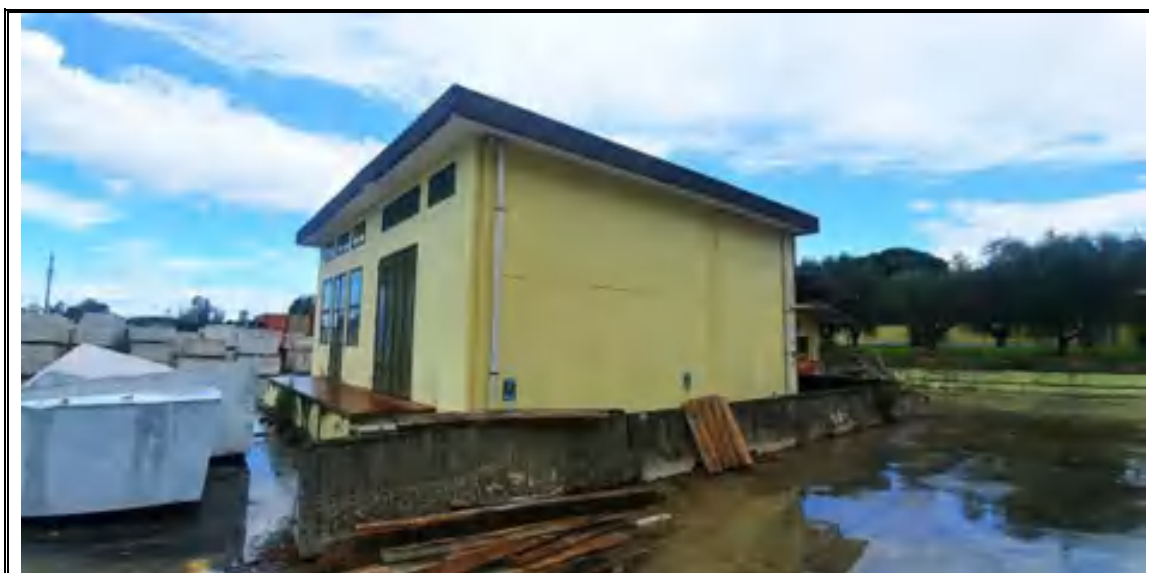
Foto n. 50– Corpo C – Magazzino mappale 548 – Angolo SUD
