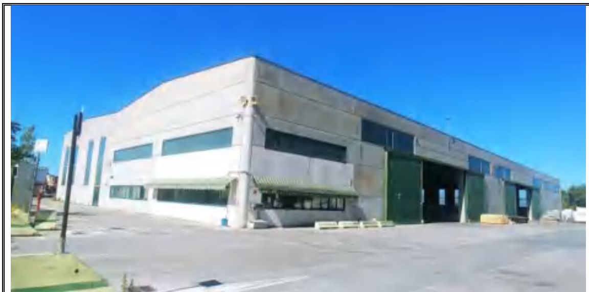
Foto n. 55– Corpo C – Capannone mappale 547 – Angolo EST
