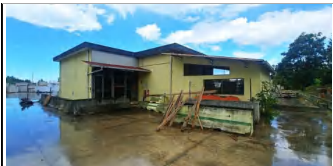
Foto n. 51 – Corpo C – Magazzino mappale 548 – Angolo EST
