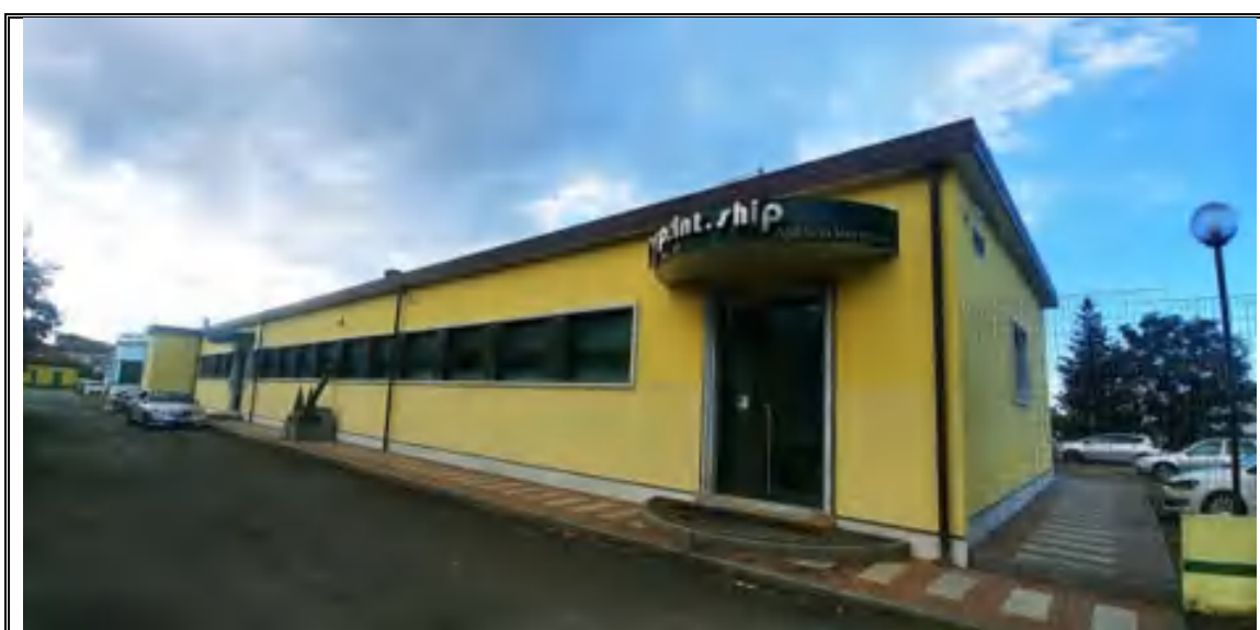
Foto n. 24 – Corpo B – Palazzina uffici mappale 505 – Angolo NORD
