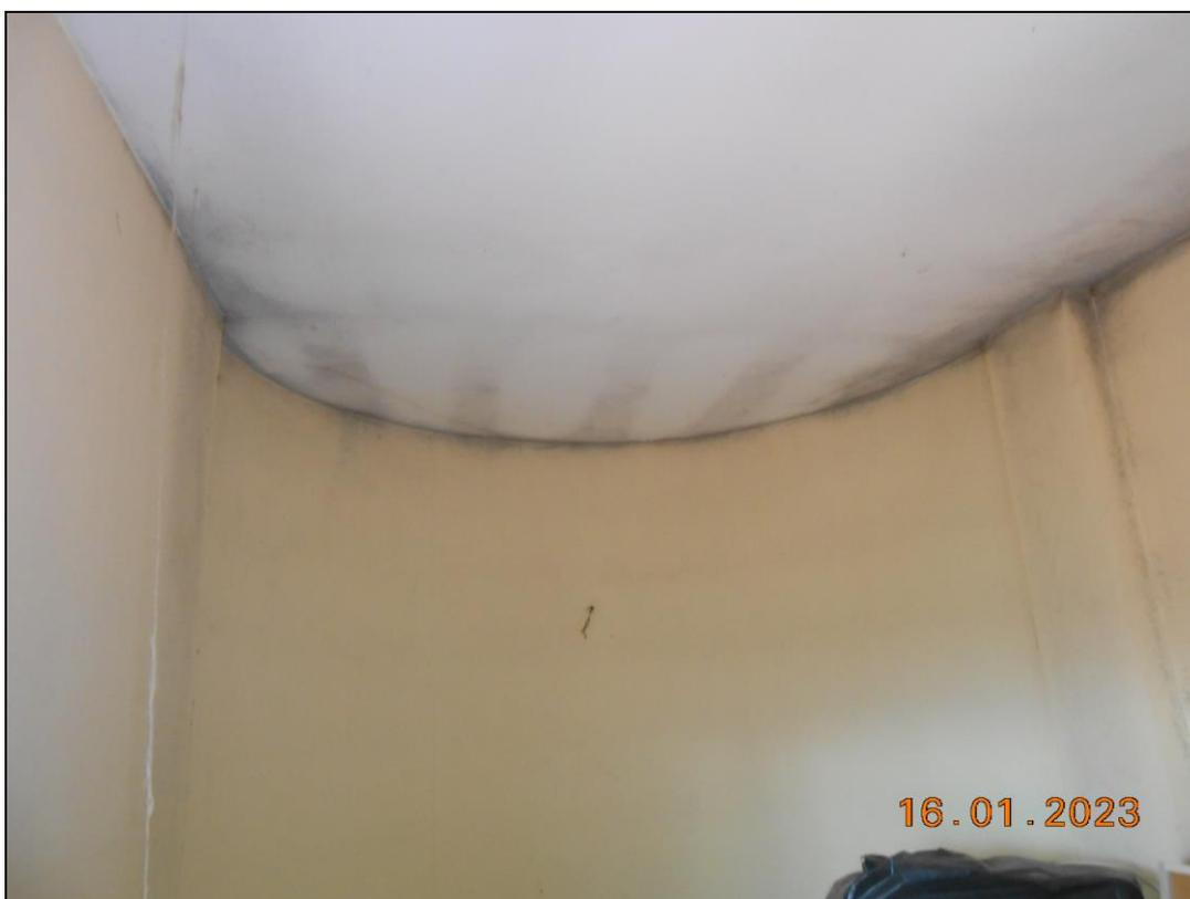
**FOTO N. 48** Vista dell'immobile a piano secondo p.Ila 337. Si nota la condensa sulle pareti e soffitto del torrino scala.
