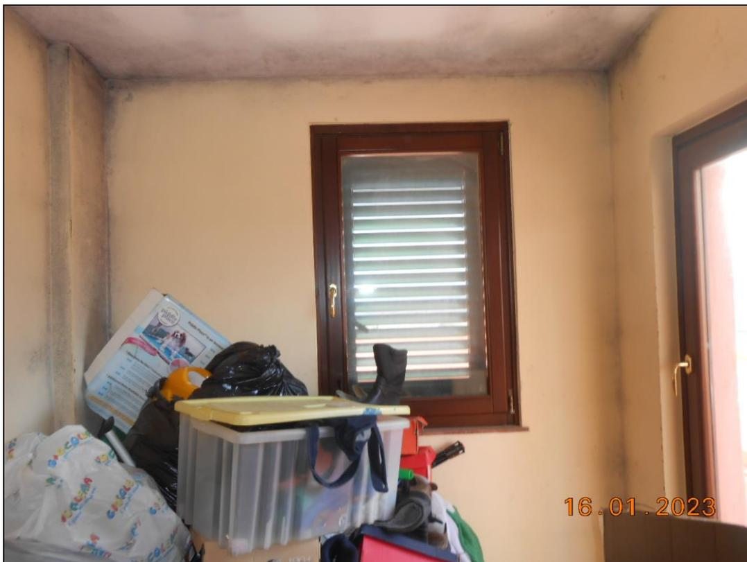
**FOTO N. 47** Vista dell'immobile a piano secondo p.Ila 337. Si nota la condensa sulle pareti e soffitto del torrino scala.
