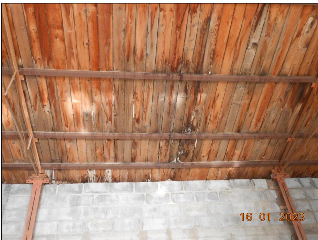
**FOTO N. 20** Particolare della copertura del capannone. Si notano le infiltrazioni d'acqua.
