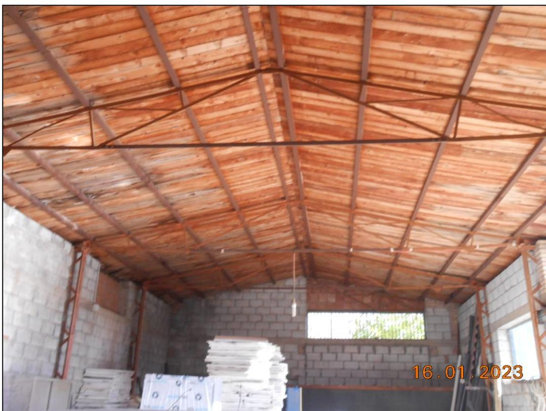
**FOTO N. 19** Vista interna del capannone p.Ila 686/2. Si notano infiltrazioni d'acqua in copertura.
