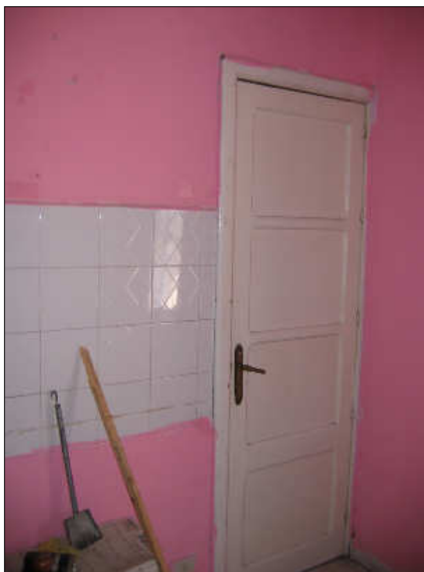
Foto n° 30 – Vista della porta di accesso al bagno.
