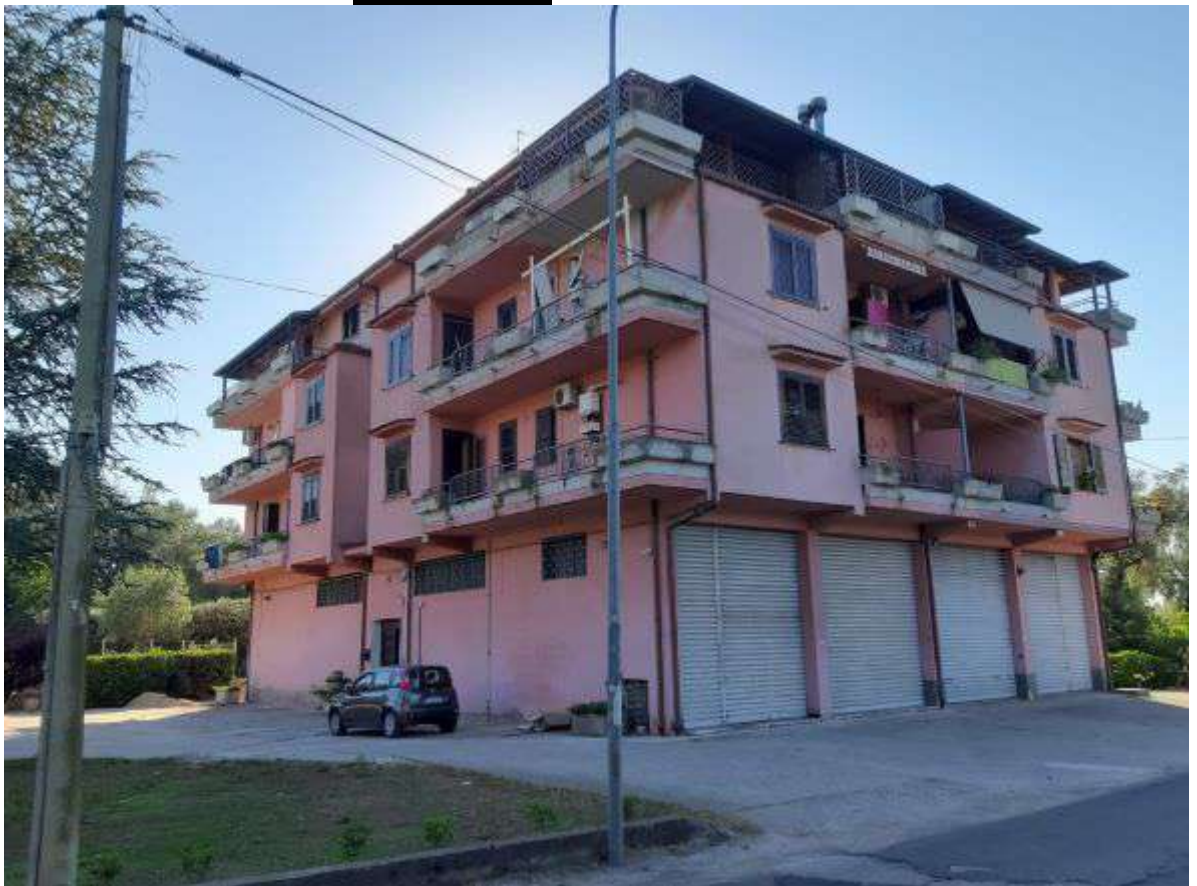
FOTO n.4 - Il fabbricato visto nel suo insieme
