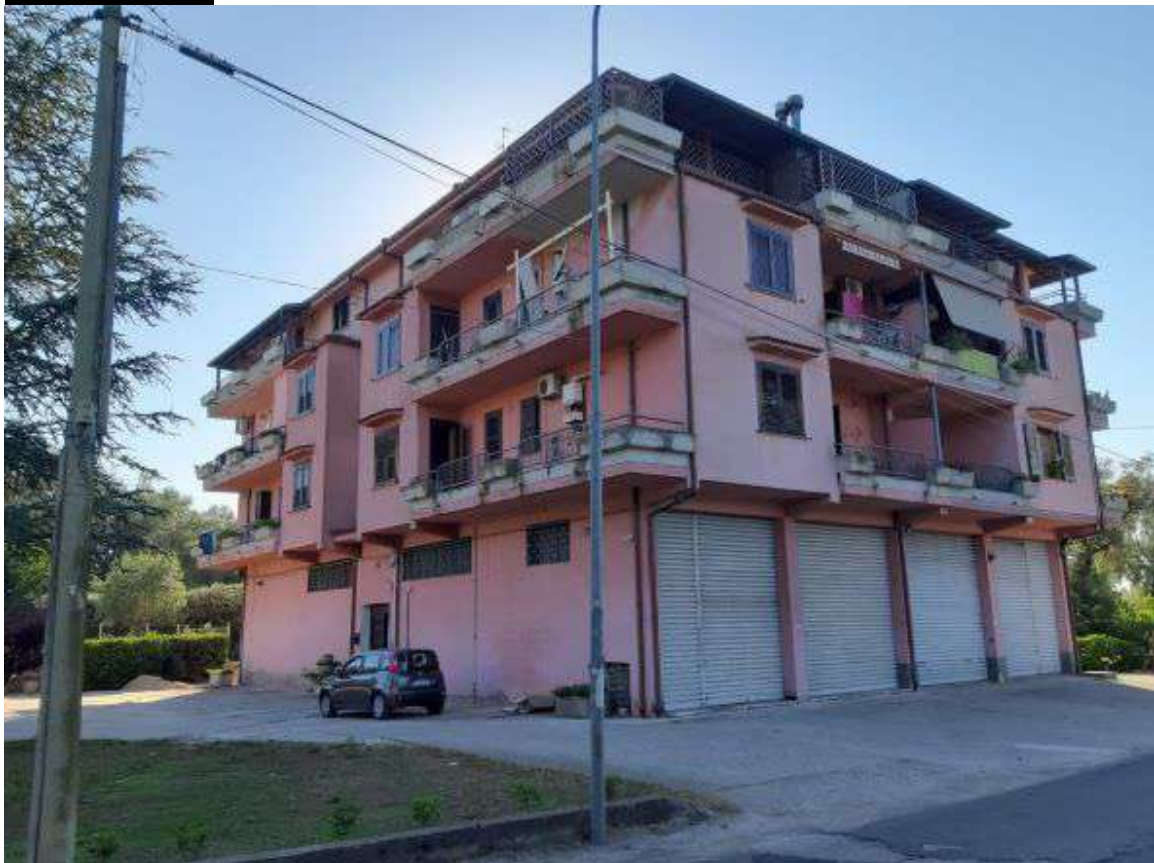
FOTO n. 4 Il Fabbricato visto nel suo insieme
