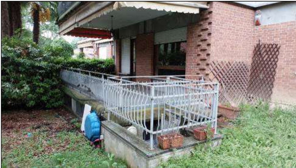
Il locale “serra” sottostante il terrazzo (ingresso dall’area giardino)
