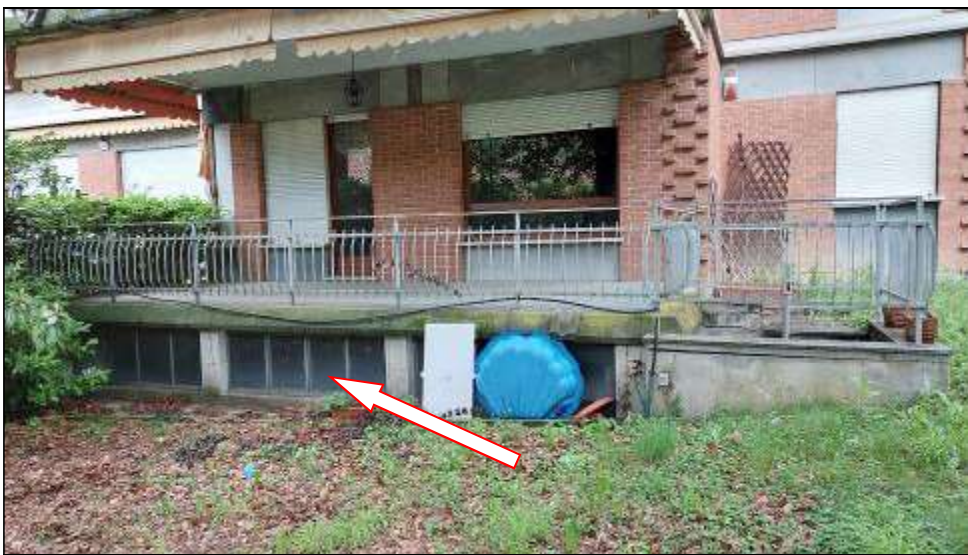
Area esterna con identificazione del locale "serra" nel sotto terrazzo
