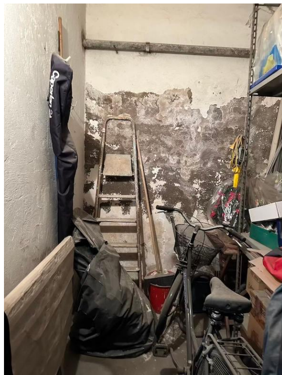
Foto n.2 – particolare locale cantinola
