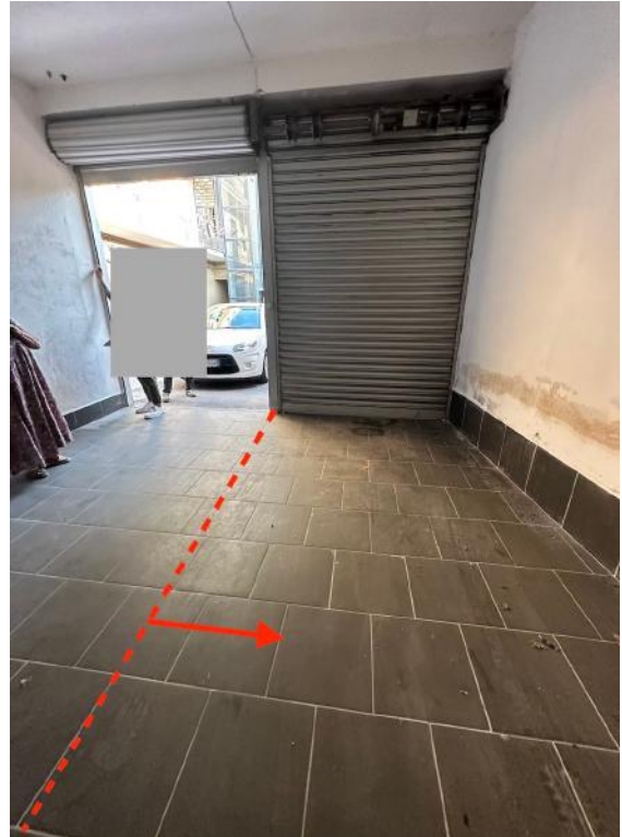
Foto n.4 – particolare locale autorimessa
