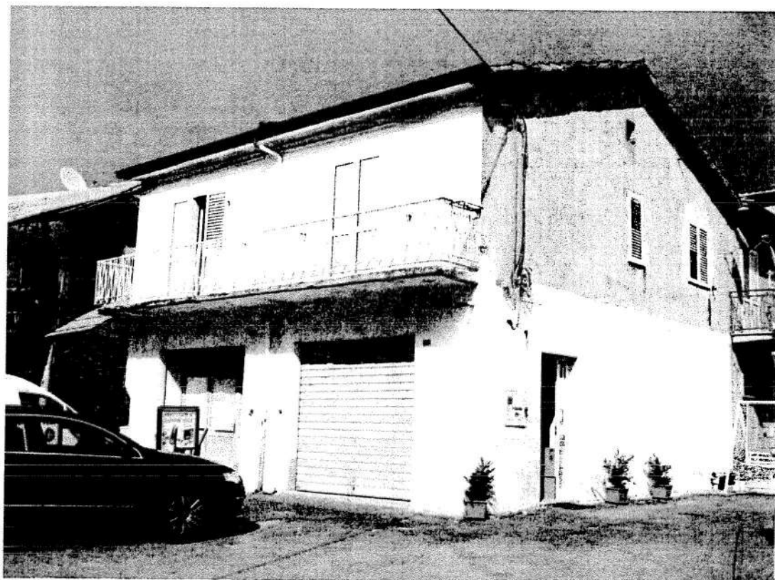
Foto n°. 2 – Esterno
