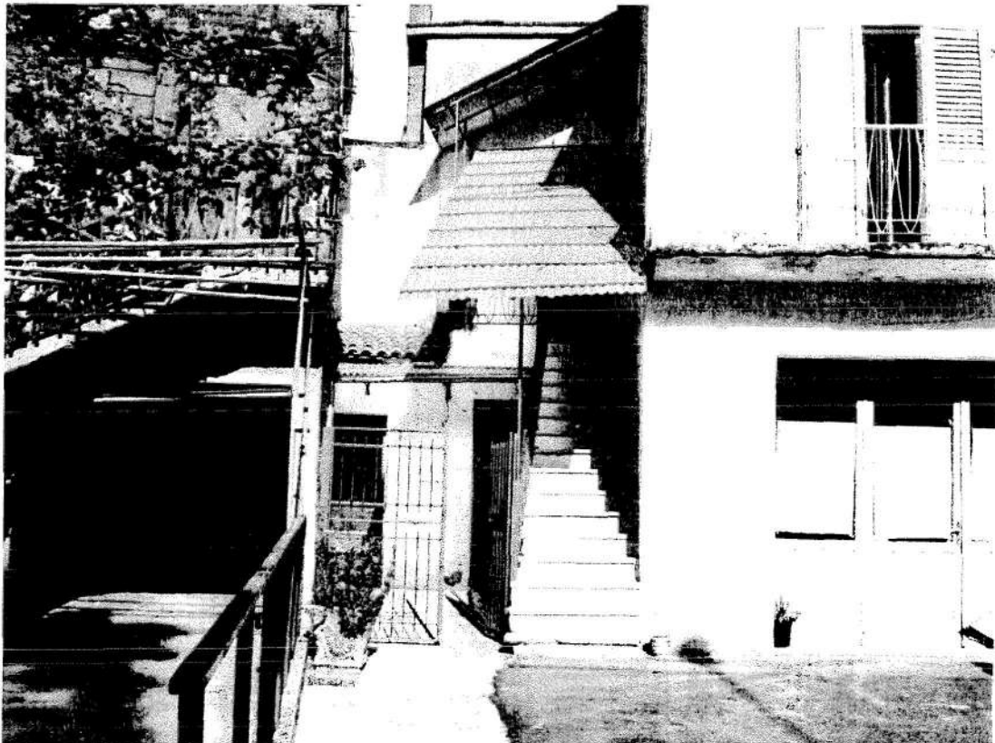
Foto n°. 4 – Esterno
