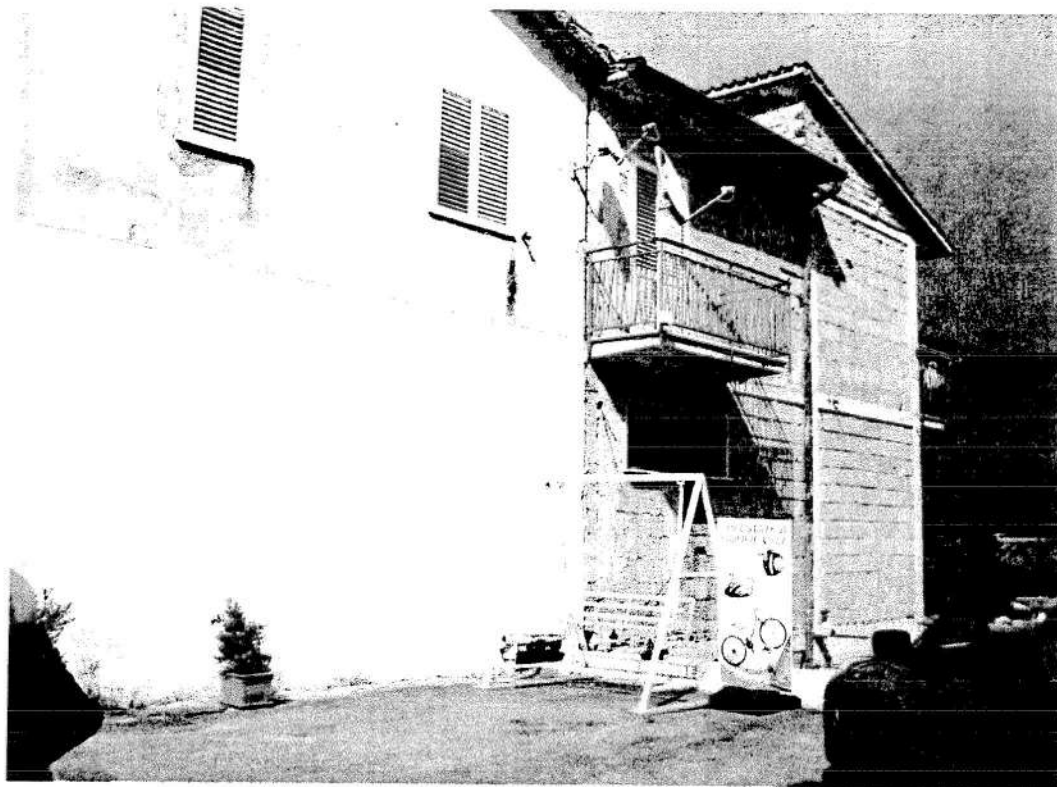
Foto n°. 1 – Esterno
