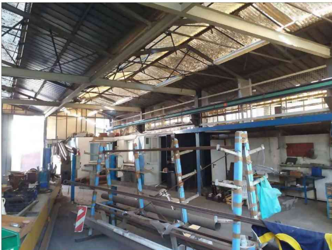
L'interno del capannone
