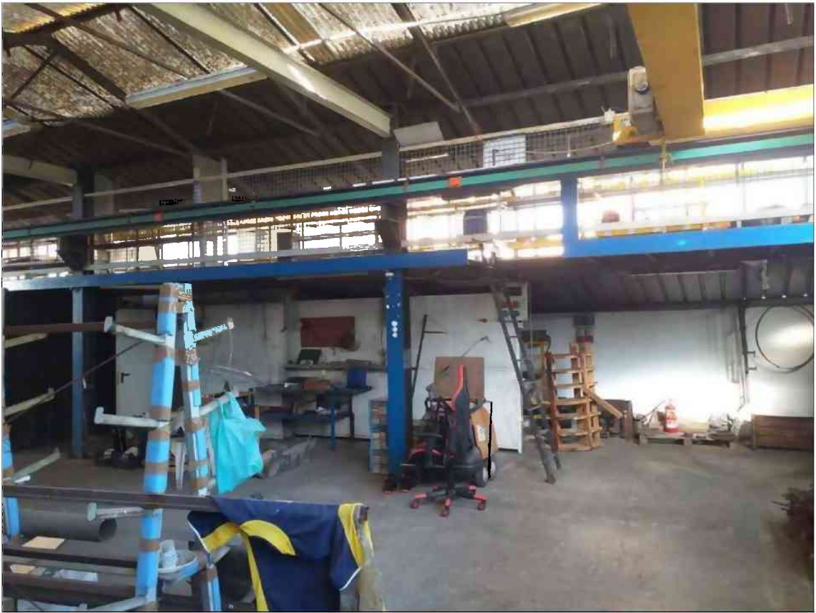
L'interno del capannone
