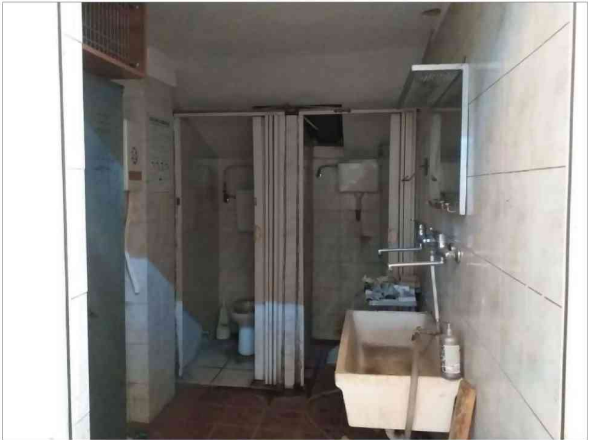
Spogliatoio e servizi igienici
