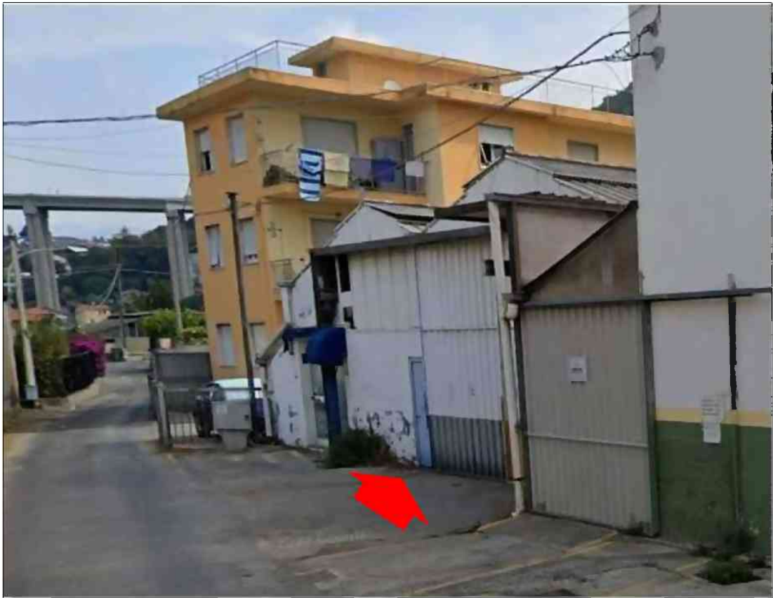
L'accesso al capannone
