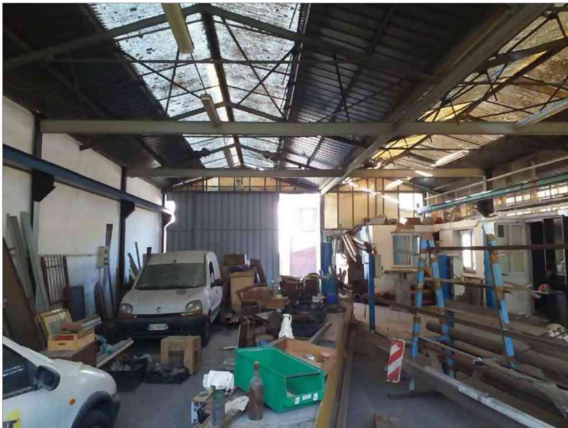
L'interno del capannone
