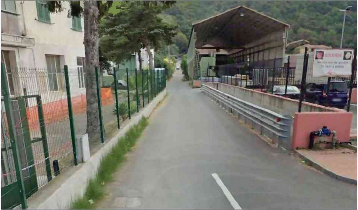
Dalla provinciale la strada di accesso.
