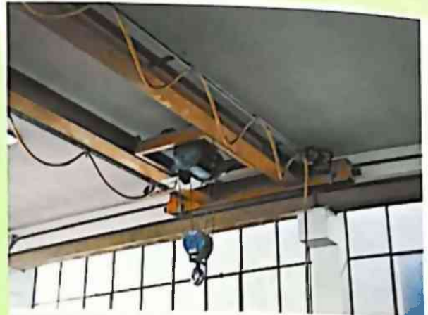
GRU BITRAVE - PORTATA TON. 3 AD INGOMBRO RIDOTTO
