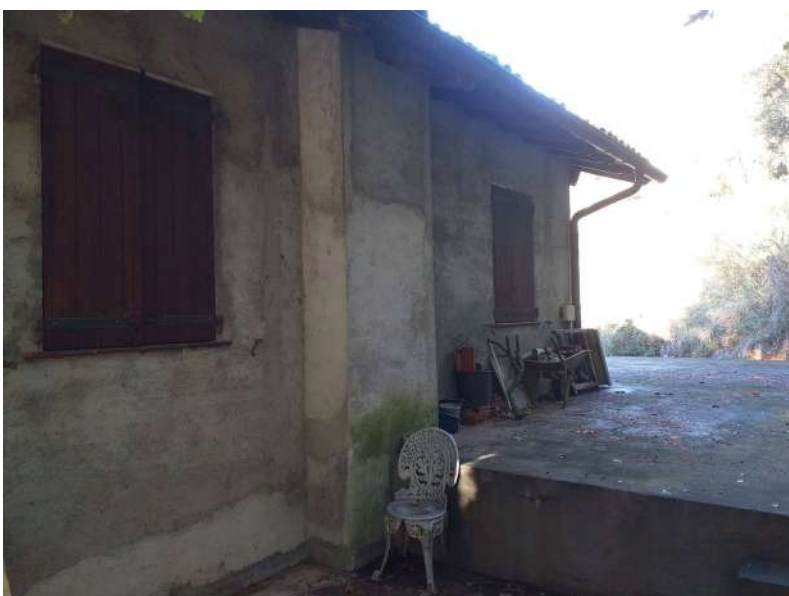
Piano terra: il retro del fabbricato e parte del lastrico
