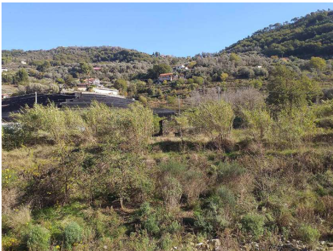
I terreni ed il fabbricato collabente
