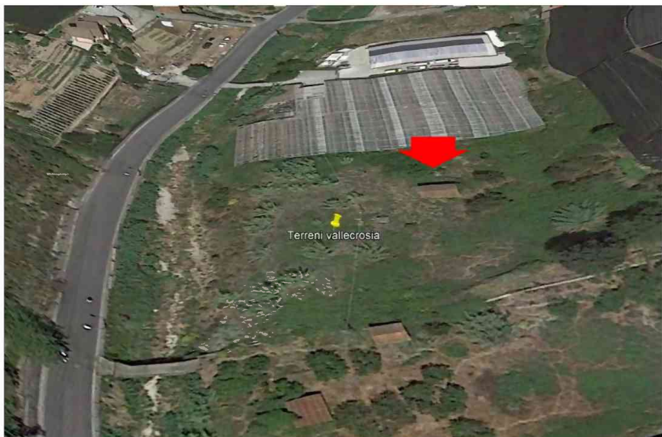
Come sopra, ingrandimento con indicazioen del fabbricato collabente
