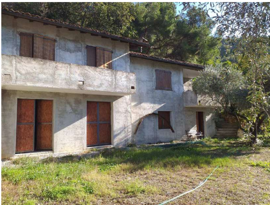
Il prospetto principale e il terreno
