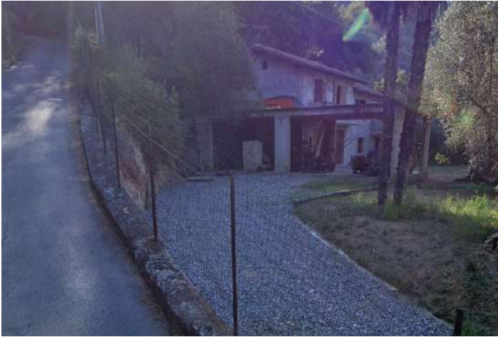
Il fabbricato e l'accesso carraio
