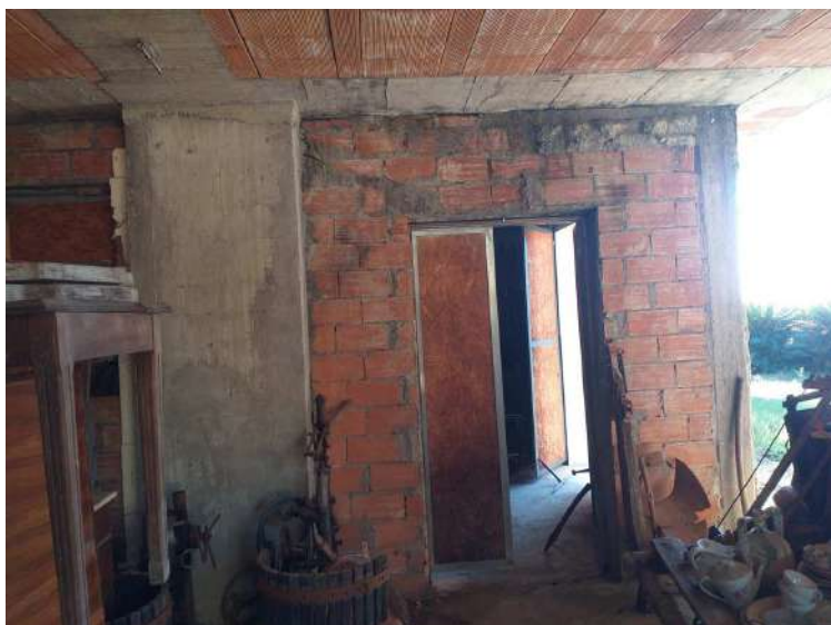
Piano seminterrato: residenziale al grezzo
