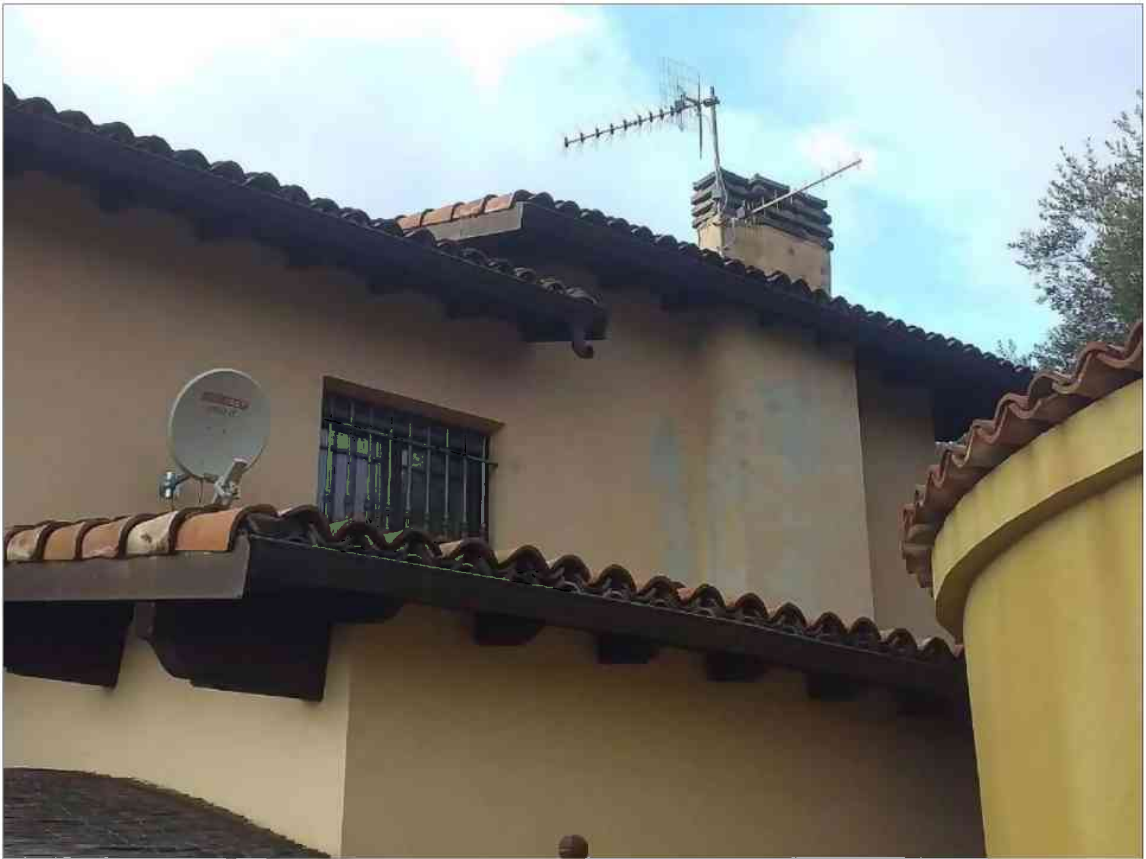
Particolare prospetto est
