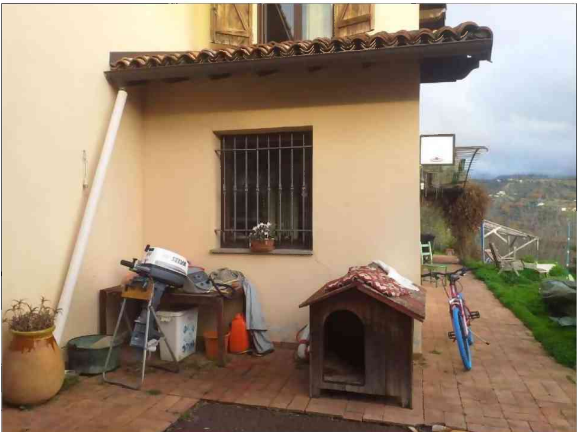
Particolare prospetto ovest
