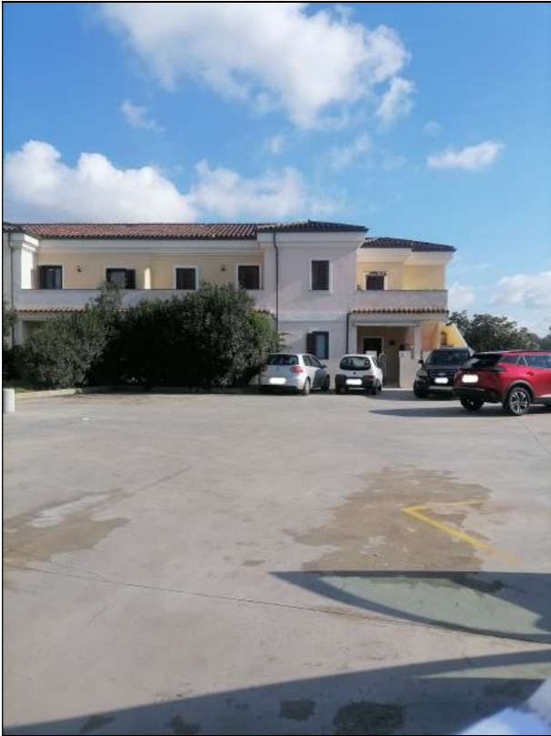
Foto 1: ingresso parcheggio condominiale
