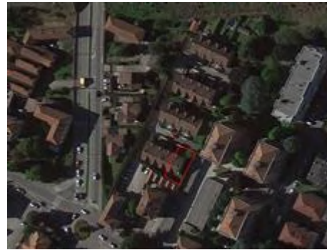
Vista aerea complesso edilizio
