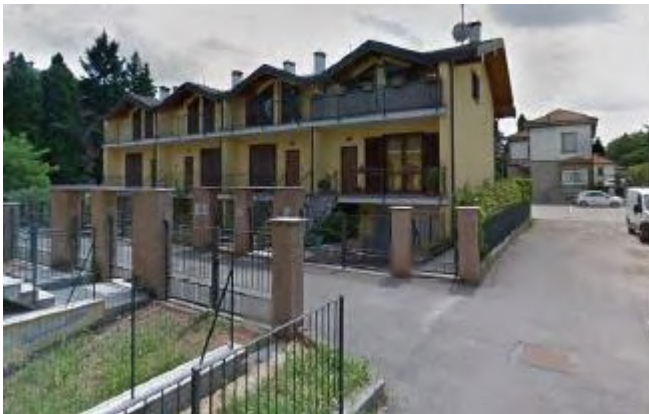
Vista da strada privata comune (sub. 501) - Fronte nord fabbricato
