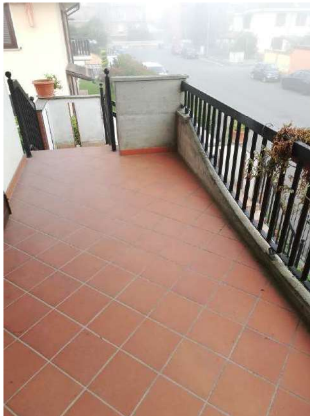
foto 8 – vista balcone fronte Nord P.1°.
