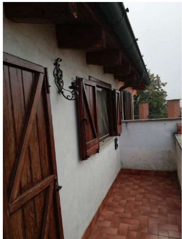
foto 18 – vista balcone fronte Sud P.2°.
