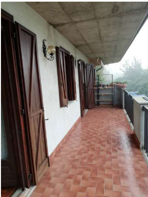
foto 9 – vista balcone fronte Sud P.1°.
