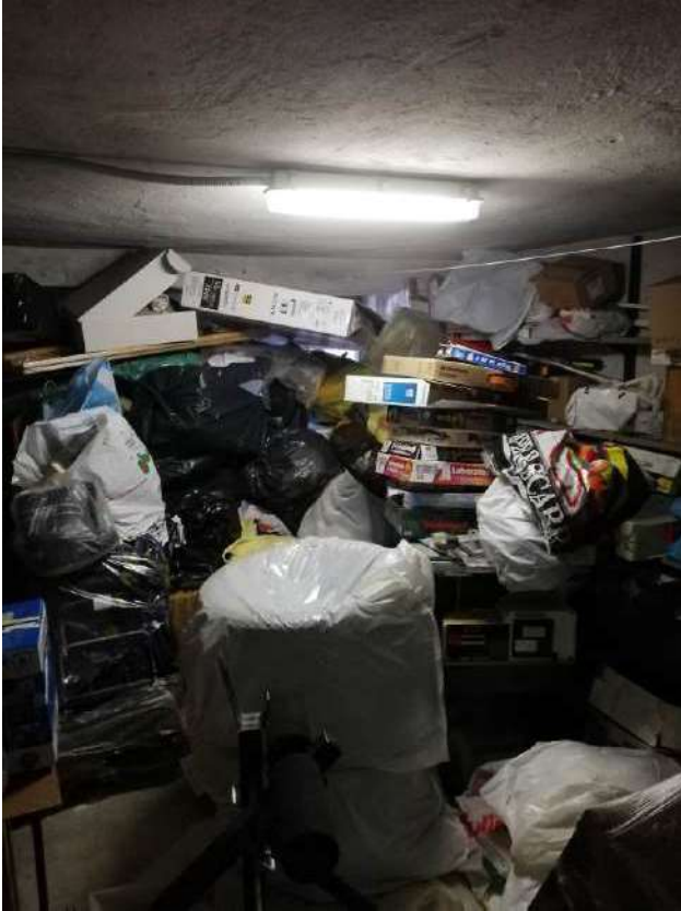
foto 37 – vista cantina P.S.
