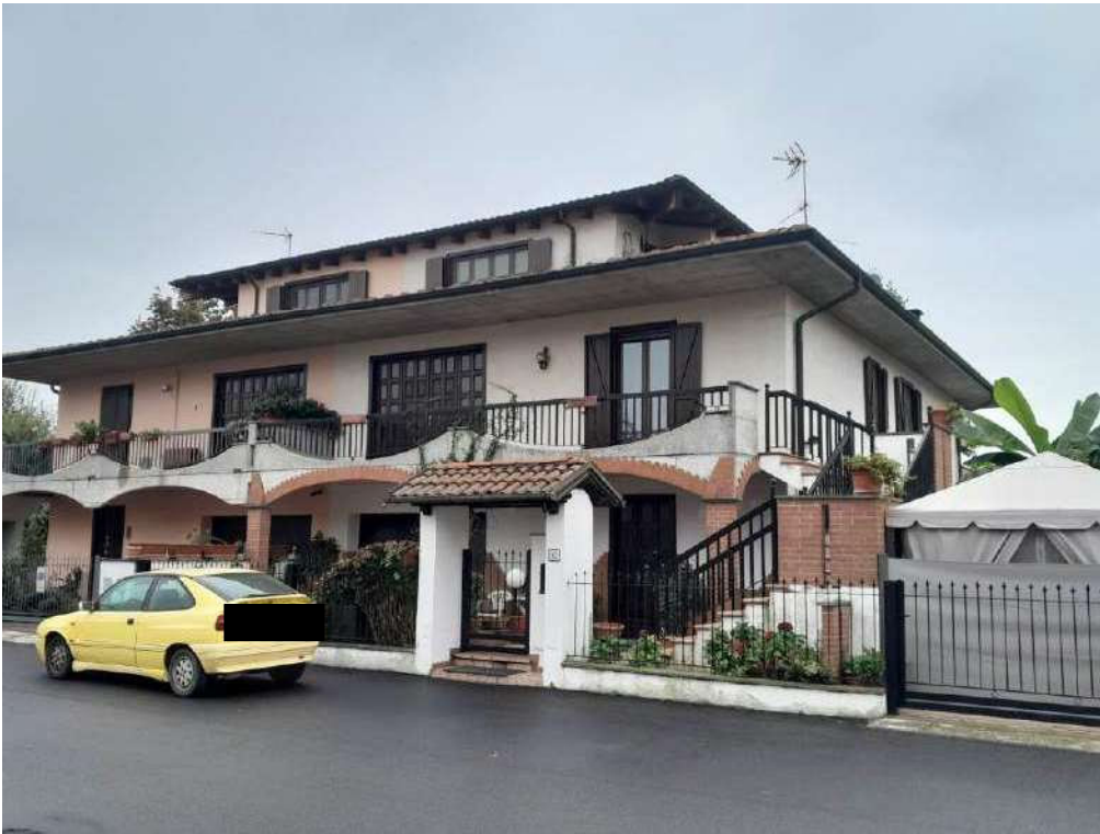
foto 1 – vista esterna dell'immobile.
