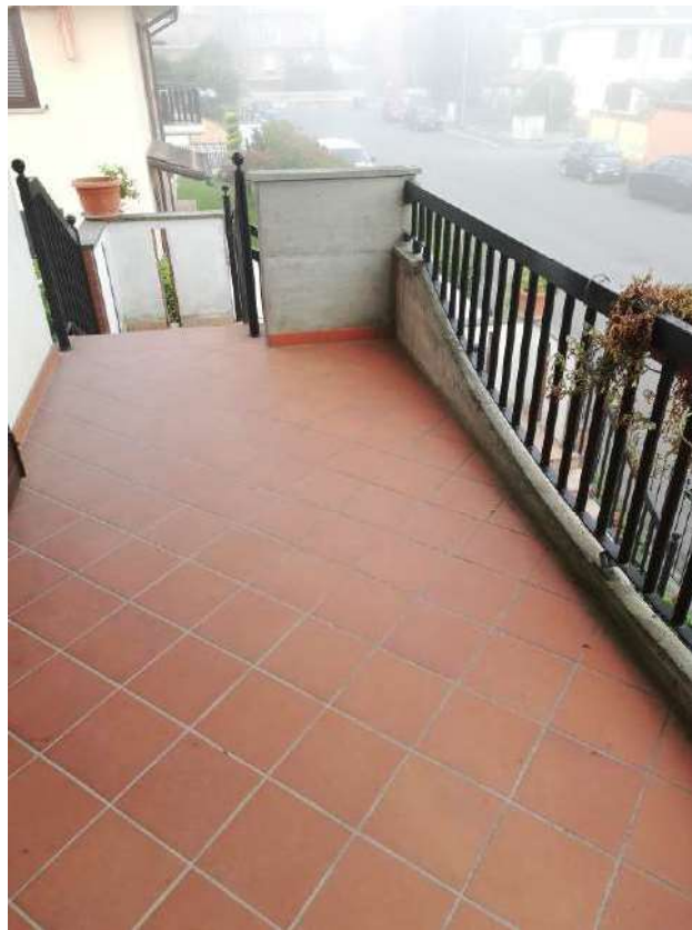
foto 8 – vista balcone fronte Nord P.1°.
