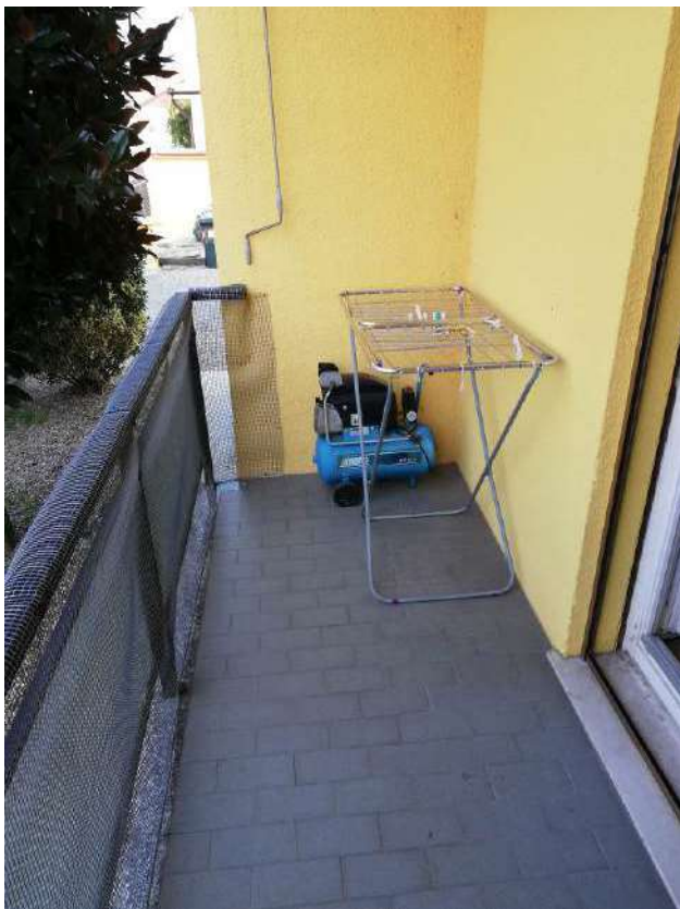
foto 35 – vista balcone fronte Ovest.
