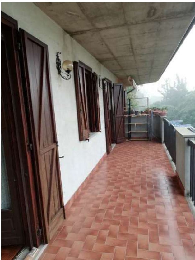
foto 9 – vista balcone fronte Sud P.1°.
