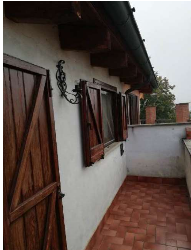
foto 18 – vista balcone fronte Sud P.2°.
