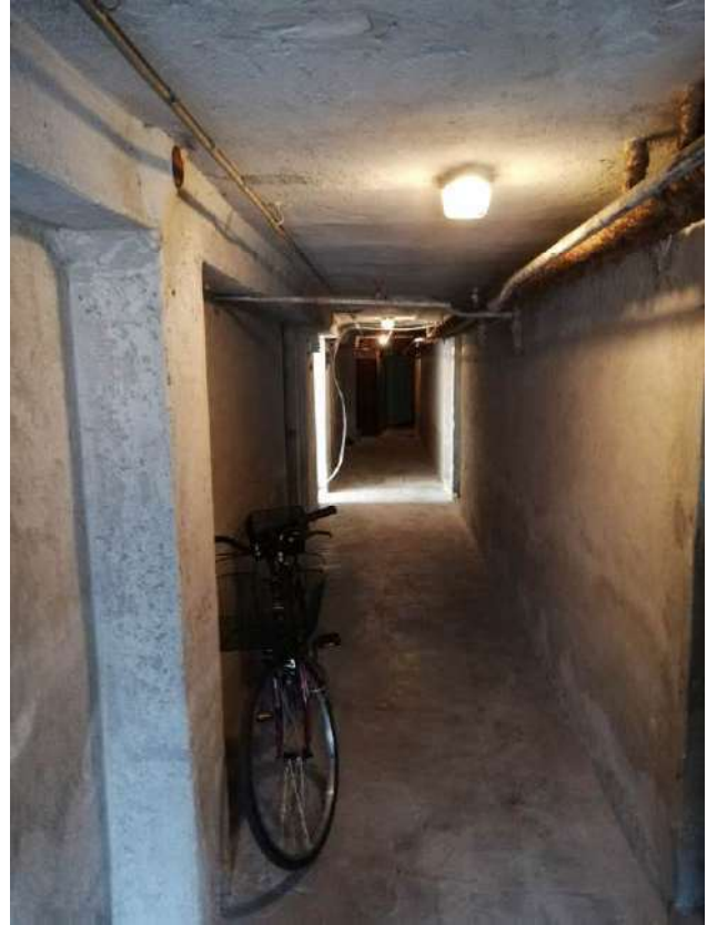
foto 38 – vista parti comuni cantine P.S.
