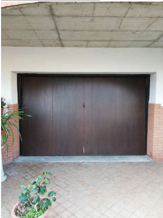
foto 23 – vista esterna immobile P.T.
