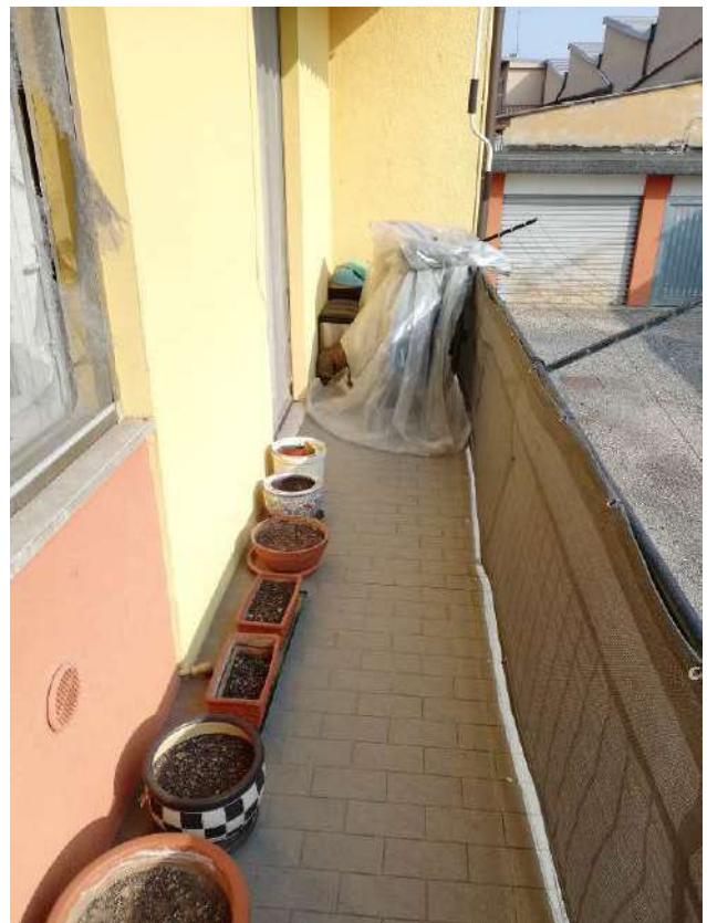
foto 36 – vista balcone fronte Est.
