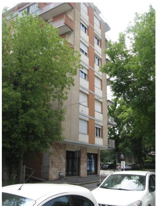
Scorcio via Turchi e ingresso piano seminterrato
