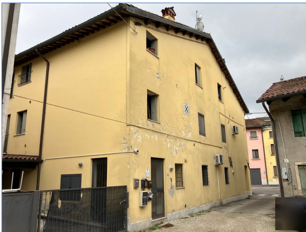
Foto 2 : Particolare ingresso dalla corte
