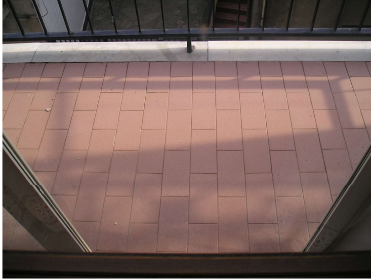
Foto n. 18: particolare balcone - immobile 2
